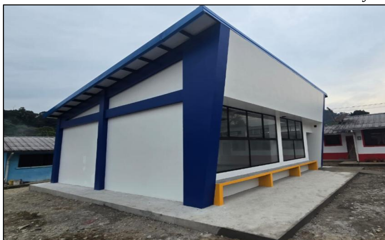
Imagen 6. Construcción de aulas en la institución educativa Isidro Ayora
