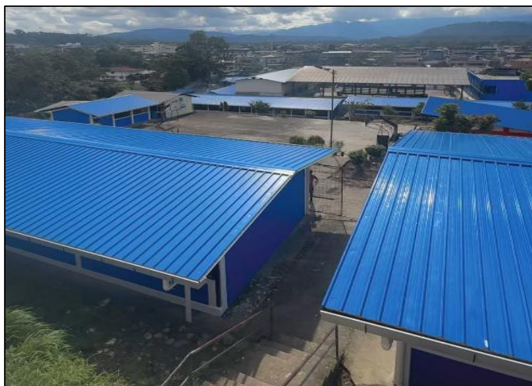
Imagen 7. Mantenimiento de la Unidad Educativa Ciudad de Tena
