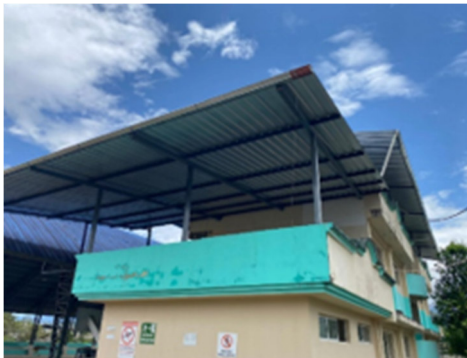
Ilustración 16: Colocación del material de construcción en la IE Héroes de Paquisha
