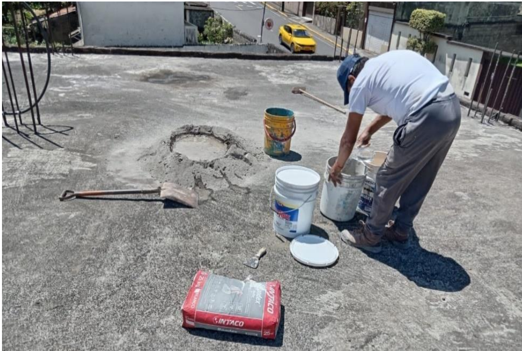
Foto 1 MANTENIMIENTO DE CUBIERTAS EN LA UE BAÑOS - SEDE 1
