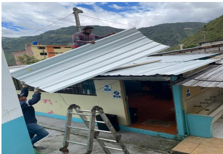
Foto 4 Mantenimiento techo metálico CEI. LUCERITO
