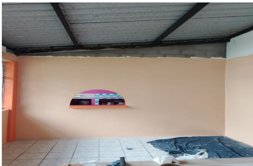
Foto 2 MANTENIMIENTO DE MAMPOSTERÍA DEL BAR DE LA UE PALOMINO FLORES
