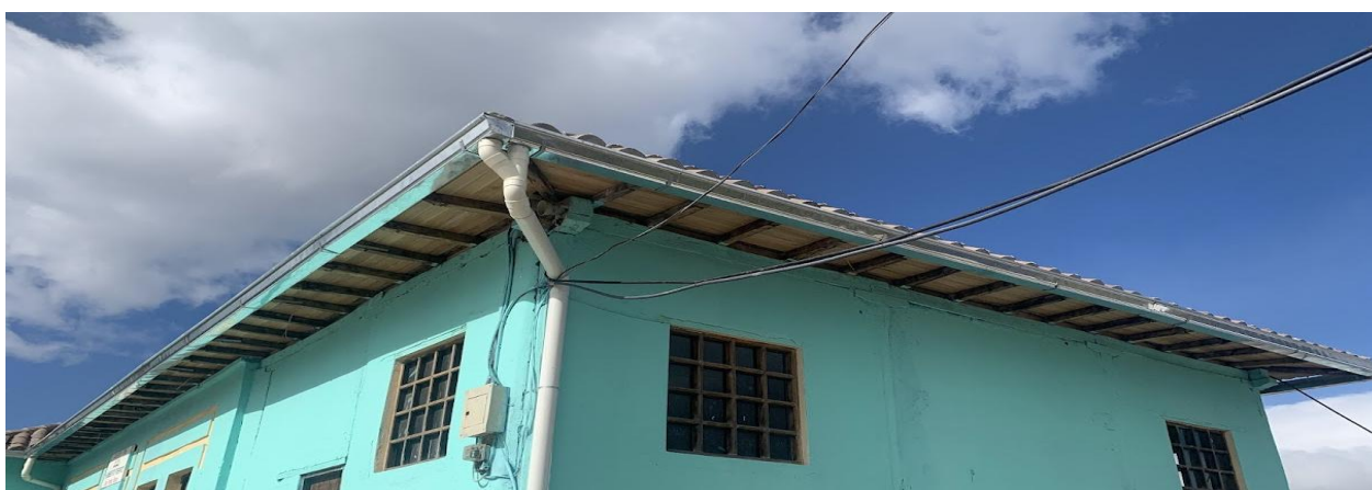
CUBIERTA RESTAURADA TOTALMENTE FUNCIONAL
