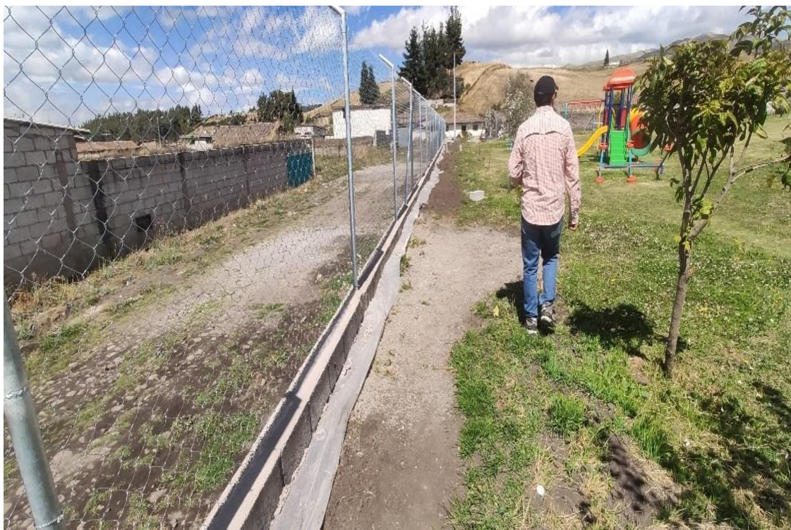
1. CONSTRUCCION DE UN MURO DE CONTENCIÓN PARA LA UECIB GENERAL ANTONIO ELIZALDE.
