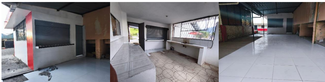
Fotografía 30. Mejoramiento del área del bar de la Unidad Educativa Enrique Avelino Silva
