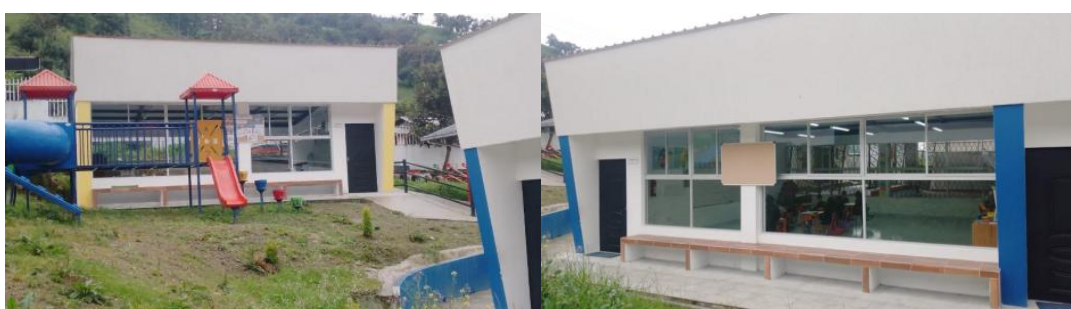
Fotografía 29. Construcción de Aulas, batería sanitaria y juegos infantiles
