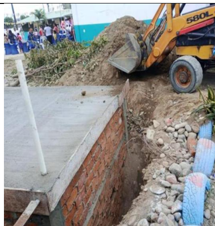
CONSTRUCCIÓN DE POZO SÉPTICO EN UE. ABDÓN CALDERÓN
