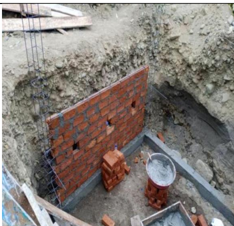
CONSTRUCCIÓN DE POZO SÉPTICO EN UE. ABDÓN CALDERÓN
