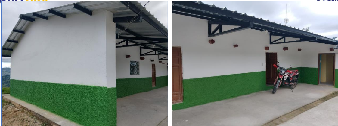
Ilustración 8: Mantenimiento de la EEB. Aguinaldo Castillo.
