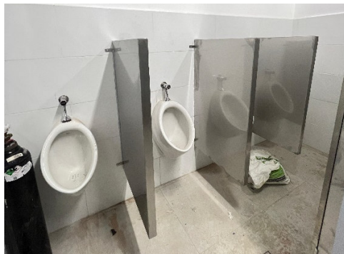
Ilustración 8: Urinarios de la batería sanitaria.
