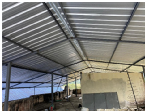
Ilustración 17: Colocación de cubierta en todo el edificio de la IE Héroes de Paquisha.
