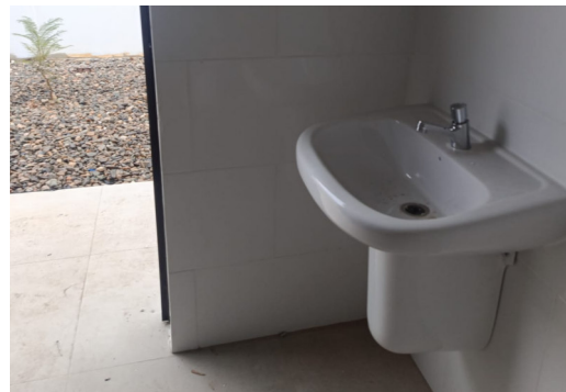
Ilustración 9: Lavamanos en el baño individual.
