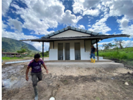
Ilustración 10: Batería Sanitaria terminada en el año 2025, a través de Administración Directa
