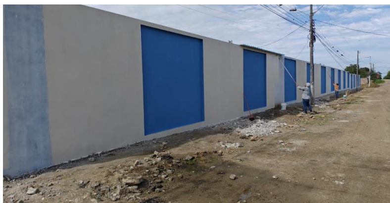
Ilustración 10. Cerramiento de la Unidad Educativa Las Brisas.
