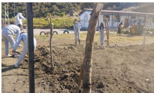
Preparación de los terrenos
