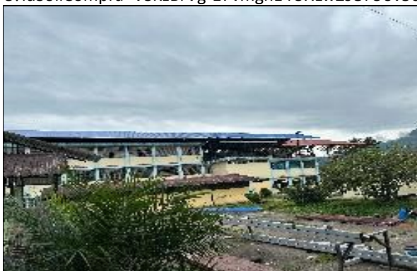
FOTOGRAFÍA 15. COLEGIO DE BACHILLERATO "PRIMERO DE MAYO" – IMPERMEABILIZACIÓN DE 3 BLOQUES DE AULAS A TRAVÉS DE COLOCACIÓN DE CUBIERTAS INCLINADAS.
