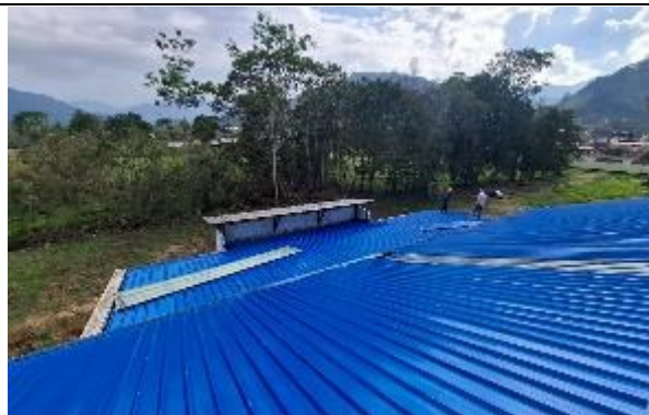
FOTOGRAFÍA 21. DIRECCIÓN DISTRITAL 19D04 EL PANGUI YANTZAZA EDUCACIÓN – IMPERMEABILIZACIÓN DE LOSA CON CUBIERTAS METÁLICAS.
