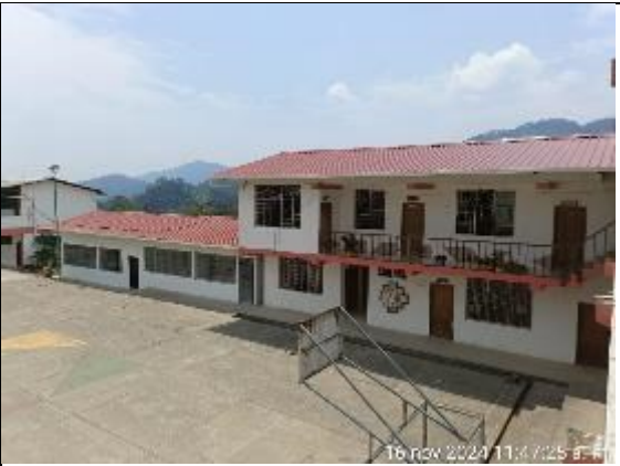
FOTOGRAFÍA 4. CECIB “CIUDAD DE AMBATO” – AMPLIACIÓN VERTICAL CON AISLAMIENTO TÉRMICO Y CAMBIO DE CUBIERTAS DE DOS AULAS TIPO, IMPERMEABILIZACIÓN MEDIANTE CUBIERTA METÁLICA EN BLOQUE ADMINISTRATIVO. FUENTE: ADMINISTRACIÓN ESCOLAR
