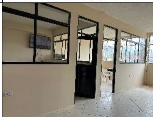
FOTOGRAFÍA 20. COLEGIO DE BACHILLERATO "PRIMERO DE MAYO" - DIVISIÓN DE INSPECCIÓN MEDIANTE MAMPOSTERIA DE GYPSUM, EN EL BLOQUE 11.
