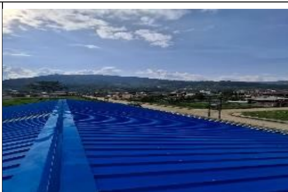
FOTOGRAFÍA 22. DIRECCIÓN DISTRITAL 19D04 EL PANGUI YANTZAZA EDUCACIÓN – IMPERMEABILIZACIÓN DE LOSA CON CUBIERTAS METÁLICAS.
