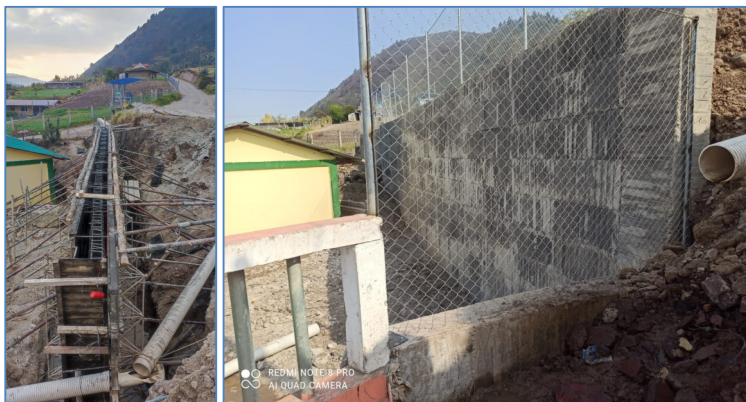
Ilustración 4: Construcción de muro de contención CECIB. Francisco Terán
