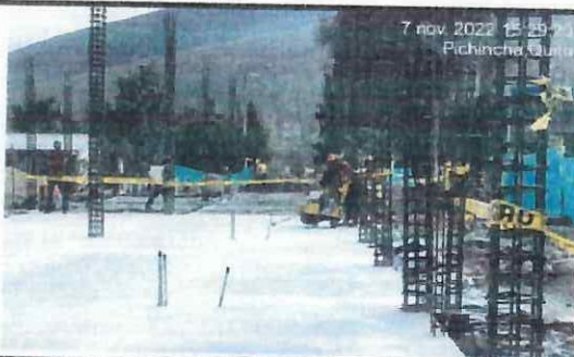
Juntas de dilatación en ejes A - G
