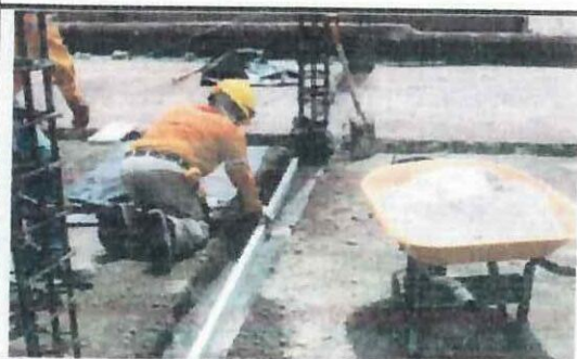
Colocación de cama de arena de 3cm.
