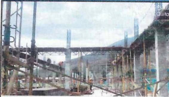
Encofrado de columnas en ejes A - G (1 - 3).
