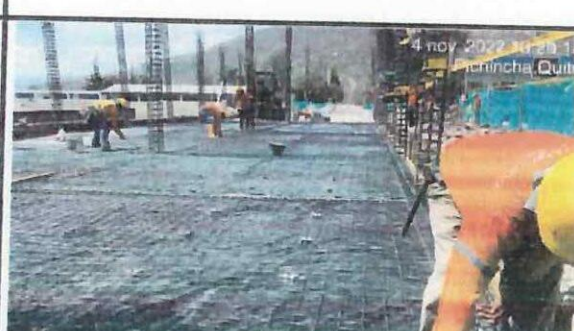
Colocación de malla electrosoldada para contrapiso en eje C - G (1 - 2 - 3).
