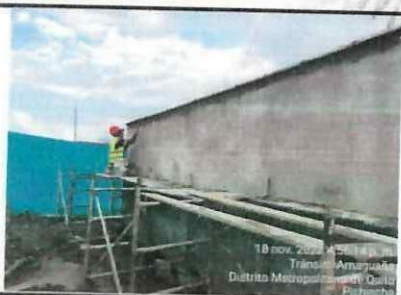
Colocación de alfeizer en cerramiento
