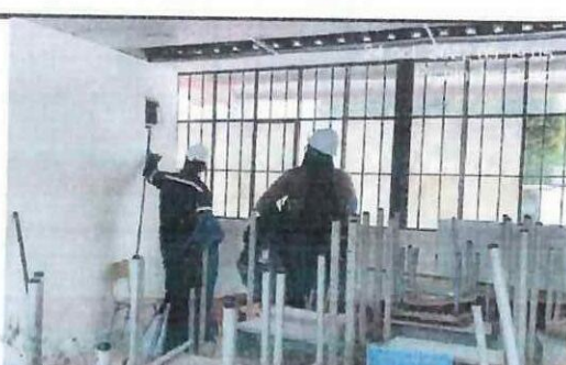
Implementación de circuitos de tomacorriente, tubería en bloque 32
