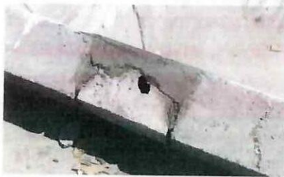
Resane De bloque de borde de losa B5
