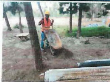
Nivelación de suelo natural en relleno de zanja de alcantarillado ✓
