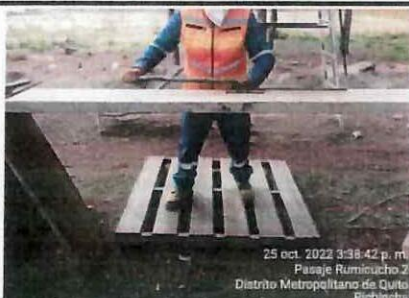
Armado de estribo para el traslape de columnas del pluro de cerramiento
