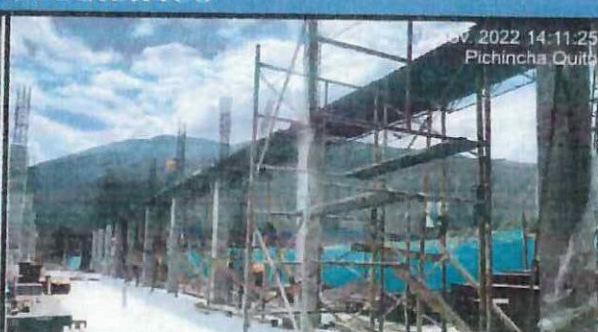
Encofrado de vigas y columnas en eje A - G (1 - 3)
