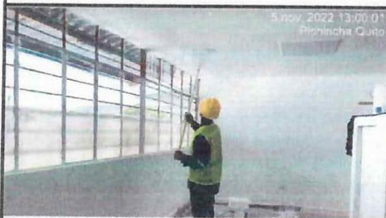
Pintura interior en bloque 26. (segunda mano).
