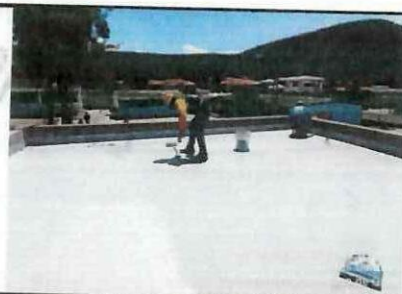
Impermeabilización en losa de cubierta bloque 5 - tercera mano, bloque 4- refuerzo.
