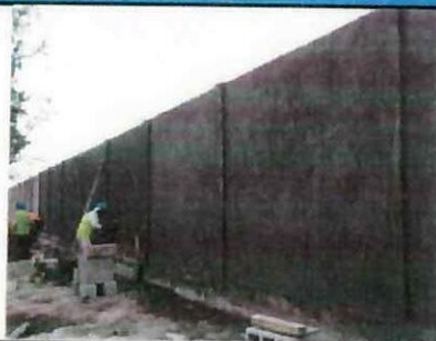
Corrección de nivel de mampostería mediante enlucido, cara interior
