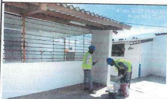
Empaste exterior en bloque 26 - segunda capa.
