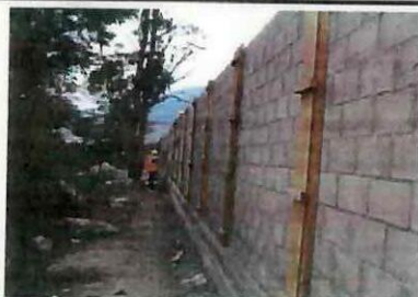
Encofrado y armado de acero de refuerzo de columnas
