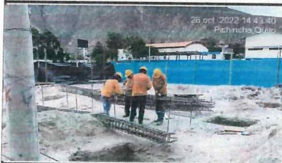
Armado y amarrado de columnas.
