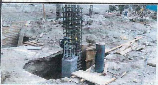
Desenfrado de cuello de columnas en ejes (A - G)
