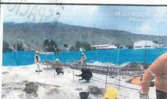
Armado de columnas
