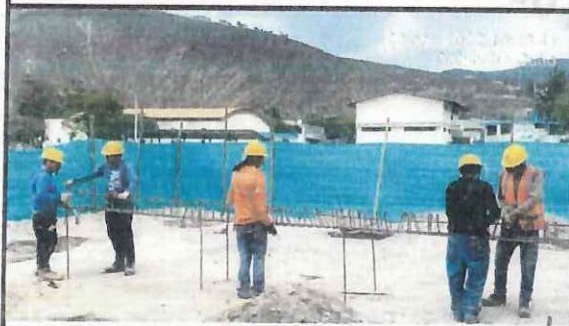
Armado de columnas
