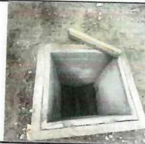
Masillado de chafán en cajas de revisión de alcantarillado ✓
