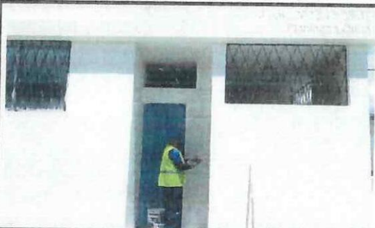
Empaste exterior en bloque 29, segunda capa.
