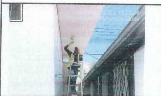
Empaste exterior en tumbado de bloque 35
