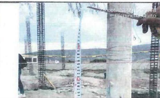
Verificación de alturas de plintos con fiscalización.
