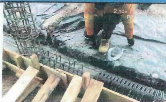
Armado de hierro de cadenas
