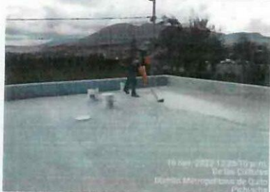
Impermeabilización en losa de cubierta bloque 4- 3era mano, bloque 10 - 4ta mano, bloque 12 refuerzo. ✓
