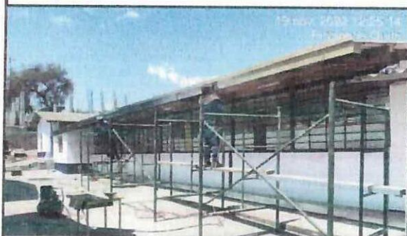
Instalación de canalones en bloque 26.
