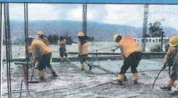
Fundición de contrapiso en eje G' - M. ✓
