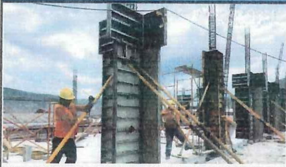
Encofrado de columnas en eje A - G (1 - 2 - 3). ✓
