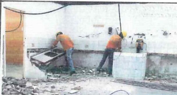
Derrocado de mesones en bloque 19 panadería.
