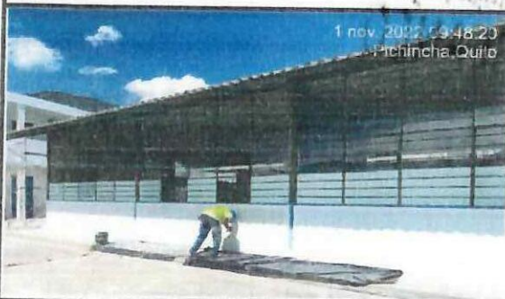
Empaste exterior en bloque 28. (segunda capa).
