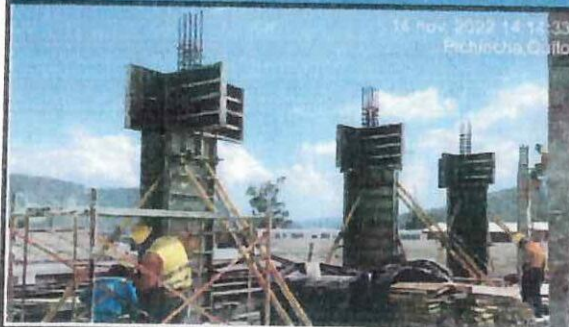
Encofrado de columnas en eje A - E (3).
