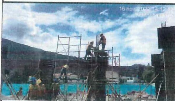
Fundición de columnas en eje K - L - M (5 - 6).
