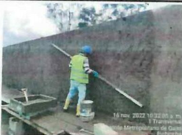
Corrección de nivel de mampostería en cerramiento mediante enlucido ✓
