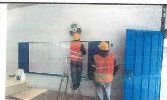
Cambio de piezas de interruptores y tomacorrientes en bloque 21 - 25 - 28.
