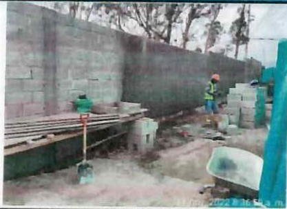
Corrección de nivel de mampostería en cerramiento mediante enlucido, cara exterior e interior ✓
