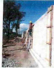
Encofrado de columnas tramo 3,4,5,6 y 7 cerramiento exterior
