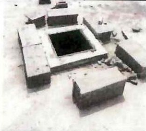
Resane de filos en paredes de tragajuz B11
