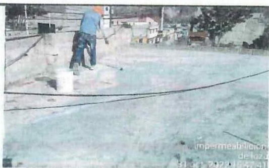
Impermeabilización de cubierta en bloque 35.
