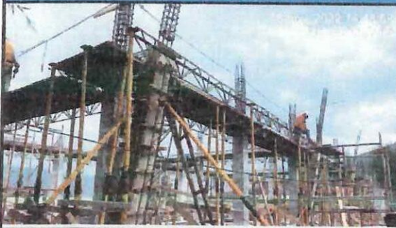
Armado de vigas en eje A - G (1 - 2 - 3).
