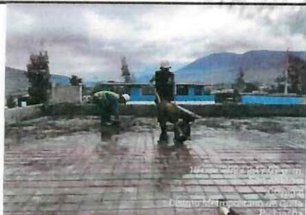
Masillado de losa de cubierta bloque 4 para corrección de pendiente ✓
