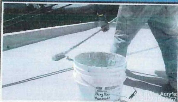
Impermeabilización de cubierta en bloque 29.
