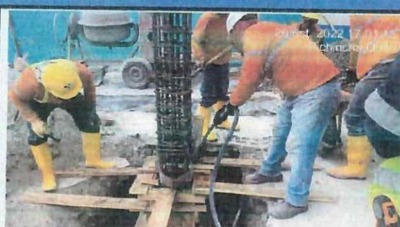
Fundición de cuello de columnas en ejes (A - G).
