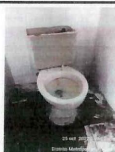
Desmontaje de piezas sanitarias restantes bloque 12
