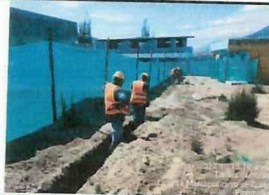
Excavación de zanja de canalización eléctrica
