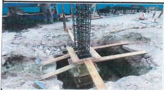
Encofrado de cuello de columnas en ejes (G' - M)
