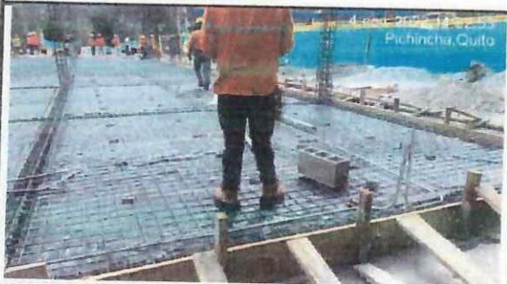
Instalación de tubería conduit en eje A - G.
