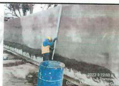
Corrección de nivel de mampostería en cerramiento mediante enlucido, cara exterior ✓
