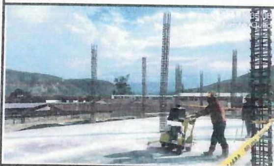
Juntas de dilatación en ejes A - G.
