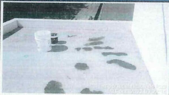
Impermeabilización de cubierta en bloque 29.
