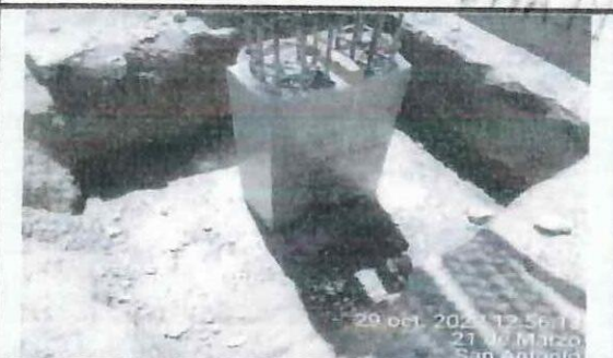
Desencofrado de cuello de columnas en eje G - M
