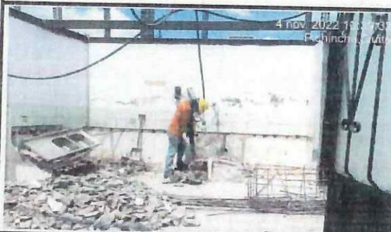
Derrocado de mesones en bloque 19 panadería.
