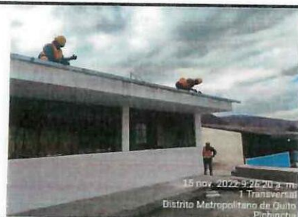
Enlucido de filos y fajas en losa de cubierta, bloque 5 ✓
