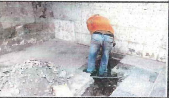
Retiro de tubería existente en bloque 19 (panadería). ✓
