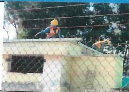
Enlucido de filos de antepecho en losa de cubierta - bloque 12
