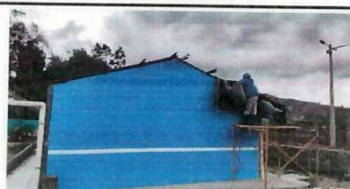
Colocación de plástico negro B6
