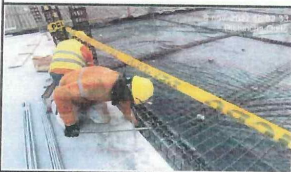
Colocación de plástico en eje G' - M (1 - 2 - 3).
