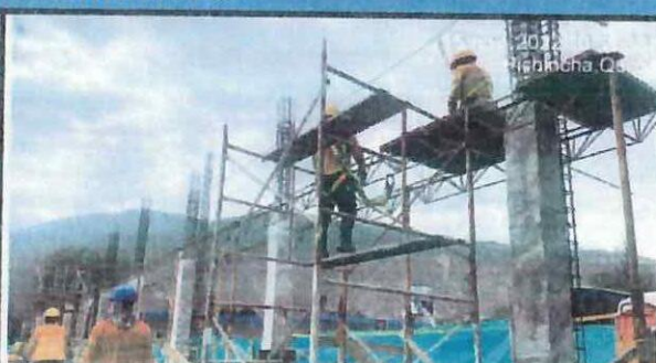
Encofrado de vigas en eje A - G (1 - 2 - 3).
