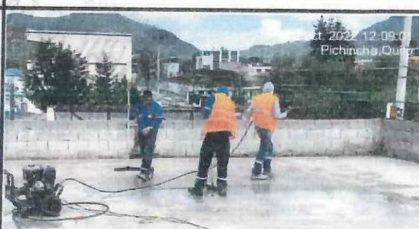
Impermeabilización de cubierta con membrana líquida en bloque 27-1 y bloque 29
