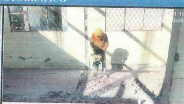
Derrocado de piso en bloque 19 (panadería).
