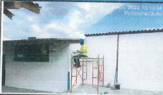
Empaste exterior en bloque 32, segunda capa.
