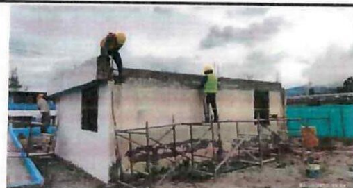
Resane de filo de losa Posterior B4
