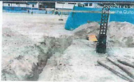
Excavación para alcantarillado de tubería en eje M - K (4 - 5 - 6).
