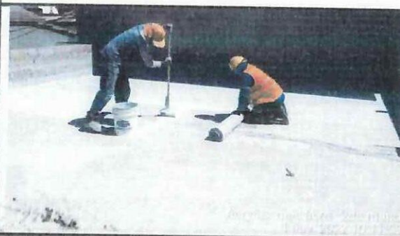
Impermeabilización de cubierta en bloque 33.
