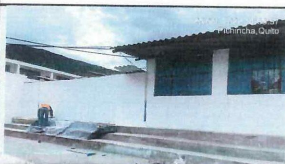
Pintura exterior primera mano en bloque 32.
