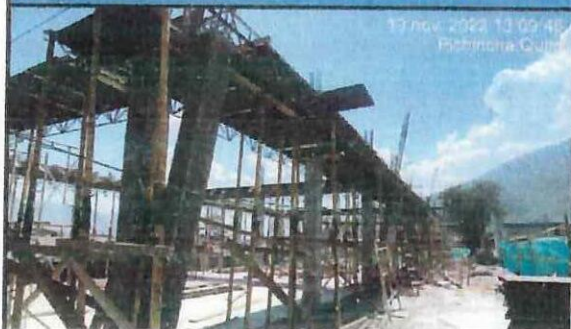
Desencofrado de columnas en eje A - G (3).
