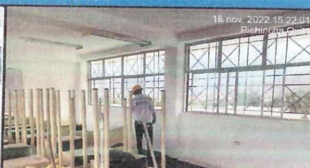
Lijado y empaste interior en bloque 18.
