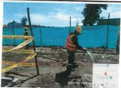
Control de polvo mediante riego de agua con tanquero.
