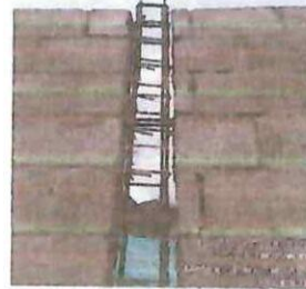
Traslape de varilla y estribo en columna del cerramiento externo
