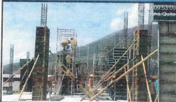
Fundición de columnas H - I - J (1 - 2 - 3).
