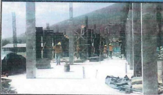
Desenfofrado de columnas en eje G' - M.
