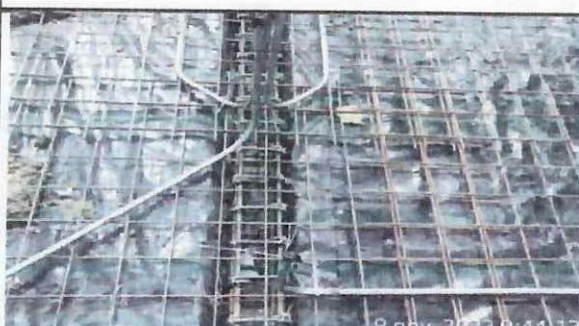
Instalación de tubería conduit en tramo de eje G' - M. ✓
