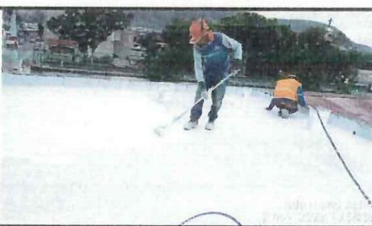
Impermeabilización de cubierta en bloque 35.
