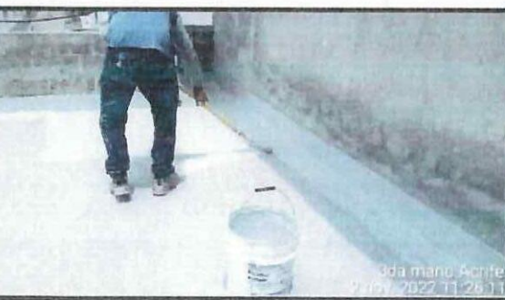
Impermeabilización de cubierta en bloque 33.
