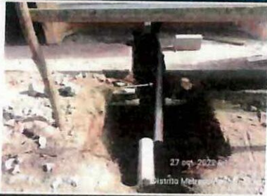
Instalación de tubería de desagüe y accesorios B12
