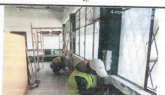
Colocación de malla electrosoldada para contrapiso en eje C - G (1 - 2 - 3).
