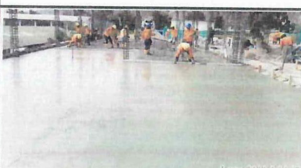
Alisado de contrapiso en eje G' - M. ✓
