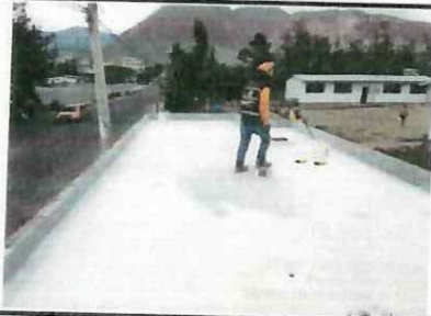
Impermeabilización en losa de cubierta bloque 10,11 -cuarta mano. ✓
