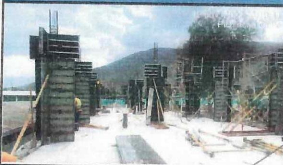
Encofrado de columnas en eje G' - M.
