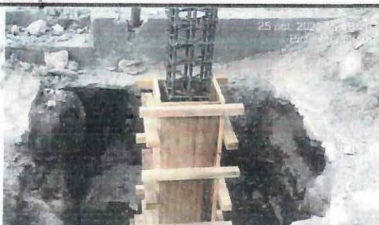
Encofrado de cuello de columnas.
