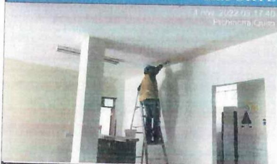
Empaste interior en bloque 27 - segundo piso.
