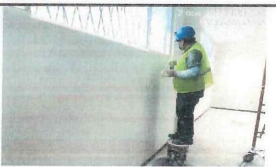
Pintura interior en bloque 29. (primera mano).
