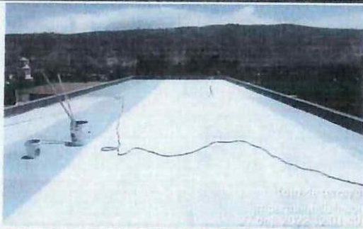
Impermeabilización de cubierta con membrana líquida en bloque en bloque 29
