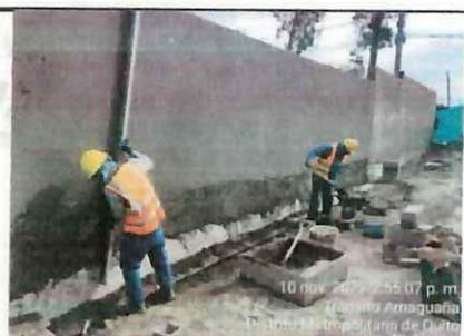
Corrección de nivel de mampostería mediante enlucido, cara exterior ✓
