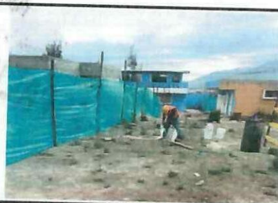
Tizado de zanja de canalización eléctrica. ✓
