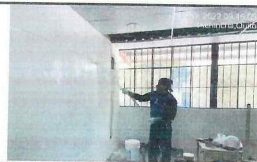
Pintura interior en bloque 32 (primera mano).
