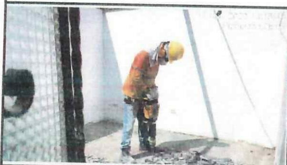
Derrocamiento de piso en bloque 19 panadería.
