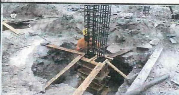
Encofrado de columnas en eje (G).
