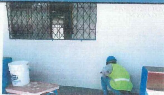
Empaste exterior en bloque 26, segunda capa.
