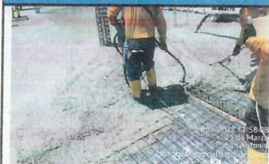
Fundición de contrapiso en eje A - G'
