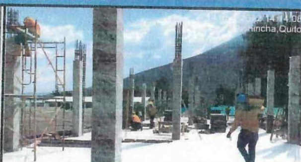
Desencofrado de columnas en eje J - M (1 - 2 - 3).
