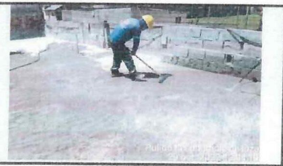
Impermeabilización en cubierta de bloque 33.
