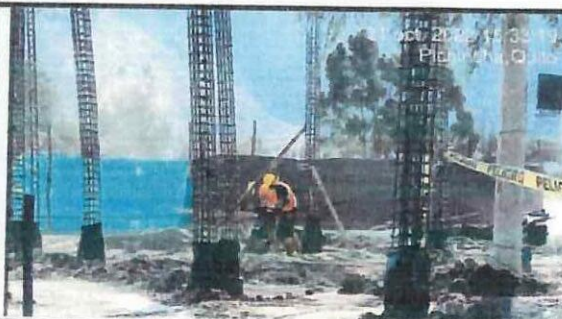
Relleno hidrocompactado con material de mejoramiento.
