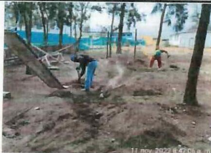
Relleno y compactación de zanja de alcantarillado, 2da capa ✓
