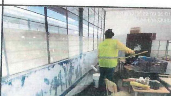
Pintura interior en bloque 28 - primera mano.
