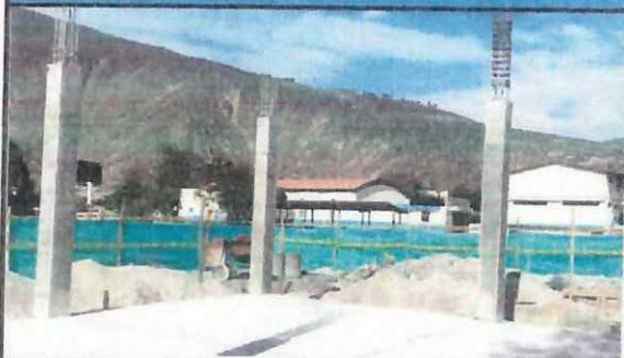
Desencofrado de columnas en ejes K - L - M (4 - 5 - 6).
