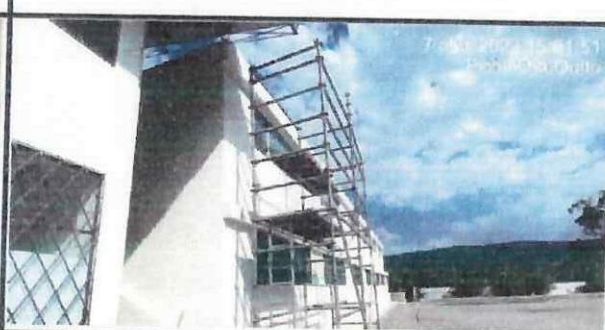
Empaste exterior en bloque 29 (segunda capa).
