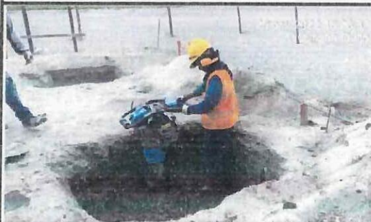
Compactación de suelo en plintos en eje (K - L - M) (4 - 5 - 6)
