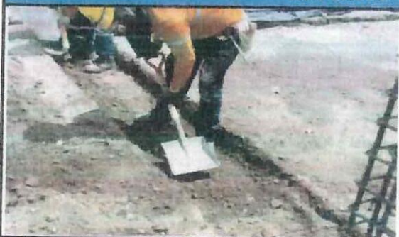
(CONFIRMACIÓN) Excavación de cadenas en eje A - G (1 - 2 - 3)
