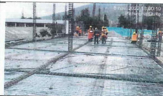
Colocación de malla electrosoldada para contrapiso en eje G' - M (1 - 2 - 3).
