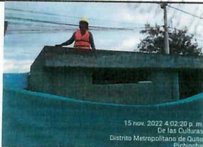
Enlucido de filos y fajas en losa de cubierta, bloque 11 ✓
