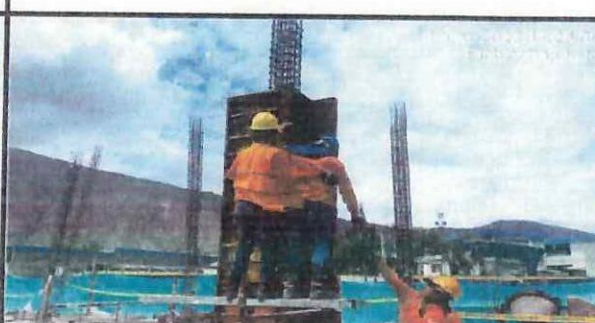
Encofrado de columnas en eje A - G. ✓
