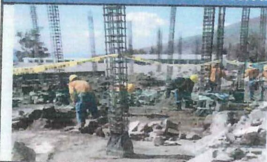
Relleno y compactación en los bloques B- H
