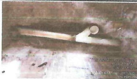
Colocación de tubería PVC para desagües B12.
