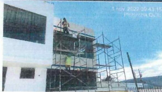
Empaste exterior en bloque 27 (primera y segunda capa).
