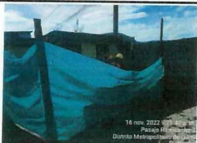
Colocación de yute en perímetro de bloque 11 ✓
