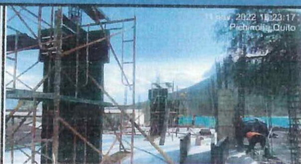
Encofrado de columnas en ejes G I - I - K - M (2).
