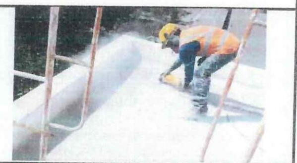
Impermeabilización en cubierta de bloque 29.
