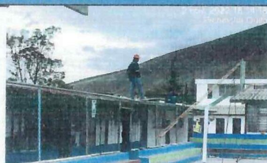
Instalación de canalones en bloque 32.
