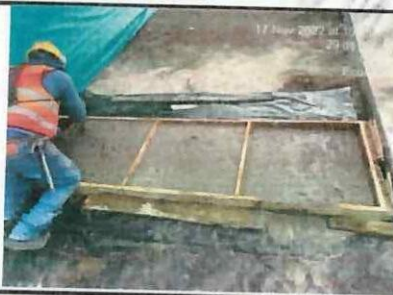
Encofrado y fundición de tapas de cajas de revisión de alcantarillado. ✓
