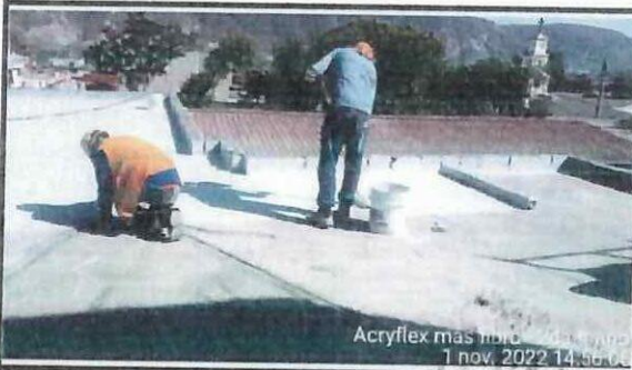
Impermeabilización de cubierta en bloque 35.
