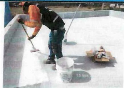
Impermeabilización en losa de cubierta, bloque 10 3era mano ✓
