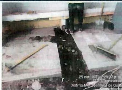
Picado de piso para la nueva red H.S. bloque 12
