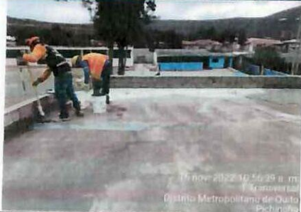
Impermeabilización en losa de cubierta, bloque 4 1era mano ✓
