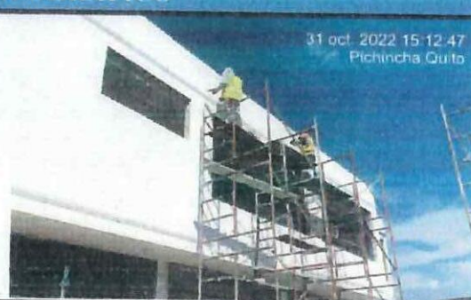
Empaste exterior (1ra y 2da mano) bloque 27.
