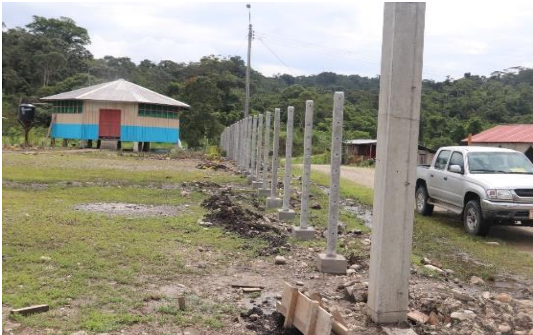
Ilustración 12: Cerramiento De Malla Del Perímetro Del Cecib Tiwiram, De La Comunidad Yayu
