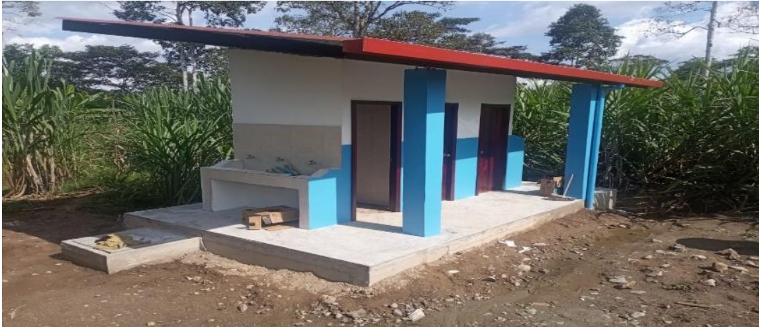
Ilustración 09: Baterías sanitaria intervenida de la Escuela De Educación Básica La Condamine.
