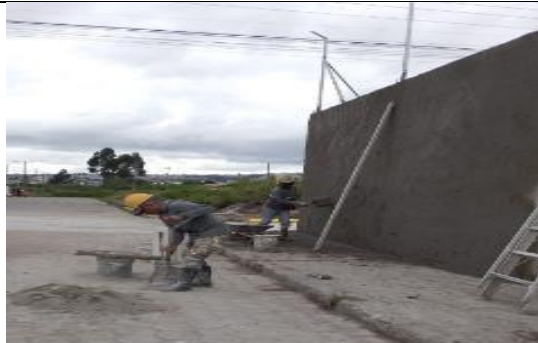
Fotografía 10: Enlucido de cerramiento de mampostería
