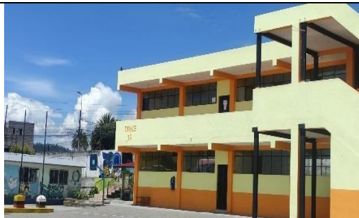
Fotografía 12: Finalización de mantenimiento de infraestructura Dr. Ricardo Cornejo
