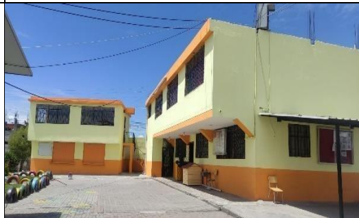
Fotografía 13: Finalización de mantenimiento de infraestructura Dr. Ricardo Cornejo
