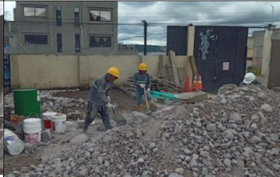
Fotografía 11: Retiro de escombros
