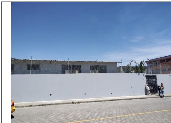
Fotografía 16: Finalización de mantenimiento de infraestructura Ec. Abdón Calderón
