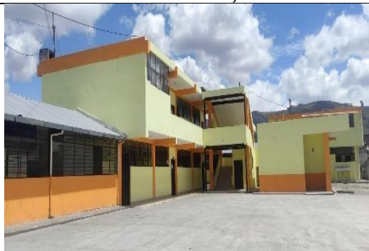
Fotografía 14: Finalización de mantenimiento de infraestructura Dr. Ricardo Cornejo
