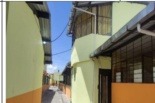
Fotografía 15: Finalización de mantenimiento de infraestructura Dr. Ricardo Cornejo
