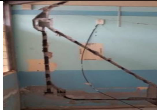
Fotografía 9: Picado y resane para instalaciones eléctricas
