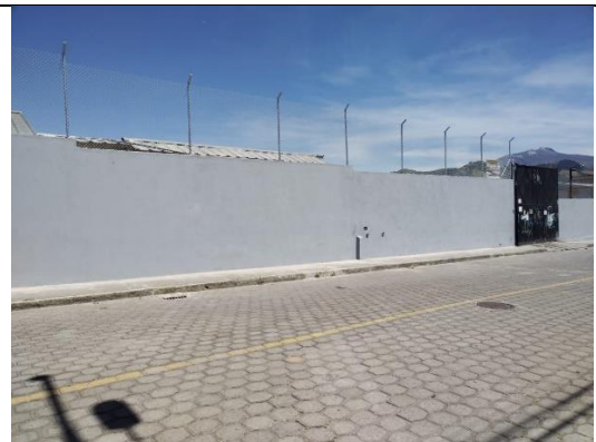
Fotografía 19: Finalización de mantenimiento de infraestructura Ec. Abdón Calderón
