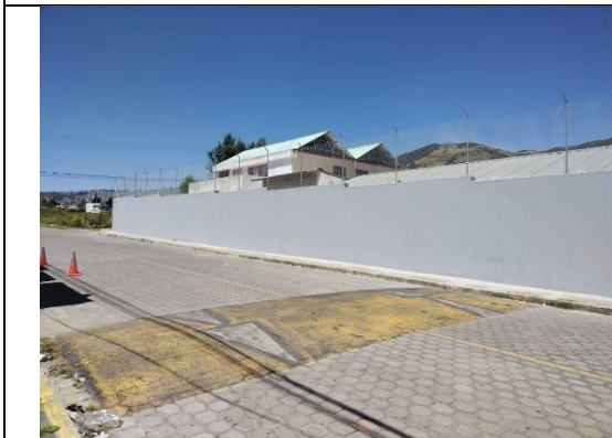
Fotografía 18: Finalización de mantenimiento de infraestructura Ec. Abdón Calderón
