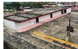
**Ilustración 40:** Impermeabilización y sellado de juntas bloque de educación inicial UE. Nanegalito.
