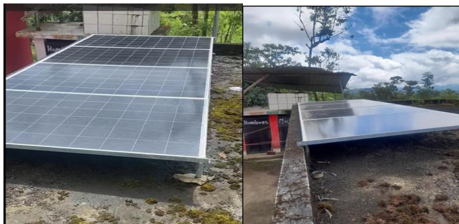
Ilustración 5: Instalación de Paneles Solares
