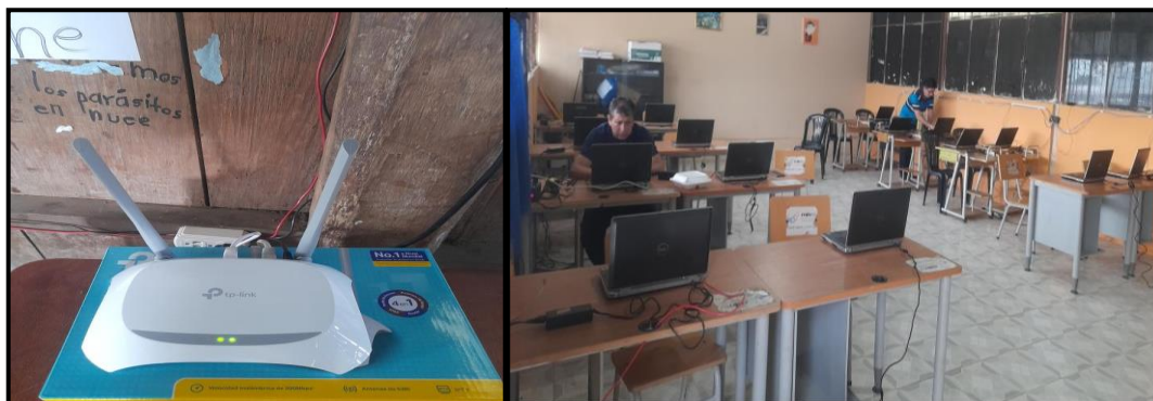
Ilustración 4: Instalación de servicio de Internet a IE
