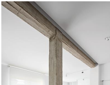
Unión viga-columna
