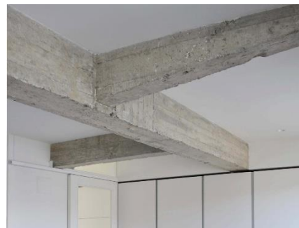
Unión viga-viga
