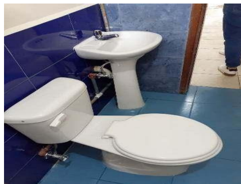
Imagen Nro. 29: CAMBIO PIEZAS SANITARIAS, CERAMICA PISO Y PARED
