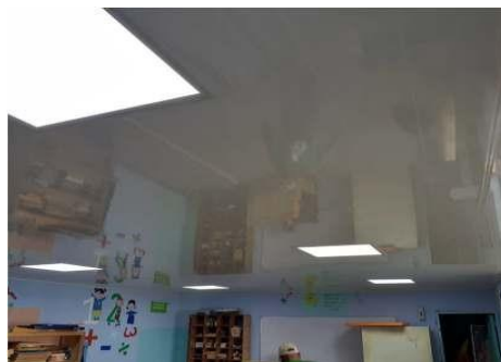
Imagen Nro. 47: COLOCACIÓN CIELO FALSO EN 2 AULAS
