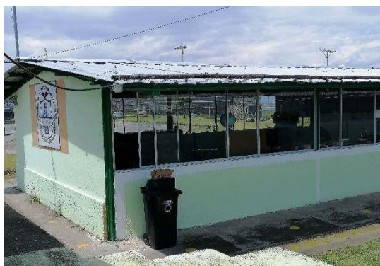
Imagen Nro. 36: CAMBIO DE CUBIERTAS EN 6 AULAS, BAJANTES Y CANALES
