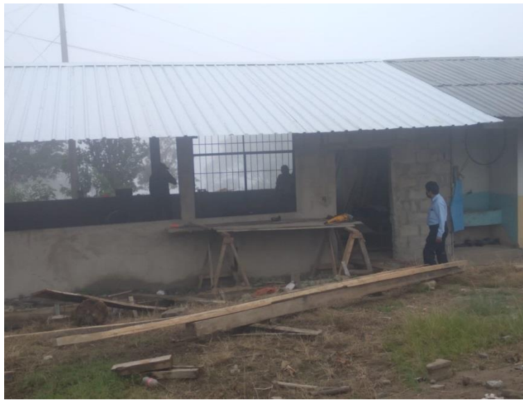
FOTO 2. ADECUACIONES INFRAESTRUCTURA EEB JOSE MARTIN GARCIA
