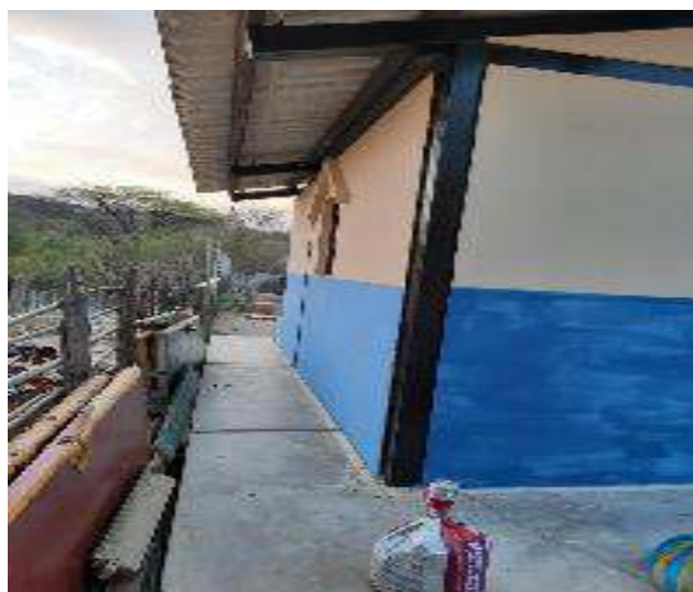
Figura 15. Baterías sanitarias después de intervención en “María Genoveva Ortíz”
