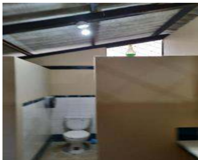
Figura 17. Interior de baterías sanitarias después de intervención en “María Genoveva Ortíz”
