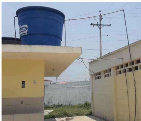
Figura 9. Tanque de almacenamiento de agua potable
