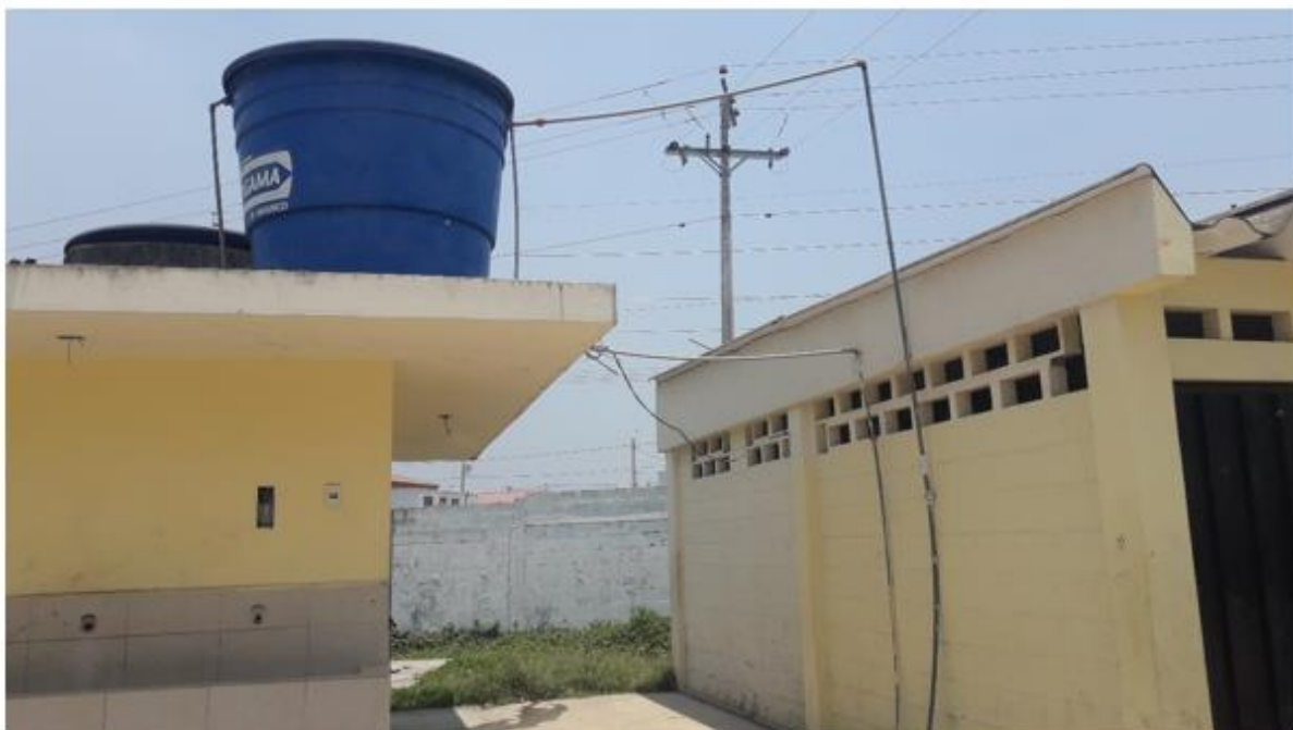
Ilustración 5. Tanque de almacenamiento y distribución de agua potable. Fecha: Viernes, 13 de septiembre del 2019. Autor: Ingeniera Jael Sarmiento
