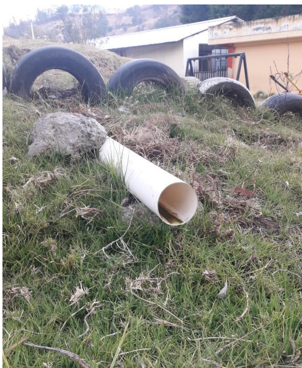
Ilustración 9. Descarga directa de aguas residuales al terreno posterior de la Unidad Educativa. Fecha: Jueves, 12 de septiembre del 2019. Autor: Ingeniera Jael Sarmiento
