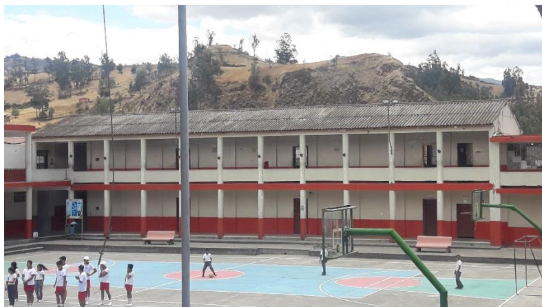
Ilustración 2. Presencia de techos Eternit en algunas estructuras de la Unidad Educativa. Fecha: Jueves, 12 de septiembre del 2019. Autor: Ingeniera Jael Sarmiento
