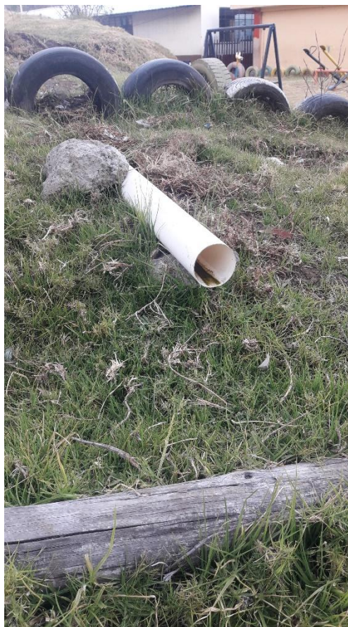
Figura 10. Tubería de descarga de aguas servidas Bloque 2
