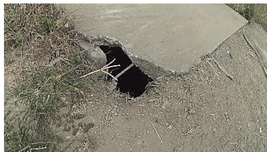
Foto No. 15. Vistas de pozo ciego de bloque administrativo por donde rebosan aguas servidas.
