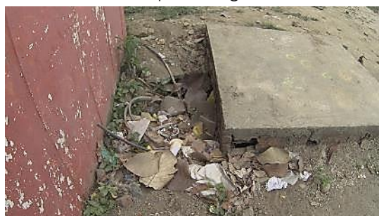
Foto No. 19. Pozo ciego con presencia de basura en su interior.
