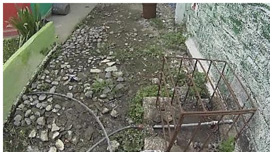
Foto No. 12. Vista de toma de agua sin medidor y con presencia de fugas permanentes.
