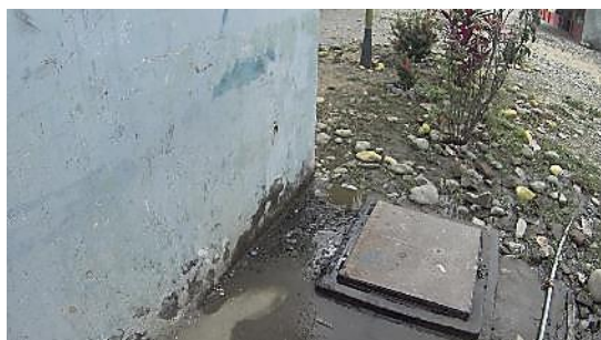
Foto No. 24. Cisterna del baño de mujeres, sin control de niveles, existe desperdicio de agua y no se conoce cuando recibió mantenimiento.
