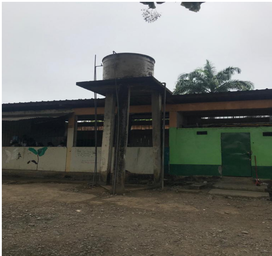
Foto 10. Abastecimiento de agua tanques y reserva elevados UEQ, en mal estado Fuente: Archivo fotográfico Ing. Gioconda Baldeón V.
