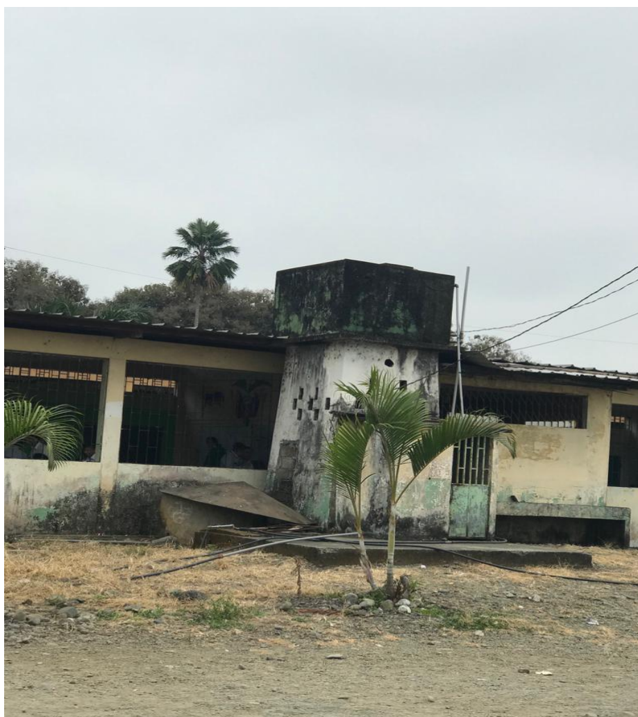
Foto 9. Abastecimiento de agua tanques de reserva elevados UEQ, insalubres Fuente: Archivo fotográfico Ing. Gioconda Baldeón V.
