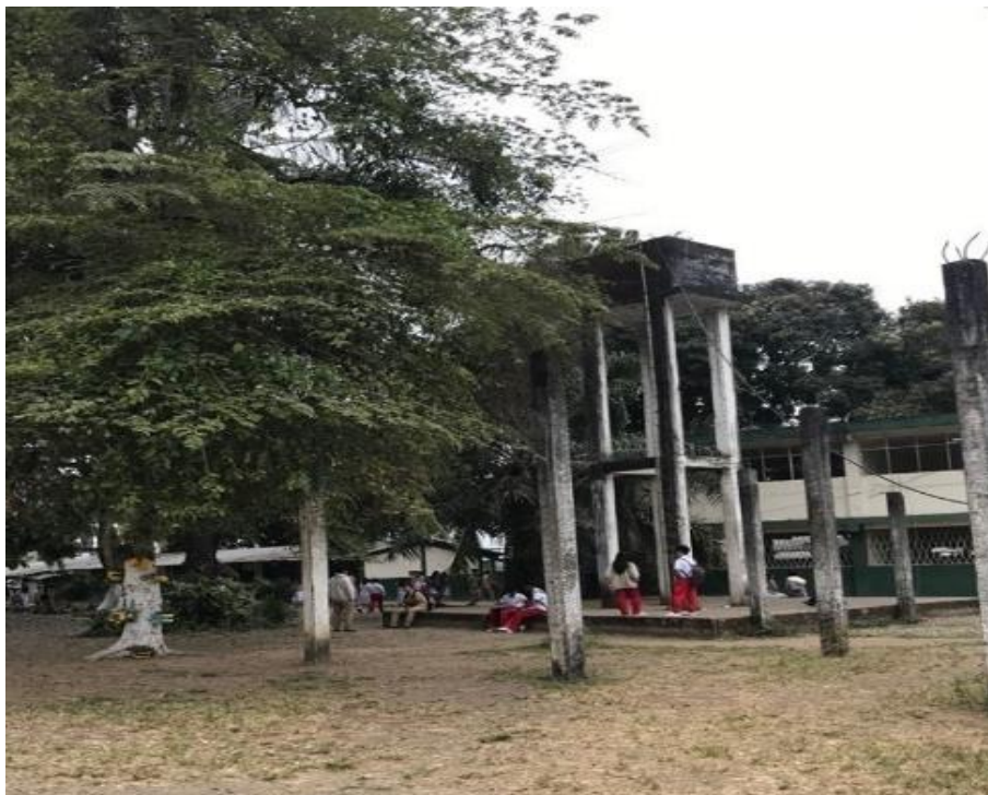
Foto 10. Abastecimiento de agua tanques y reserva elevados UENID, en mal estado Fuente: Archivo fotográfico Ing. Gioconda Baldeón V.
