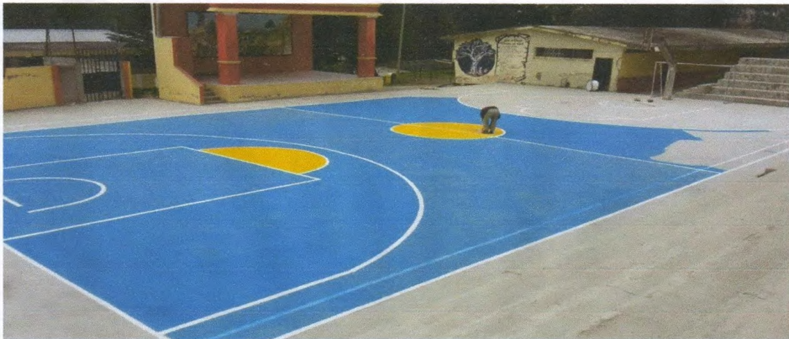
FOTO 2.- Reconstrucción de la cancha en la Unidad Educativa Federico González Suárez
