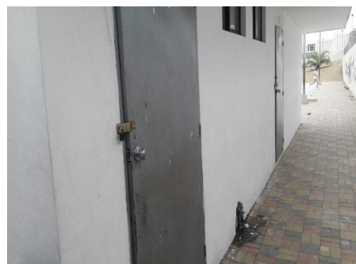
Mantenimiento de puertas
