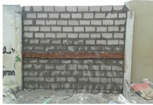
Mantenimiento de Paredes
