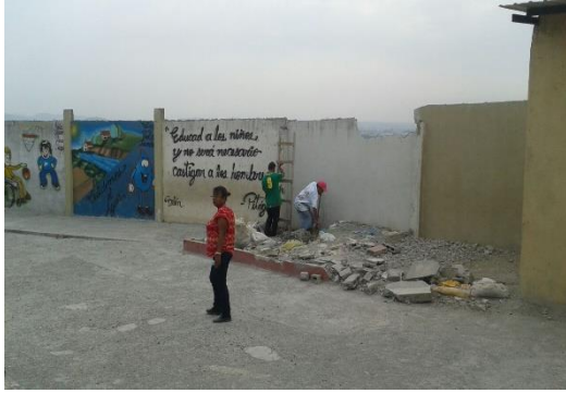
Mantenimiento de Paredes
