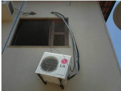
Ejemplo: un aire acondicionado de pared se encuentra en riesgo de caída
