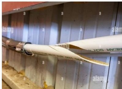
Ejemplo: Rotura de tubería de desagüe
