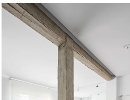
Unión viga-columna
