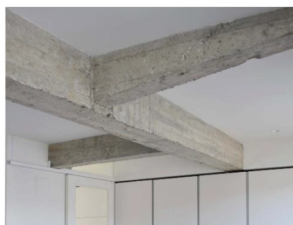
Unión viga-viga
