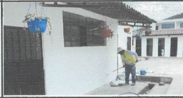
Pintura exterior en bloque 32. ✓
