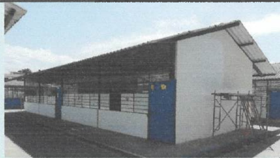
Empaste exterior de etapa 1 en bloque 21 - 25 - 28.
