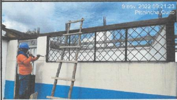
Desmontaje de puertas y ventanas en bloque 19 panadería. ✓
