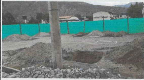
(Extensión de la Lona divisoria para trabajos de replanteo de plintos hacia la cancha de futbol para el aula 6 y 7 BLOQUE 19) ✓
