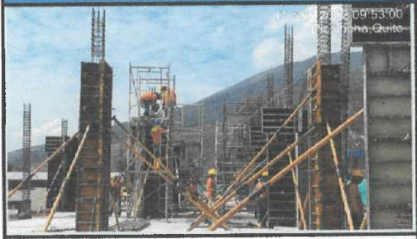
Fundición de columnas H - I - J (1 - 2 - 3).
