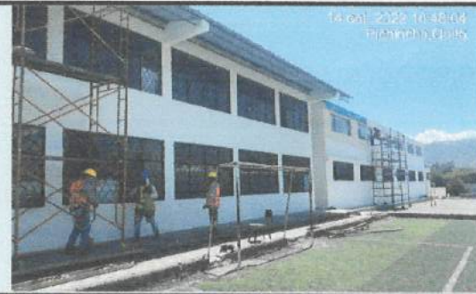
Empaste exterior en bloque etapa 1 ( Bloque 20 y 29)
