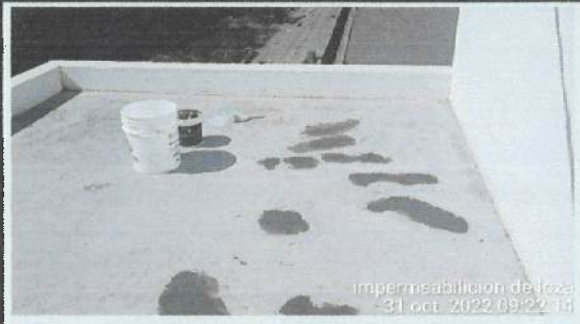
Impermeabilización de cubierta en bloque 29.
