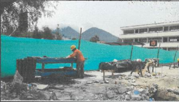
Armado de estribos en bloque 19, aulas nuevas.
