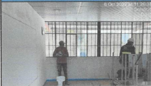
Empaste interior en bloque 32 ✓
