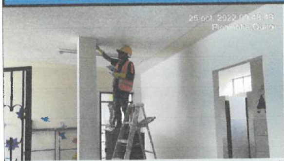
Empaste interior en etapa 1, bloque 27-1.
