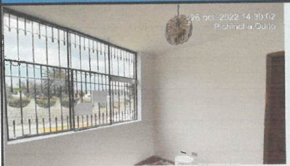
Pintura interior (primera - segunda mano) en bloque 27-2.
