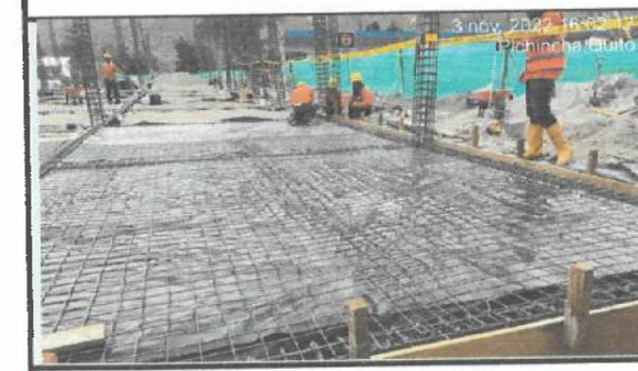
Colocación de malla electrosoldada para contrapiso en eje A -G (1 - 2 - 3).
