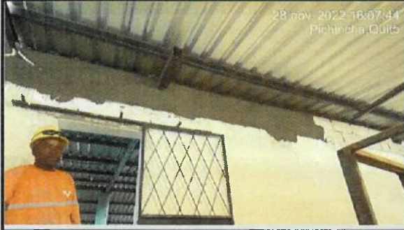
Enlucido de paredes en bloque 7.
