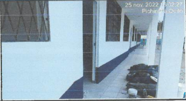
Pintura exterior en bloque 20 - 29, color azul.
