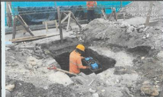
Compactación, mejoramiento de suelo en eje E.
