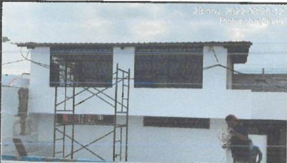
Instalación de canalones en bloque 33.
