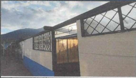
(Mantenimiento de la estructura metalica de la cubierta BLOQUE 19 panaderia) ✓
