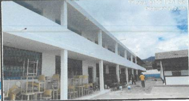
Lijado exterior en bloque 20 - 29.
