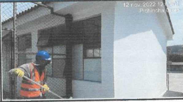
Pintura exterior en bloque 23.
