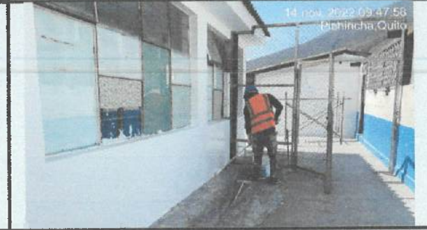
Pintura exterior en bloque 23.
