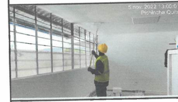
Pintura interior en bloque 26. (segunda mano).
