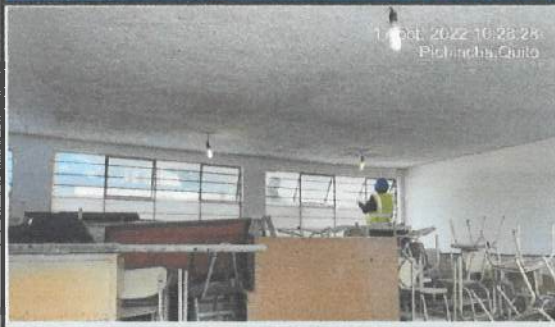
Empaste interior en bloques etapa 1. (Bloque 23 - 29 - 34).
