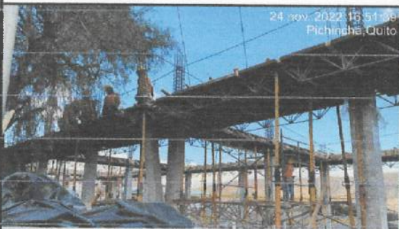
Encofrado de vigas en eje G' - M (1 - 2 - 3).
