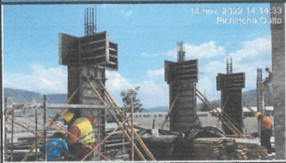
Encofrado de columnas en eje A - E (3).
