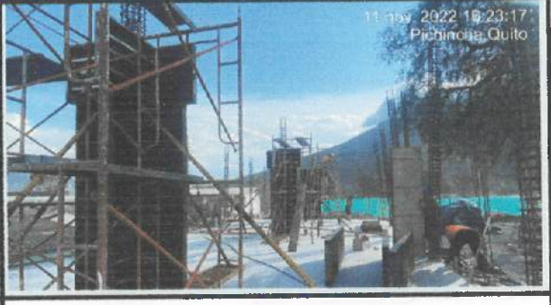
Encofrado de columnas en ejes G' - I - K - M (2).
