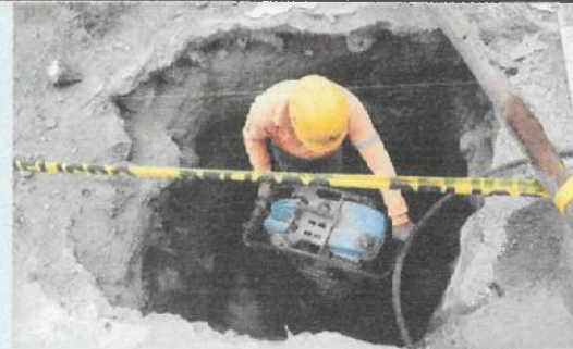
Mejoramiento de suelo (primera parte con capa de 15 cm) para plintos.
