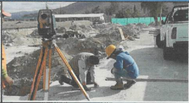
Replanteo de ejes en bloque 19 y verificación para el mejoramiento Subbase cañe 3. ✓
