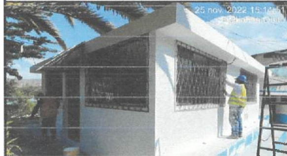
Pintura exterior en bloque 9.
