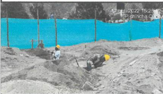
Mejoramiento de suelo en eje H - I - J.
