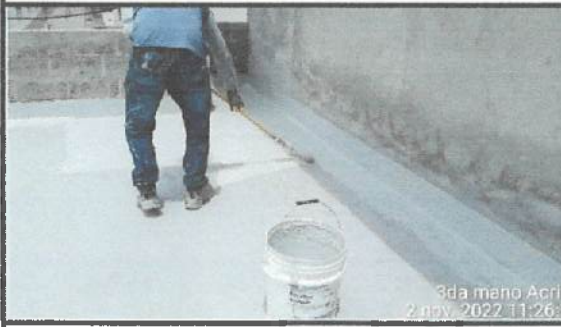
Impermeabilización de cubierta en bloque 33.
