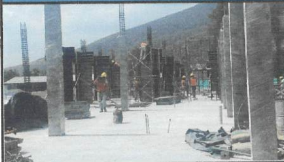
Desenfofrado de columnas en eje G' - M.
