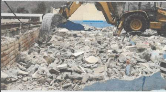
Limpieza y desalojo de escombros en bloque 19, aulas nuevas. ✓
