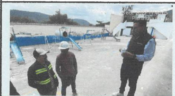
Liberación de pintura para puertas de Tool en bloque 33 (sección básica)
