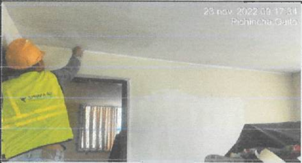
Empaste interior en bloque 9.
