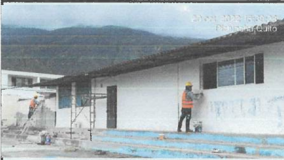
Empaste exterior de etapa 1. Bloque 32
