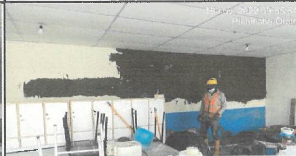
Enlucido en la parte interna de bloque 16.
