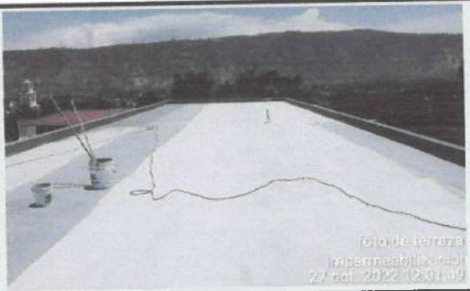
Impermeabilización de cubierta con membrana líquida en bloque en bloque 29
