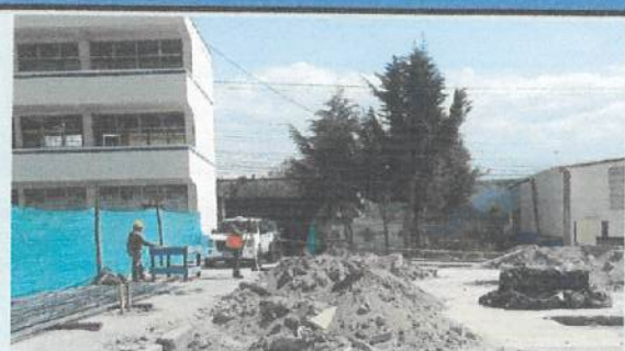
(Replanteo de plintos bloque 19, con estación de Topografo para nivel de plintos y ejes )
