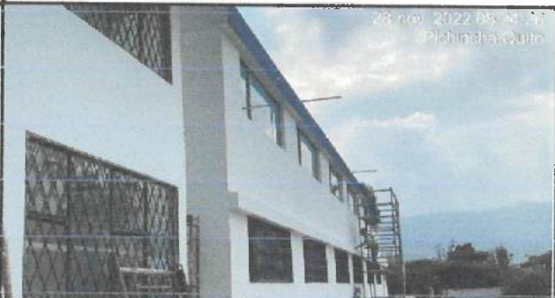
Pintura exterior en bloque 29.
