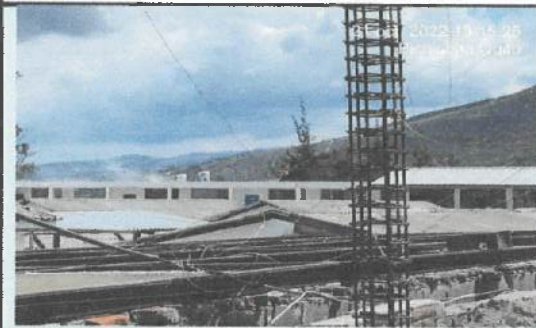
Impermeabilización de cubierta con membrana líquida en bloque 29
