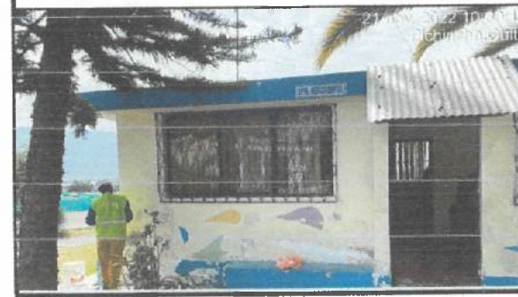
Resane y lijado exterior en bloque 9.
