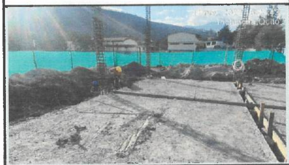
Confinar para instalación de tubería K - L - M (4 - 5 - 6).
