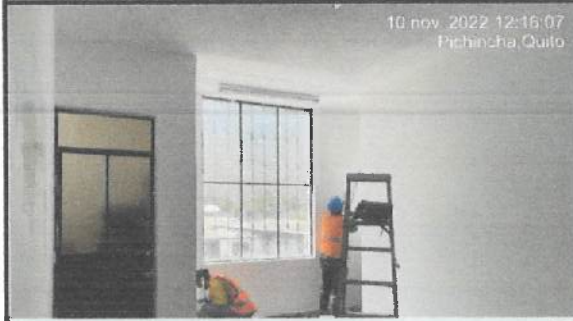
Pintura interior en bloque 27. ✓
