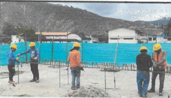
Armado de columnas
