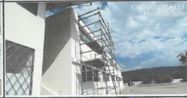
Empaste exterior en bloque 29 (segunda capa).
