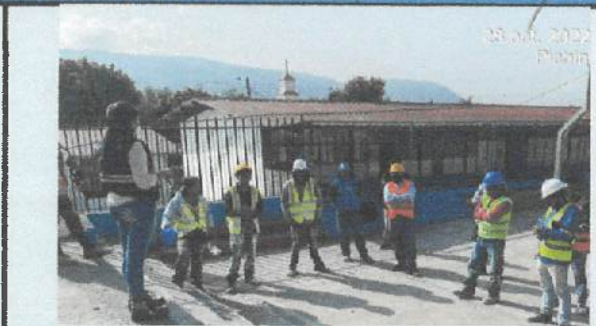
Charla de limpieza de materiales de seguridad al personal de obra y pintores.
