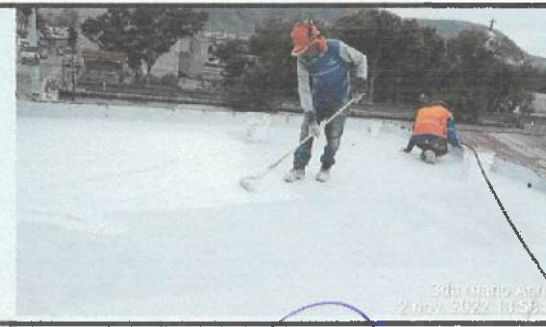
Impermeabilización de cubierta en bloque 35.
