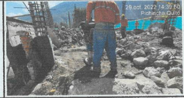
Compactación en ejes A - B
