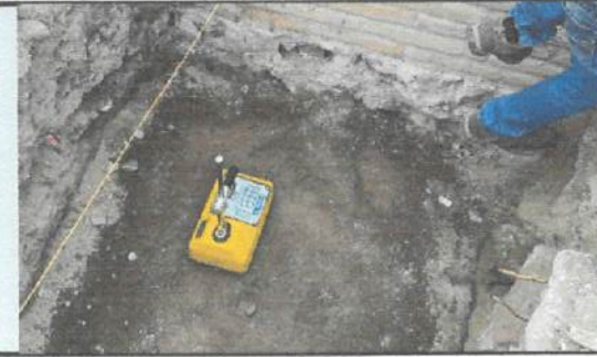
Prueba de compactación de suelo (Prctor)
