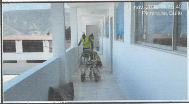
Lijado en paredes exteriores en bloque 29. ✓
