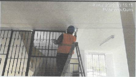
Pintura interior en bloque 27.
