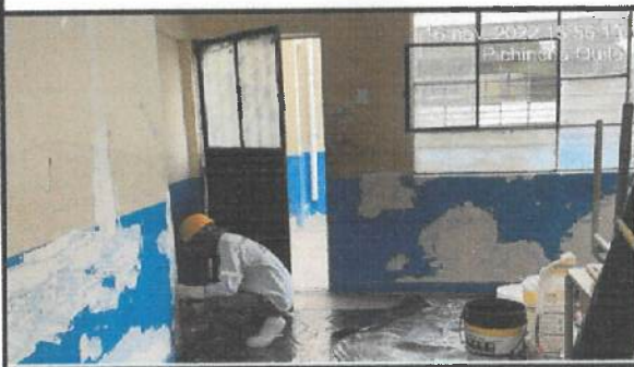
Resane y empaste exterior en bloque 14.
