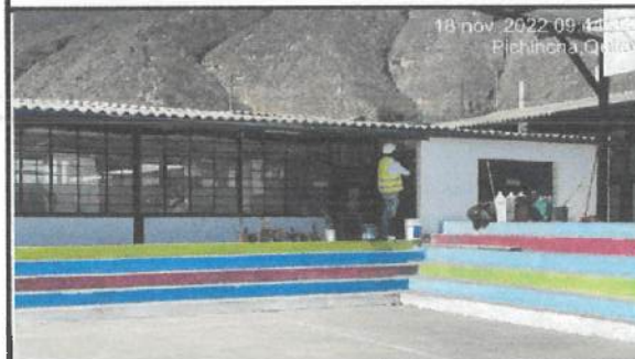
Pintura exterior en bloque 32.
