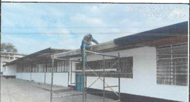
Instalación de canalones en bloque 26.
