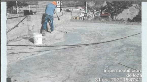
Impermeabilización de cubierta en bloque 35.
