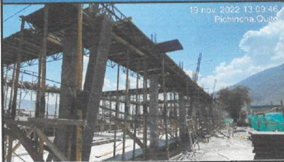
Desenfofrado de columnas en eje A - G (3).
