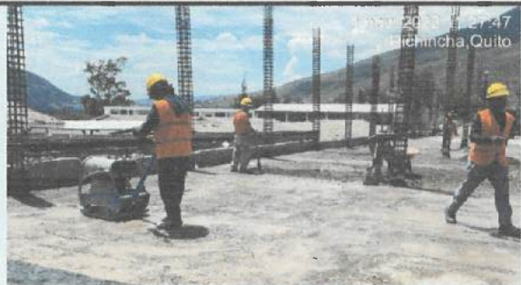
Compactación con cama de lastre cada 15 cm (total 30cm)
