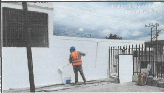
Pintura exterior en bloque 27. ✓
