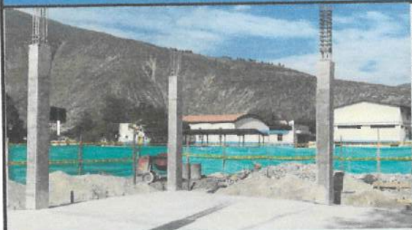
Desenfofrado de columnas en ejes K - L - M (4 - 5 - 6).
