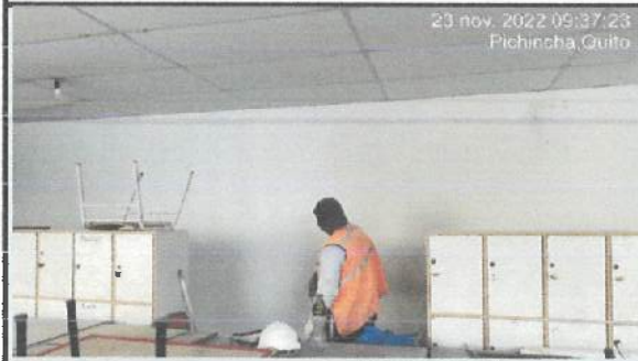
Pintura interior en bloque 16.
