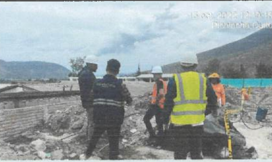
Pruebas de compactación de suelo.
