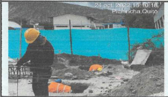
Excavación de plintos en eje K - L - M (4 - 5 - 6)
