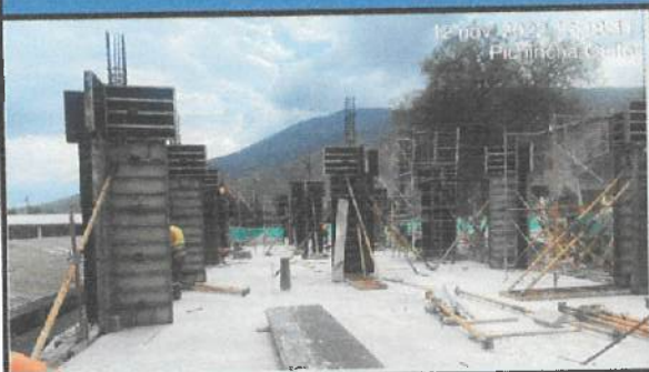
Encofrado de columnas en eje G' - M.
