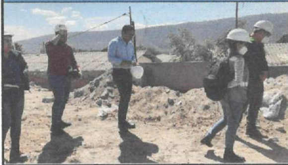
Visita de fiscalización para realizar recorrido en bloques a intervenir.
