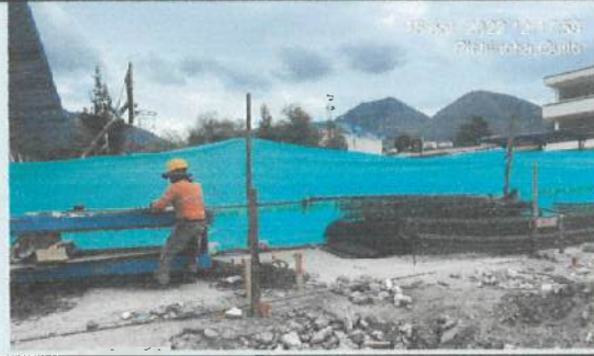
Corte y figurado y armado de columnas C3.
