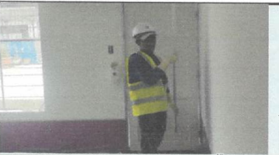
Pintura interior en bloque 34.
