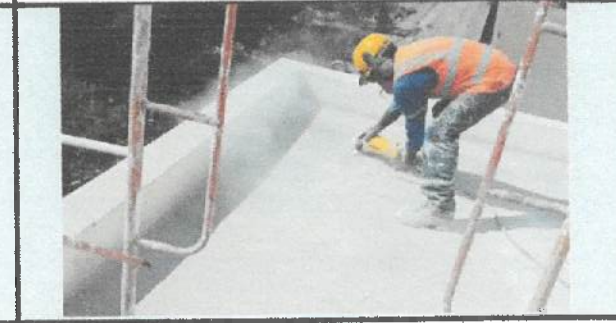
Impermeabilización en cubierta de bloque 29.
