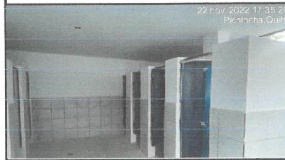
Pintura interior en baños de bloque 33.
