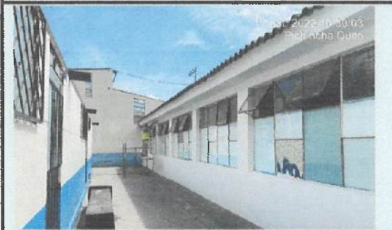
Empaste exterior en bloques etapa 1 ( Bloque 23).
