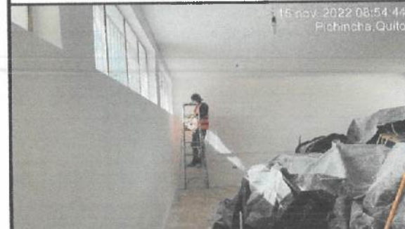
Pintura interior en bloque 23.
