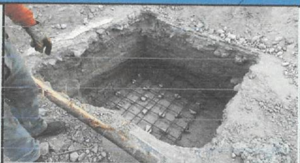
Asegurado de parrillas en plintos en ejes A - D (1 - 2 - 3), bloque 19 aulas nuevas.
