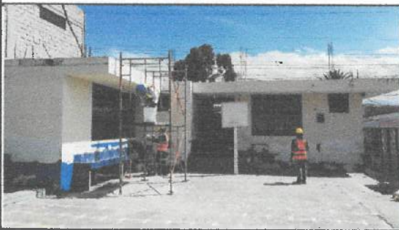
Empaste exterior (primera mano) en bloque 35.
