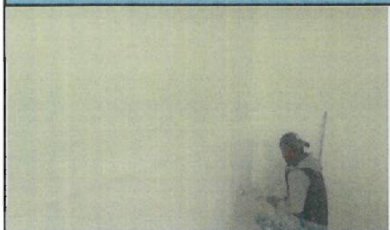
Empaste interior en bloque 15
