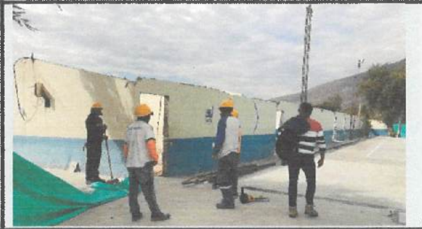
Desmontaje de puertas y ventanas en bloque 19.
