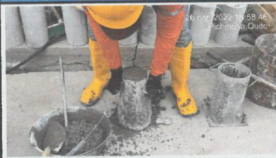
Prueba de asentamiento para fundición de cuello de columnas.
