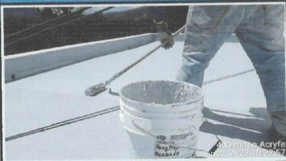
Impermeabilización de cubierta en bloque 29.
