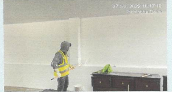
Pintura interior primera mano en bloque 27-2.
