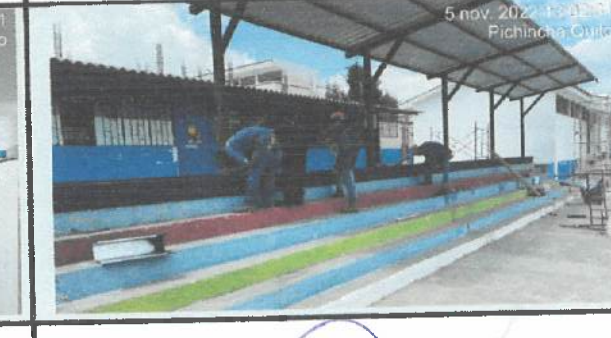
Instalación de canalones en bloque 32.
