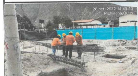
Armado y amarrado de columnas.
