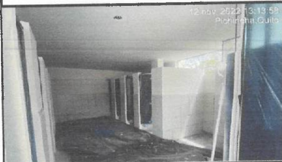
Pintura interior en bloque 33.
