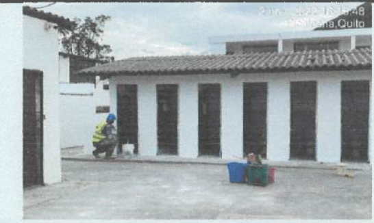
Pintura exterior en bloque 30 - 31.
