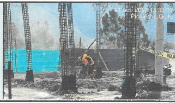
Relleño hidrocompactado con material de mejoramiento.
