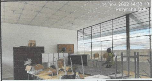
Pintura interior en bloque 28.
