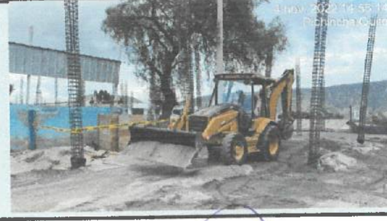
Compactación y relleno en eje J - M (1 - 2 - 3) (4 - 5 - 6).
