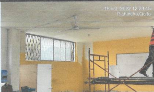
Empaste interior en bloques etapa 1. (Bloque 23 - 27)
