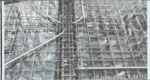
Instalación de tubería conduit en tramo de eje G' - M. ✓
