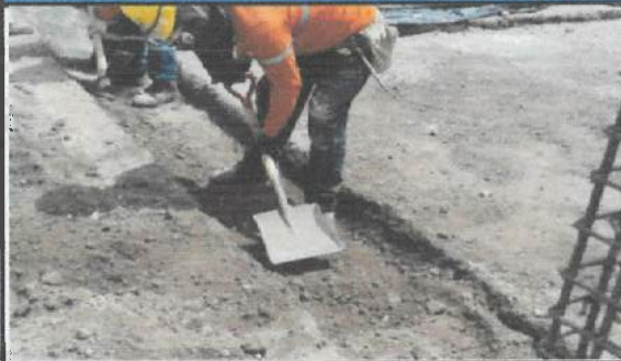
(CONFORMACION) Excavación de cadenas en eje A - G (1 - 2 - 3)
