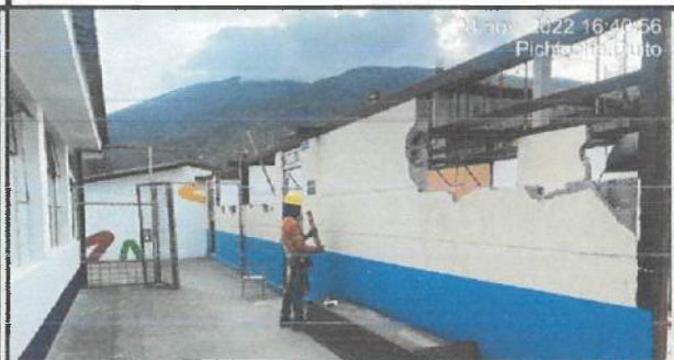
Timbrado de ventanas y puertas en bloque 19 panadería.
