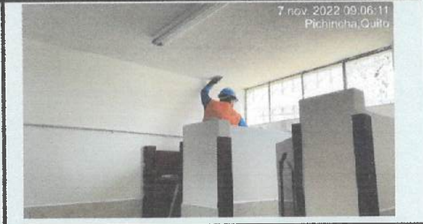
Pintura interior en bloque 27.
