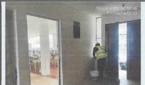
Empaste interior en bloques etapa 1. (Bloque 27-1)
