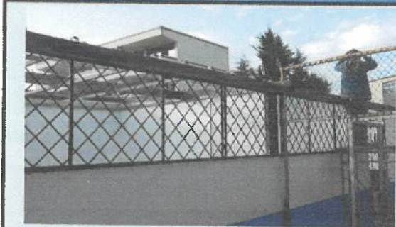
(Mantenimiento de la estructura metalica de la cubierta BLOQUE 19 panadería)
