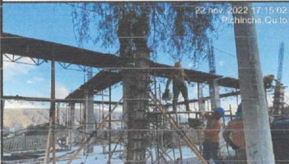
Fundición de columnas en eje G' - M (1).
