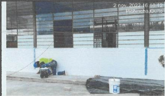
Pintura exterior en bloque 21 - 25 - 28.
