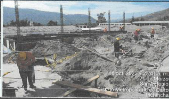
Replanteo de ejes de columnas en ejes A - D (1 - 2 - 3), bloque 19 aulas nuevas.
