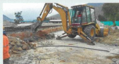
(Escavación para plintos del bloque 19 Aulas nuevas)
