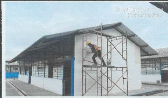
Empaste exterior en bloques etapa 1. (Bloque 21 - 25 - 28)
