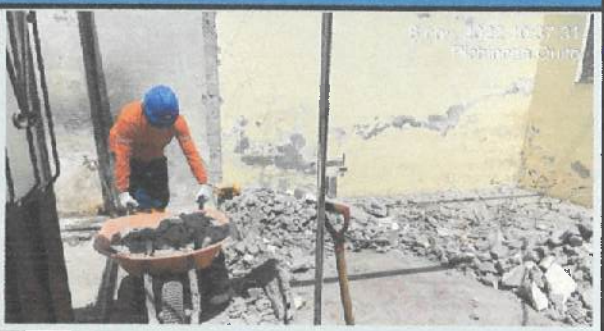
Derrocado de mampostería, desalojo y limpieza de escombros, bloque 19 panadería.
