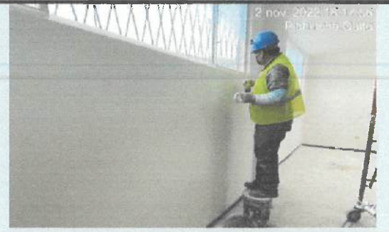
Pintura interior en bloque 29. (primera mano).
