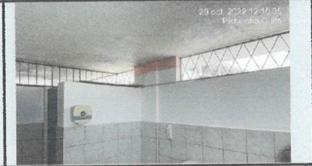
Pintura interior en bloque 33 baño sección inicial.
