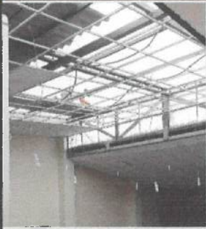
Desmontaje del Cielo Falso armstrong del bloque 24 para el desmontaje de la cubierta
