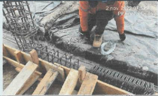
Armado de hierro de cadenas
