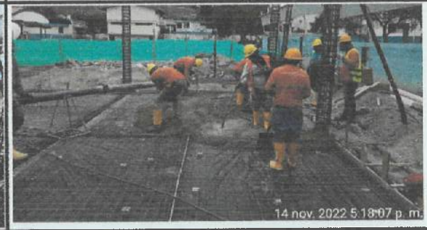
Fundición de contrapiso en eje K - L - M (4 - 5 - 6).
