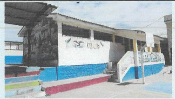
Resane y empaste exterior de bloque 23.
