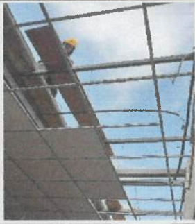
Desmontaje del Cielo Falso armstrong del bloque 24 para el desmontaje de la cubierta
