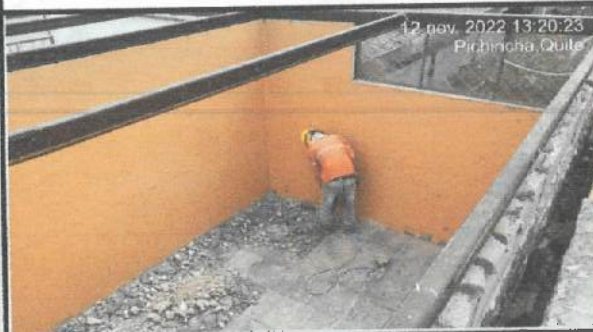
Derrocado de piso en bloque 19 (panadería).
