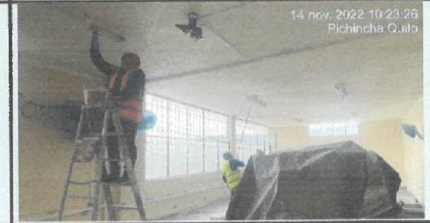
Pintura interior en bloque 27.
