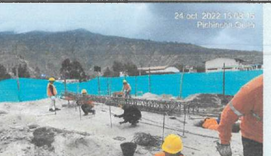
Armado de columnas
