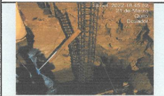
Fundición de zapata en eje (A - G) (1 - 2 - 3)
