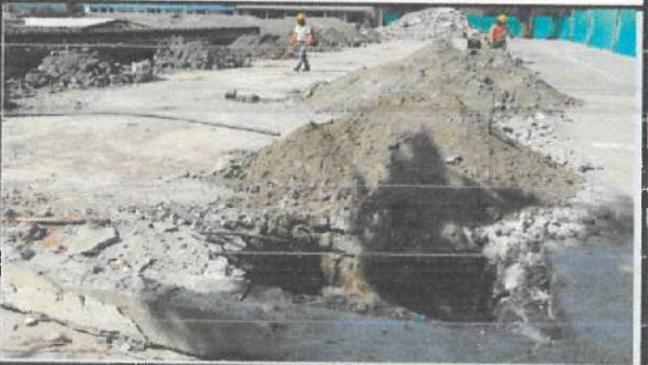
Mejoramiento de suelo en dos capas de 15cm de Subbase clase 3. ✓
