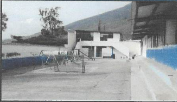
Empaste exterior de etapa 1. Bloque 33
