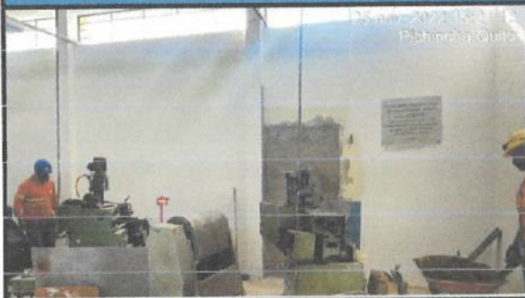
Enlucido de paredes interiores en bloque 7.
