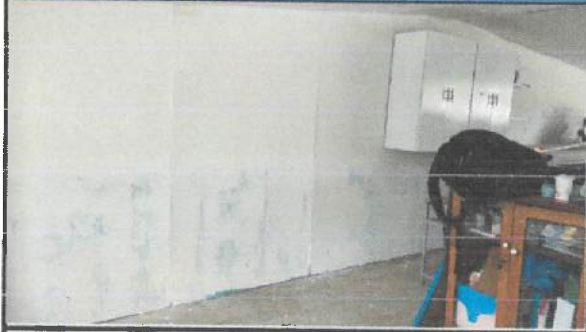
Revisión de empaste interior en bloque 34. ✓
