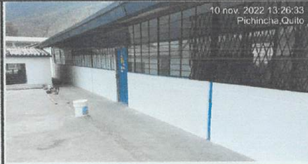
Pintura exterior en bloque 22. ✓
