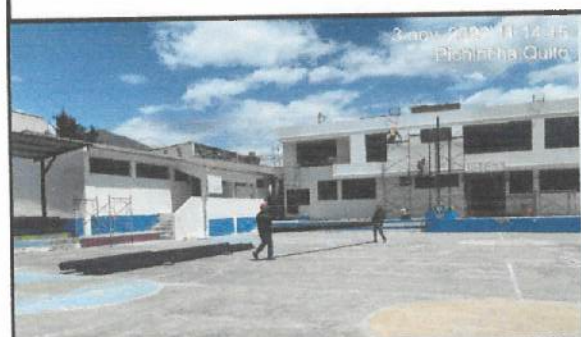
Instalación de canalones en bloque 32.
