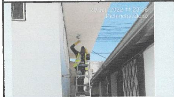
Empaste exterior en tumbado de bloque 35
