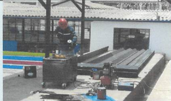
Preparación de canales para su instalación en bloque 21 - 25 - 28.
