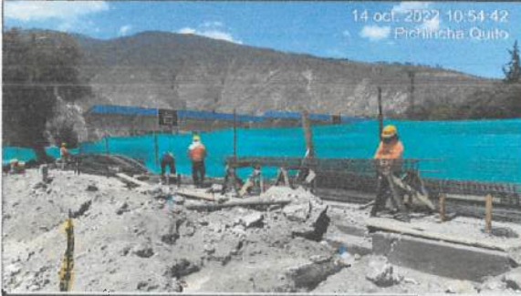
Corte y figurado y armado de columnas (C2 - C3)
