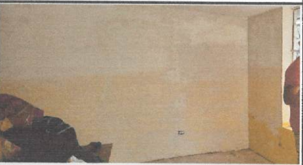
(Resane y empaste interior BLOQUE 34) ✓
