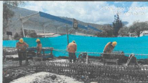
Armado de columnas
