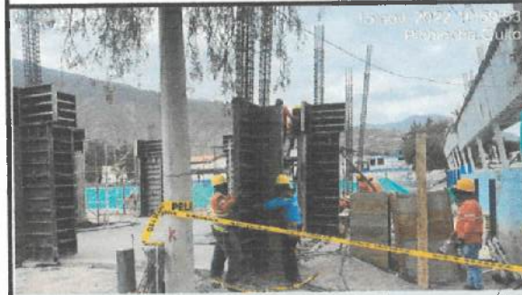
Encofrado de columnas en eje K - L - M (4 - 5 - 6).
