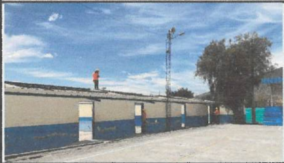
Desmontaje de puertas y ventanas en bloque 19.
