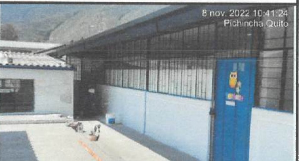
Pintura exterior en bloque 22.
