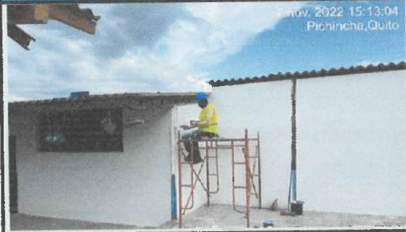
Empaste exterior en bloque 32, segunda capa.
