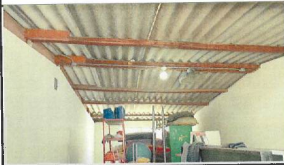
Instalaciones eléctricas bloque 26-32
