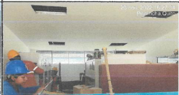
Limpieza interior y exterior en bloque 34.
