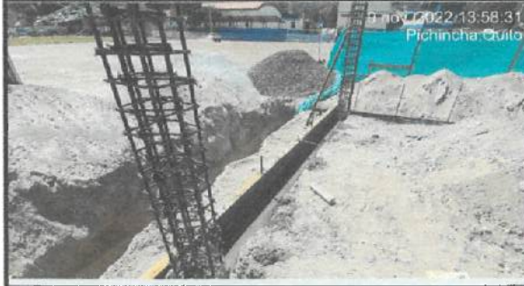
Hormigón ciclópeo en eje M (1 - 2 - 3) (4 - 5 - 6) ✓
