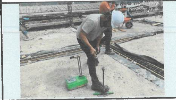
Prueba de densidad (compactación de suelo).
