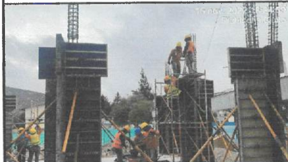
Fundición de columnas en eje K - L - M (4 -5)
