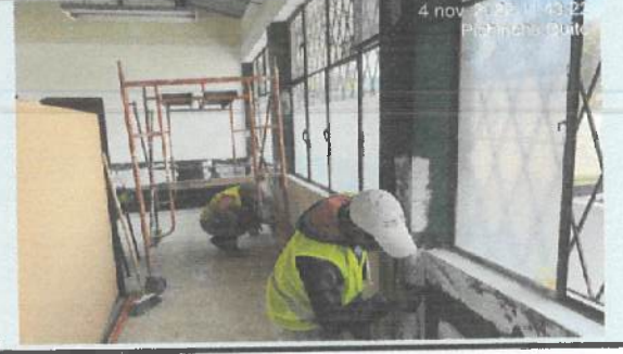
Empaste interior en bloque 20 (lijado).
