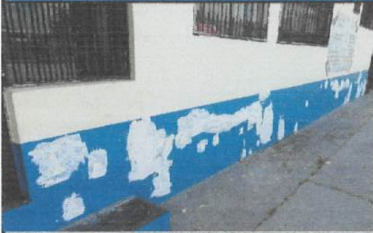
Resane y empaste exterior de bloque 27-1.
