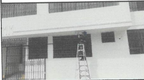
Pintura exterior en bloque 27.
