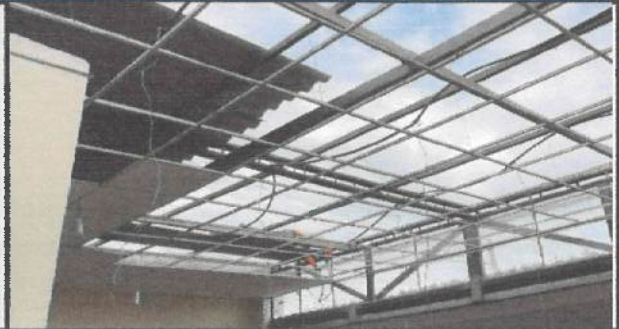
Desmontaje de cielo falso en bloque 24. ✓
