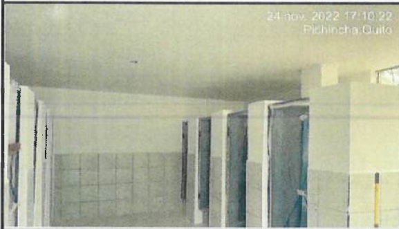
Pintura interior en bloque 33.
