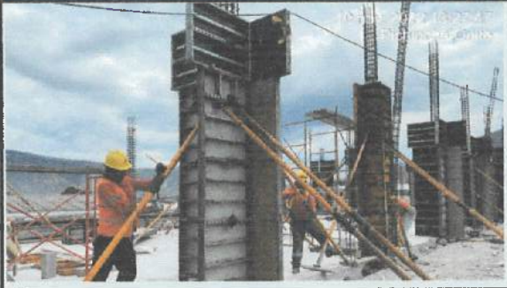
Encofrado de columnas en eje A - G (1 - 2 - 3). ✓
