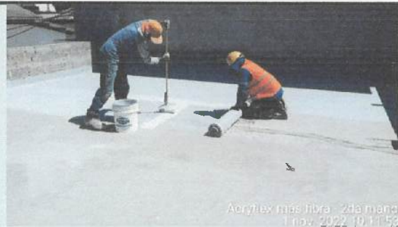
Impermeabilización de cubierta en bloque 33.
