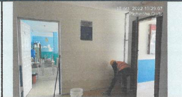
Empaste interior en bloques etapa 1. (Bloque 27-1).
