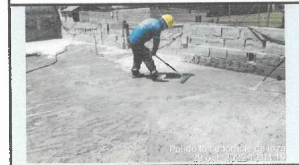
Impermeabilización en cubierta de bloque 33.
