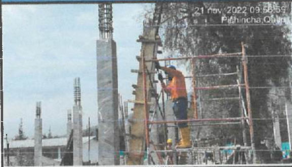
Encofrado de columnas en eje G' (1 - 2 - 3) y 1 (I - K - M).
