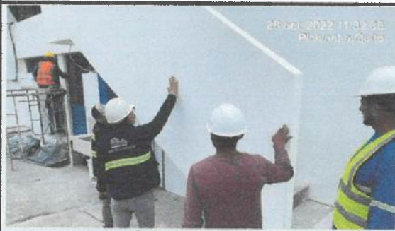
Revisión de empaste y de pintura interior y exterior en bloques 32 y 33
