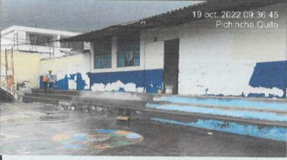
Empaste exterior en bloques de etapa 1 (Bloque 32 parte posterior)
