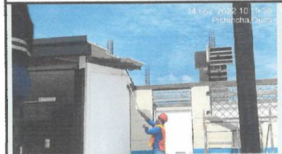
Pintura exterior en bloque 22.
