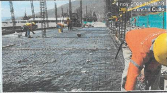
Colocación de malla electrosoldada para contrapiso en eje C-G (1 - 2 - 3).
