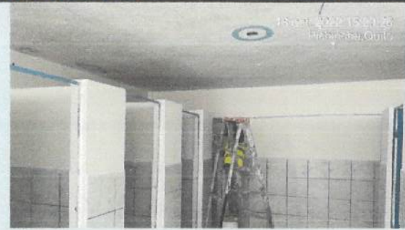
Empaste interior en bloques etapa 1. (Bloque 33)
