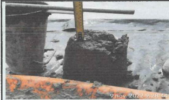
Prueba de asentamiento para fundición de contrapiso. ✓
