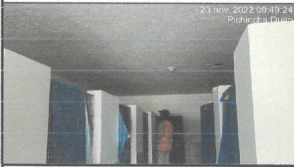
Pintura interior en bloque 33, baños.
