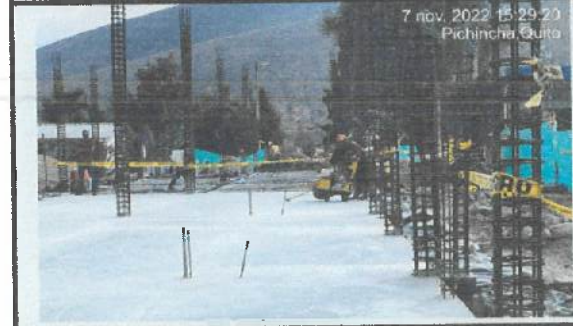
Juntas de dilatación en ejes A - G
