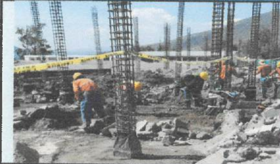
Relleno y compactación en los bloque B- H
