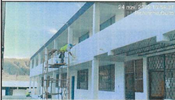
Pintura exterior en bloque 20 - 29.
