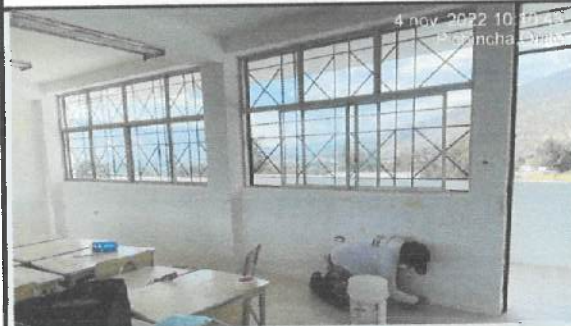
Pintura interior en bloque 18 - primera mano.
