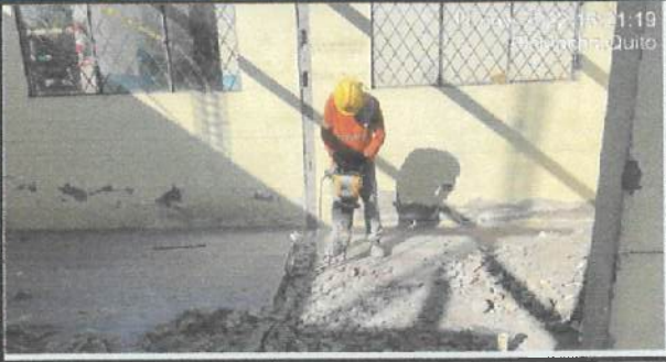
Derrocado de piso en bloque 19 (panadería).
