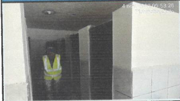
Mantenimiento de puertas de tool, en bloque 33.
