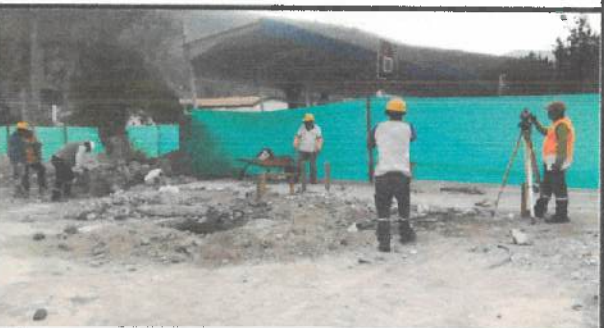
Replanteo y nivelación de ejes mediante estación. ✓
