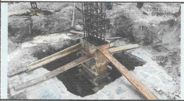
Encofrado de cuello de columnas en ejes H - I - J - K
