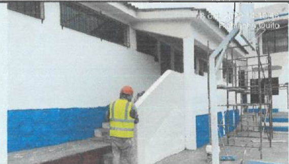
Empaste exterior en bloques etapa 1. (Bloque 23)
