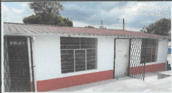
Pintura exterior en bloque 34. ✓
