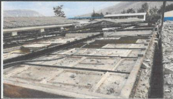
Desmontaje de cubierta en bloque 19, panadería. ✓
