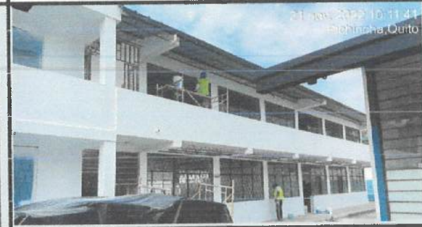
Pintura exterior en bloque 20 - 29.
