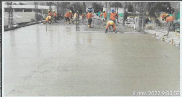
Alisado de contrapiso en eje G' - M. ✓
