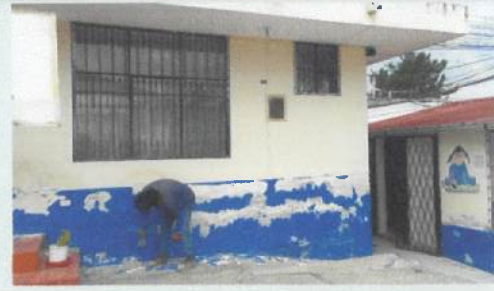
(Raspado de paredes externas bloque 27 bloque 34)
