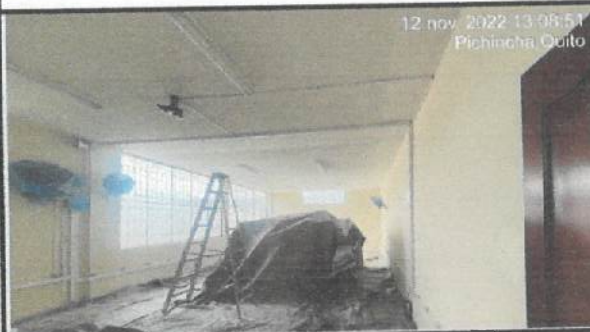
Pintura interior en bloque 27.
