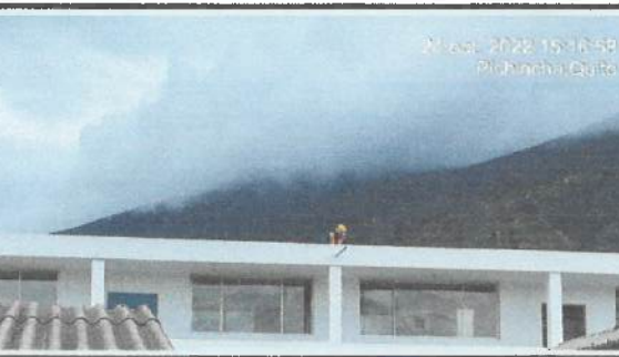
Impermeabilización de cubierta con membrana líquida en bloque 27-1 y bloque 29
