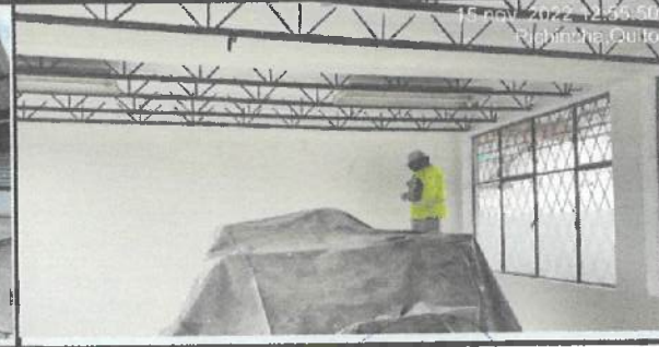
Pintura interior en bloque 20.
