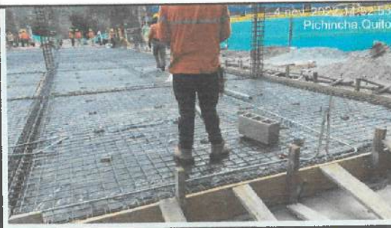
Instalación de tubería conduit en eje A - G.
