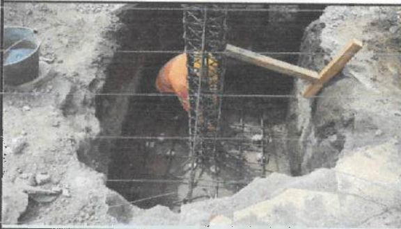
Aplomado de columnas en ejes A - D (1 - 2 - 3), bloque 19 aulas nuevas.
