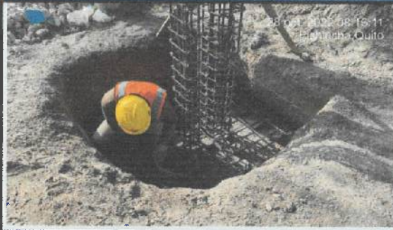
Armado de parrillas en ejes K - L - M (4 - 5 - 6)
