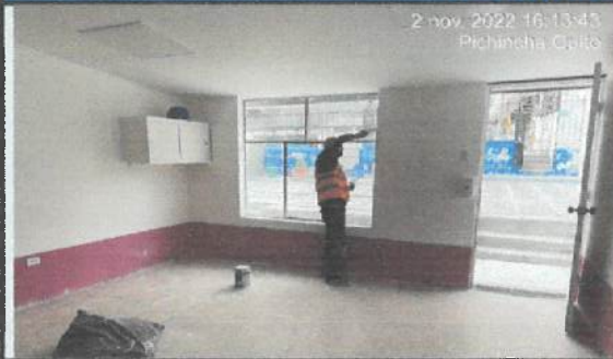
Pintura interior en bloque 34 (corrección de fallas).
