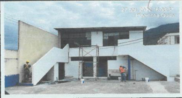
Pintura exterior primera mano en bloque 33.
