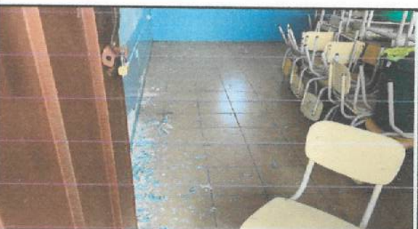
Resane interior y exterior en bloque 26 - 20 - 29 ✓
