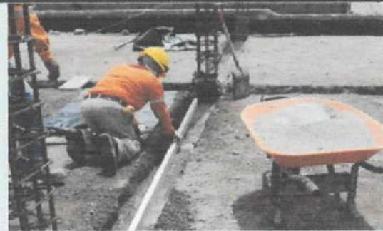
Colocación de cama de arena de 3cm.
