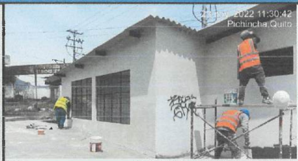
Resane y empaste exterior en bloque 3.
