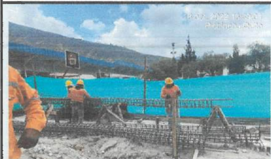
Armado de columnas en ejes (F - G) (1 - 2 - 3)
