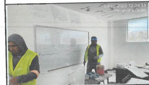
Pintura interior en bloque 29 (primera mano).
