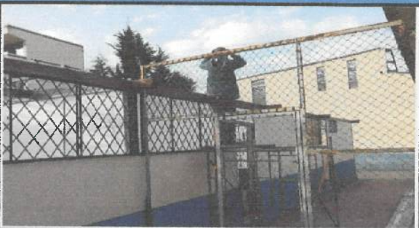
(Mantenimiento de la estructura metalica de la cubierta BLOQUE 19 panaderia) ✓
