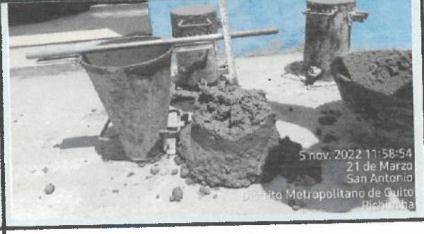
Prueba de asentamiento.
