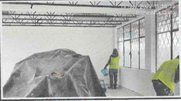
Pintura interior en bloque 20.
