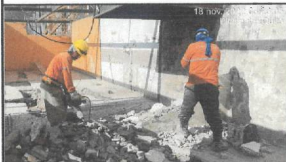
Derrocado de piso y mampostería en bloque 19 panadería.
