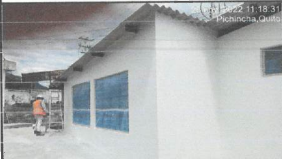
Pintura exterior en bloque 3.
