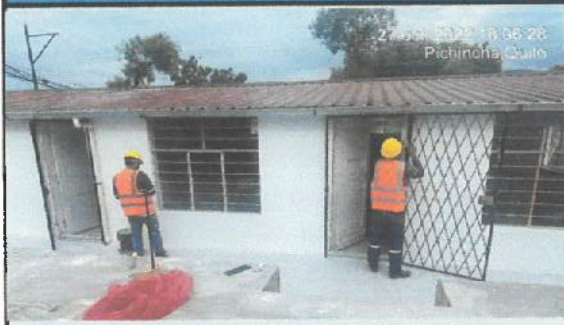
Pintura exterior primera mano en bloque 32.
