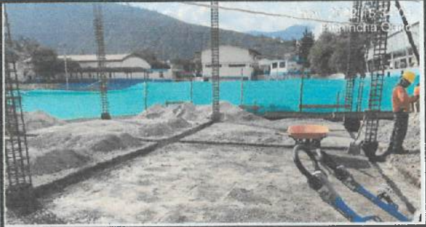
Excavación de cadenas en eje K - L - M (4 - 5 - 6).
