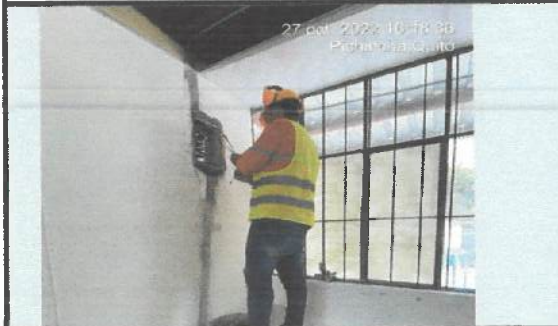
Colocación de caja térmica de 8 espacios en bloque 32.
