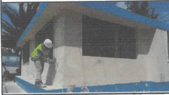
Resane y lijado en bloque 9.
