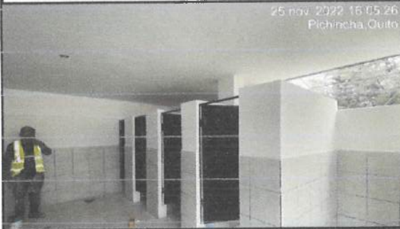
Pintura interior en bloque 33, baños
