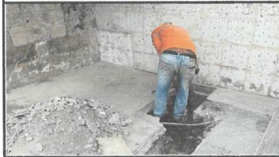
Retiro de tubería existente en bloque 19 (panadería). ✓
