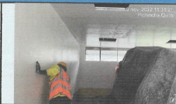
Pintura interior en bloque 34. ✓
