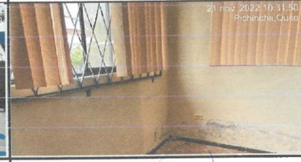
Resane interior en bloque 9.
