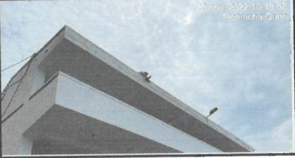
Resane y empaste exterior en bloque 18.
