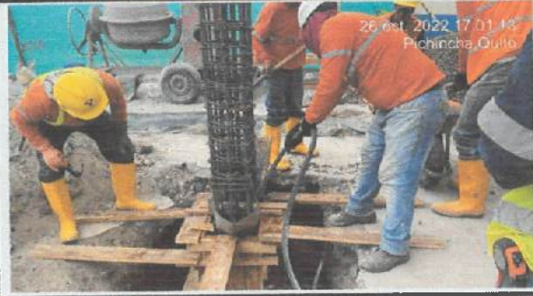
Fundición de cuello de columnas en ejes (A - G).
