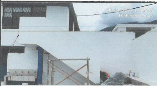
Lijado y pintura exterior en bloque 33.
