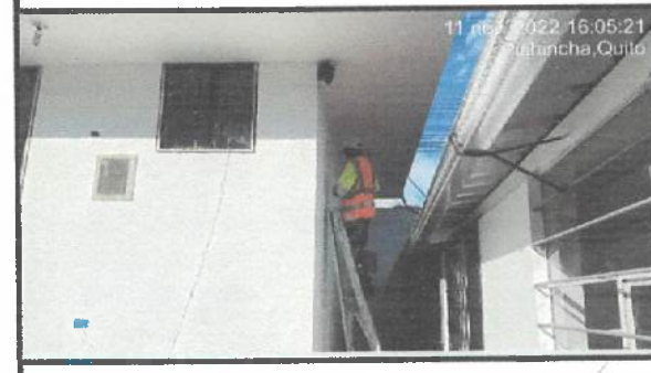
Pintura exterior en bloque 35.
