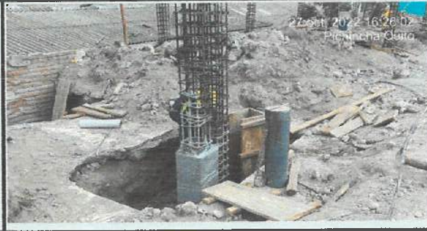
Desencofrado de cuello de columnas en ejes (A - G)
