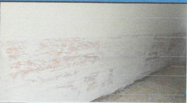
Revisión de empaste interior en bloque 34. ✓
