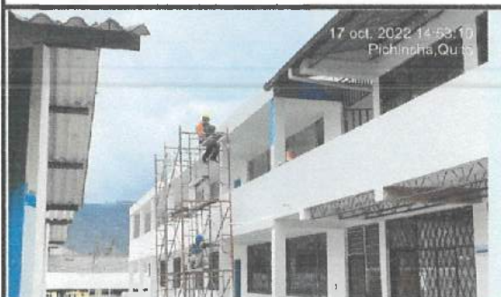
Empaste exterior en bloques etapa 1 ( Bloque 20 - 29).
