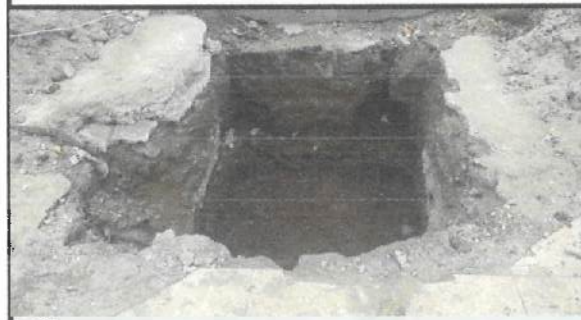
Mejoramiento de suelo, capa de 15cm para plintos. ✓
