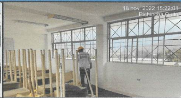
Lijado y empaste interior en bloque 18.
