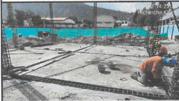
Amarrado de columnas en eje K - L - M (4 - 5 - 6).
