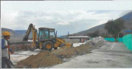
(Escavación para plintos del bloque 19 Aulas nuevas)
