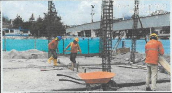
Encofrado de cadena en eje K - L - M (4 - 5 - 6). ✓
