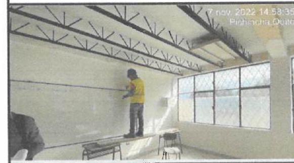
Pintura interior en bloque 20.
