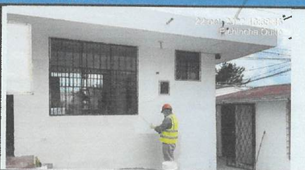
Empaste exterior de etapa 1. Bloque 27-2
