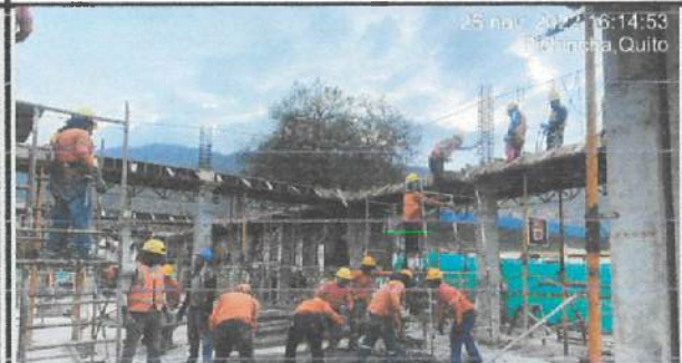
Fundición de vigas en eje G' - M (1 - 2 - 3) en bloque 19 aulas nuevas.
