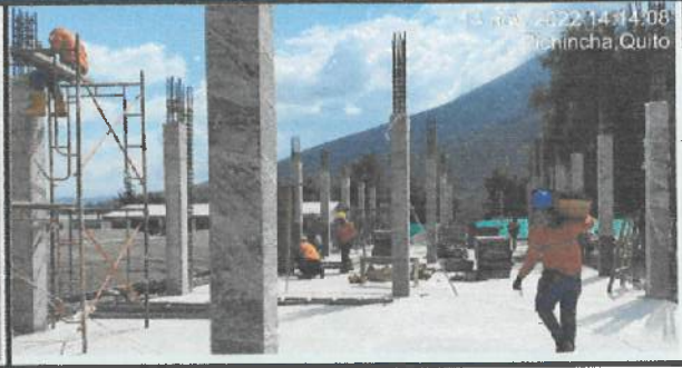
Desencofrado de columnas en eje J - M (1 - 2 - 3).
