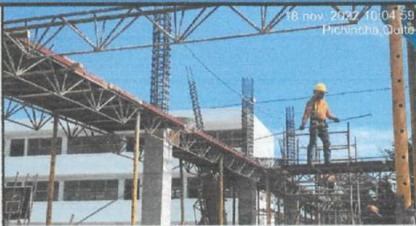
Amarrado de hierro en vigas en ejes A - G (1 - 3).
