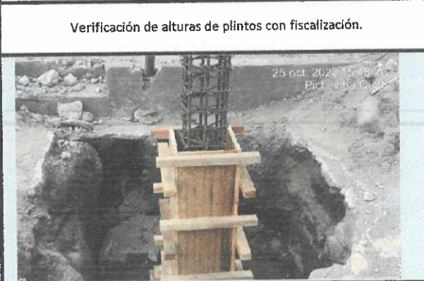
Encofrado de cuello de columnas.
