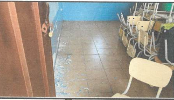
Raspado de paredes en bloque 32. ✓
