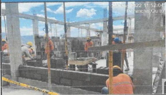
Colocación de mampostería en ejes A - G (1 - 2 - 3) en bloque 19 aulas nuevas.
