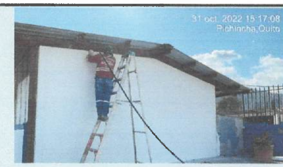
Lijado y pintura en bloque 32.
