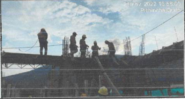
Fundición de vigas en eje A - G (1 - 2 - 3).
