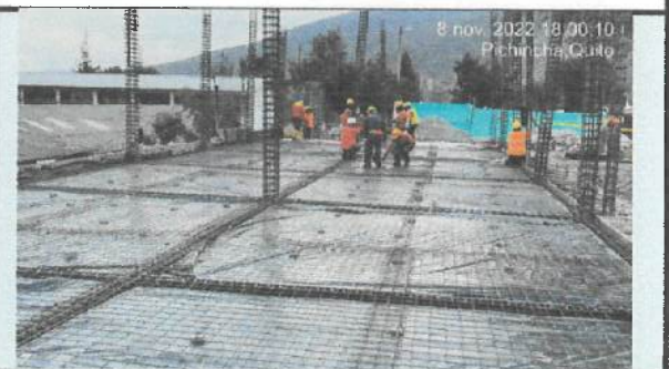
Colocación de malla electrosoldada para contrapiso en eje G' - M (1 - 2 - 3).
