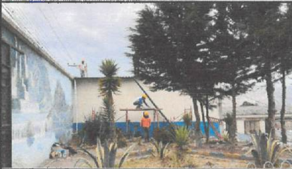
Desmontaje de cubierta en bloque 24. ✓
