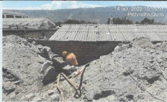
Compactación, mejoramiento de suelo.
