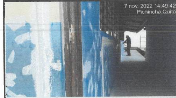
Lijado y empaste exterior en bloque 22.
