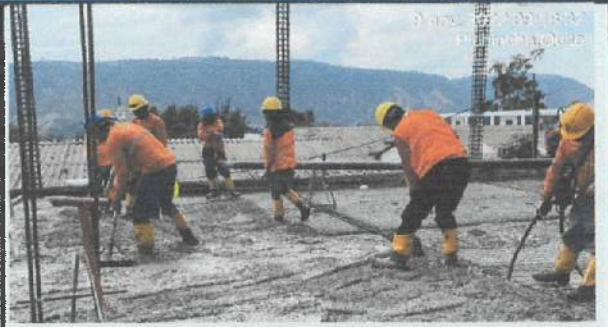
Fundición de contrapiso en eje G' - M. ✓
