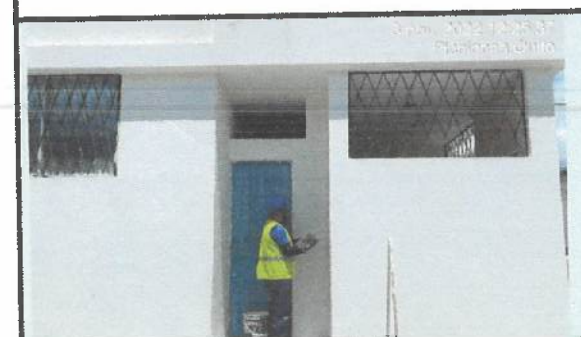
Empaste exterior en bloque 29, segunda capa.
