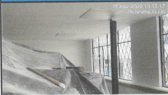
Pintura interior en bloque 33. Aulas.
