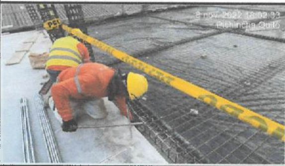
Colocación de plástico en eje G' - M (1 - 2 - 3).
