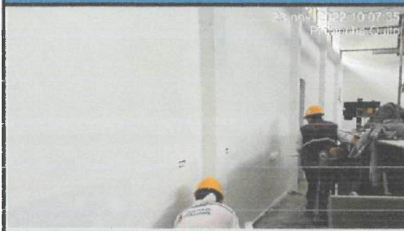
Pintura interior en bloque 7.
