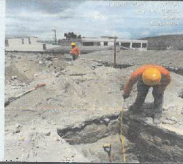
Excavación de plintos (G - H - I - J)
