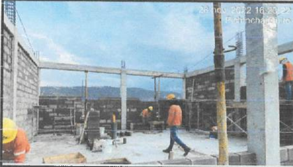
Colocación de mampostería en bloque 19 aulas nuevas.
