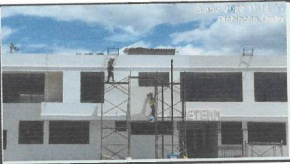
Pintura exterior en bloque 27, primera mano.
