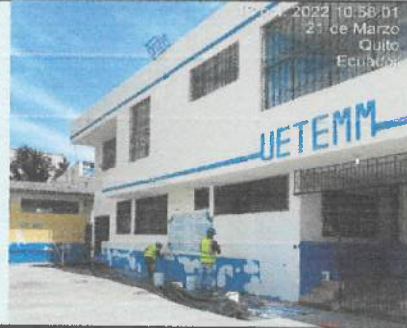
Empaste exterior en los bloques 1ra etapa. (Bloque 27-1 - 27-2 - 23 - 25 - 28 - 22)
