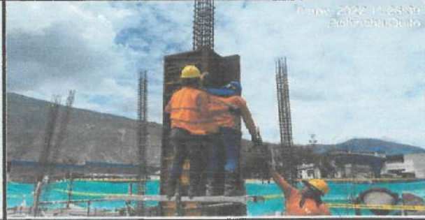
Encofrado de columnas en eje A - G. ✓
