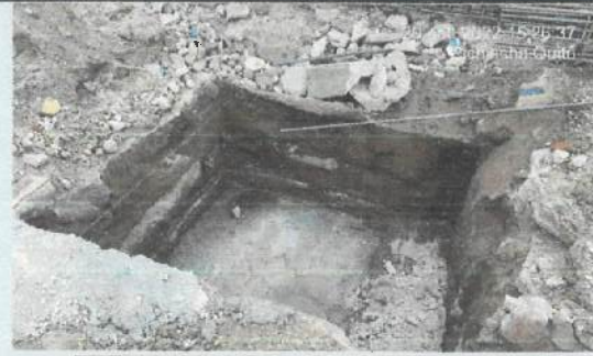
Replantillo de plintos en ejes (H - I - J - K - L) (1 - 2 - 3)
