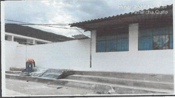
Pintura exterior primera mano en bloque 32.
