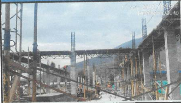
Encofrado de columnas en ejes A - G (1 - 3).
