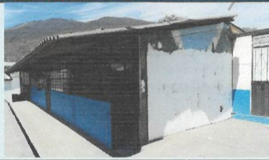
Empaste exterior de etapa 1 en bloque 22.
