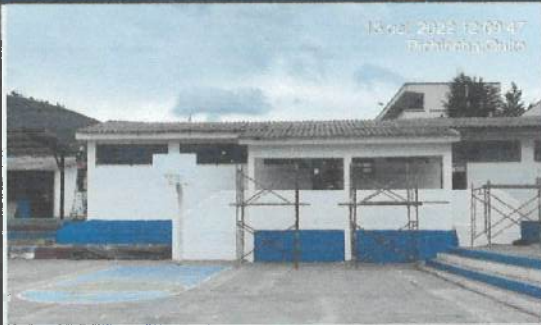
Empaste exterior en bloques etapa 1 (23 segunda capa)
