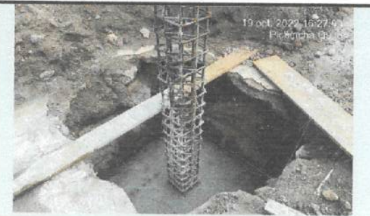
Fundición de plintos (A1 - A2 - B1)
