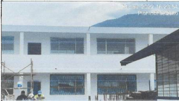
Pintura exterior en bloque 20 - 29.
