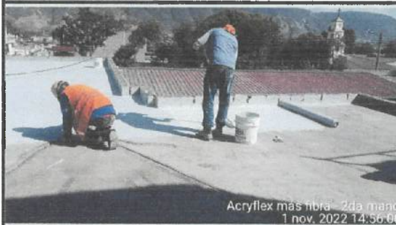
Impermeabilización de cubierta en bloque 35.
