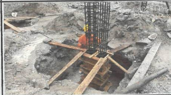
Encofrado de columnas en eje (G).
