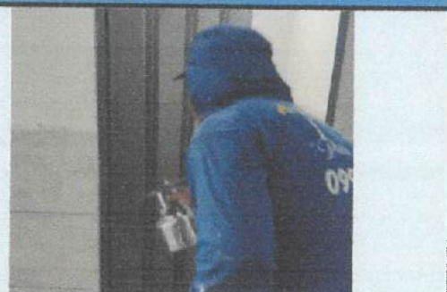
Mantenimiento de puertas de baños sección básica (Bloque 33).
