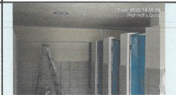
Empaste interior en bloques etapa 1. (Bloque 33).
