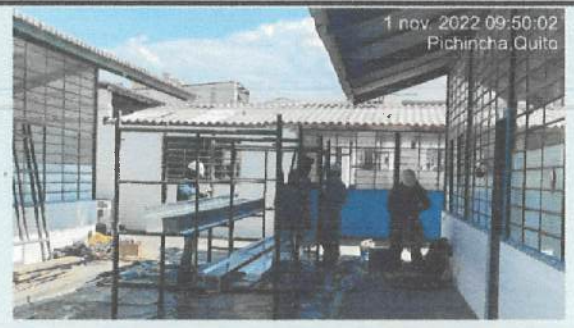
Preparación de canalones para su instalación en bloque 21 - 25 - 28
