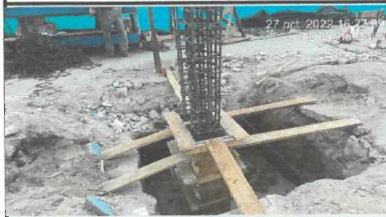
Encofrado de cuello de columnas en ejes (G' - M)
