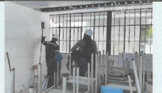
Implementación de circuitos de tomacorriente, tubería en bloque 32
