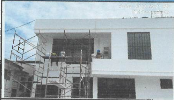
Pintura exterior en bloque 27. ✓
