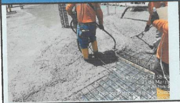
Fundición de contrapiso en eje A - G'
