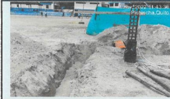
Excavación para alcantarillado de tubería en eje M - K (4 - 5 - 6).
