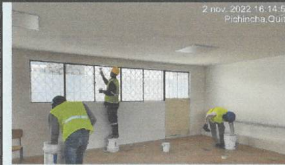
Empaste interior en bloque 26, segunda capa.
