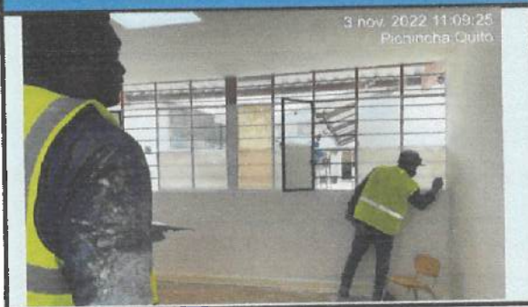
Empaste interior en bloque 26, segunda capa.
