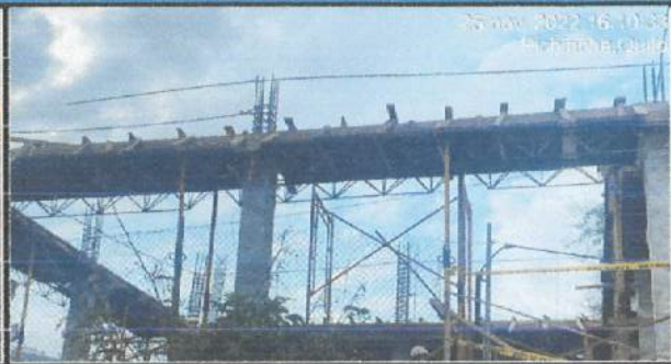
Encofrado de vigas en eje G' - M (1 - 2 - 3) en bloque 19 aulas nuevas.
