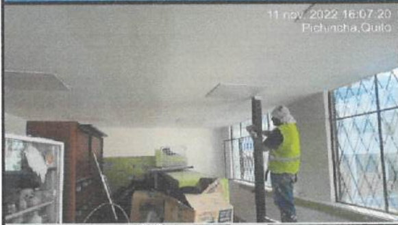
Pintura interior en bloque 33 (aulas).
