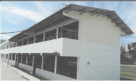
Empaste exterior de etapa 1 en bloque 20 - 29
