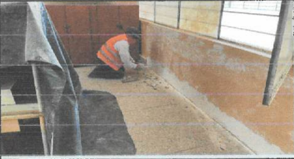
Resane y corrección de fallas en bloques 21 - 25 - 28.
