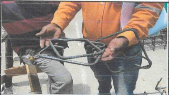
Revisión en armado y figurado de estribos de columnas y cadenas inferior en bloque 19, aulas nuevas. ✓
