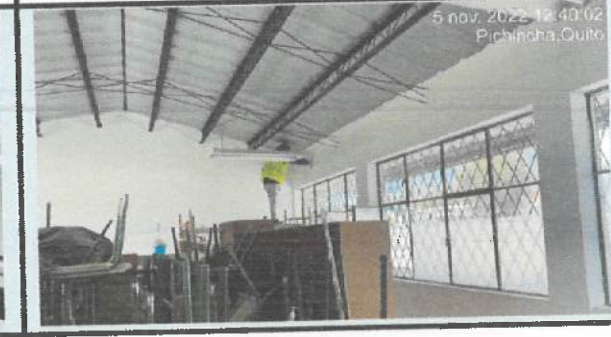
Pintura interior en bloque 20 (primera mano).
