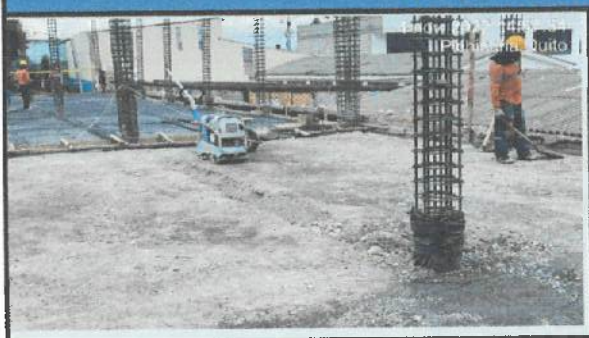
Excavación de cadenas en ejes G' - M
