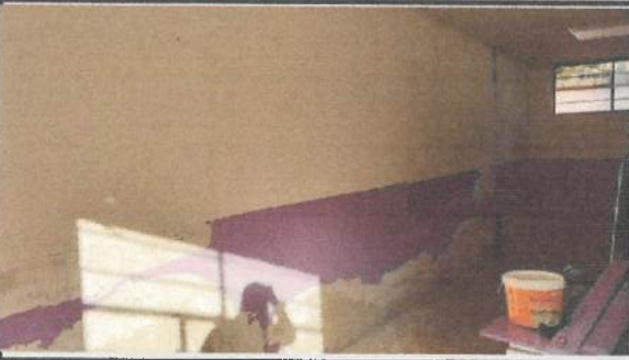
(Resane y empaste interior BLOQUE 34) ✓
