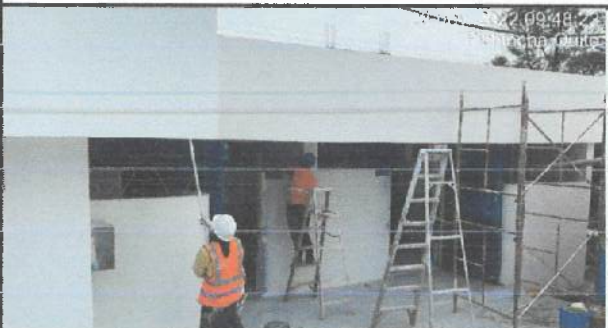
Pintura exterior en bloque 33 , baños.
