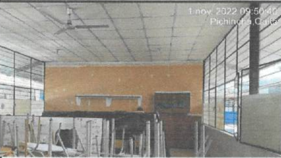
Pintura interior en bloque 21 - 25.
