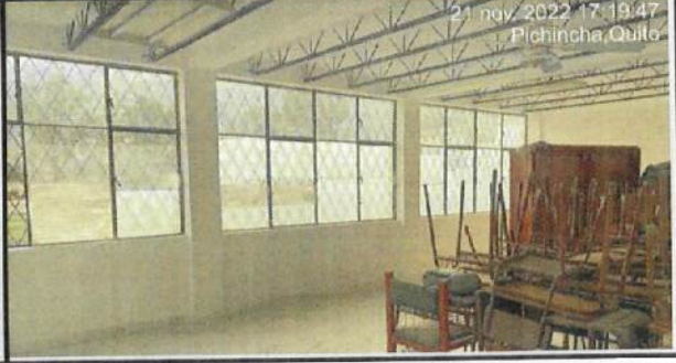
Pintura interior en bloque 20.
