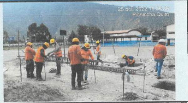
Armado de columnas.
