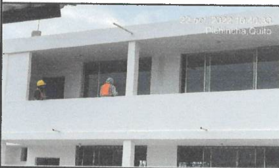
Empaste exterior de etapa 1. Bloque 29
