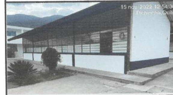
Pintura exterior en bloque 28. color azul.
