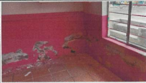
(Raspado de paredes interiores del bloque 34)
