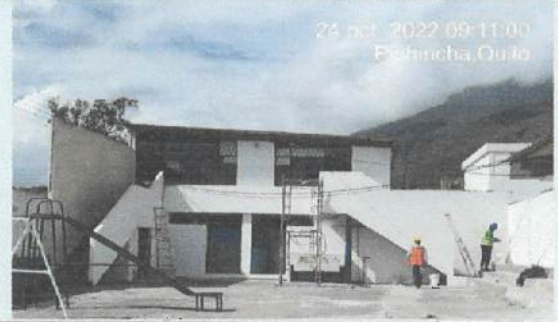
Empaste exterior de etapa 1. Bloque 33
