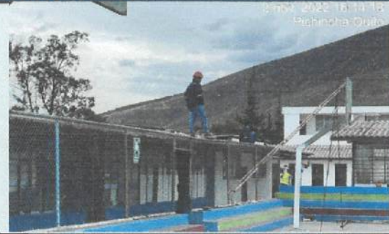
Instalación de canalones en bloque 32.
