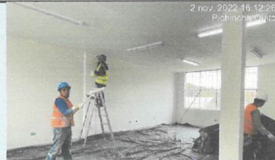
Pintura interior en bloque 27.
