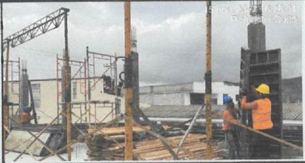
Desencofrado de columnas en eje A - E (3).
