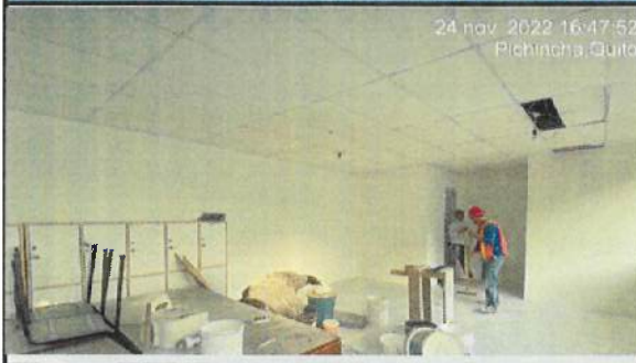
Pintura interior en bloque 16.
