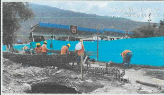
Amarre de columnas de hierro (7 columnas)
