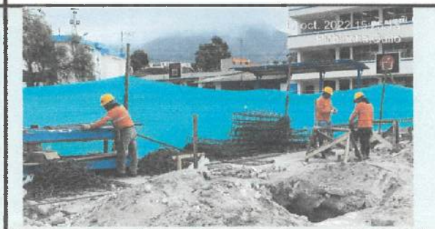
Corte y figurado y armado de columnas C3.
