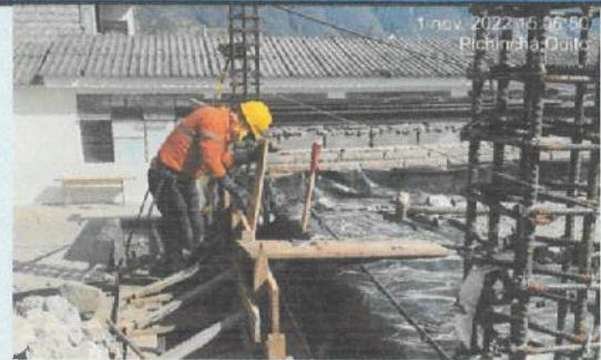
Encofrado y fundición de ciclópeo en eje A.
