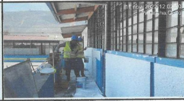
Pintura exterior en bloque 26. ✓
