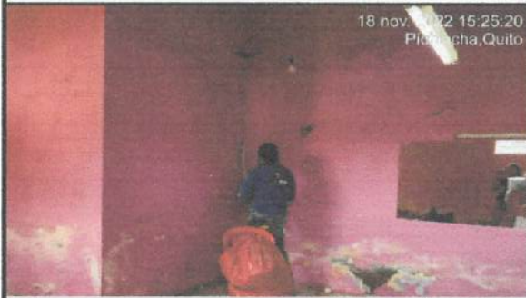
Resane interior en bloque 6.
