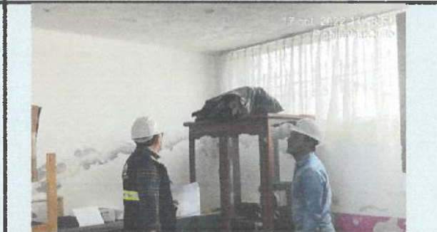
Recorrido con Ing. Eléctrico para colocación de cajas de TDP y tomacorrientes.
