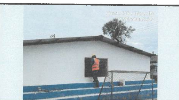
Empaste exterior de etapa 1. Bloque 34
