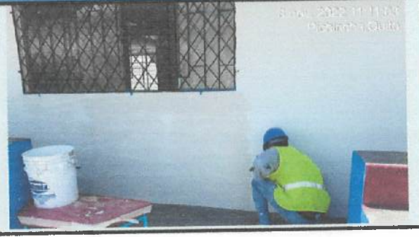
Empaste exterior en bloque 26, segunda capa.
