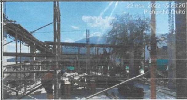
Encofrado de vigas en eje G' - M.
