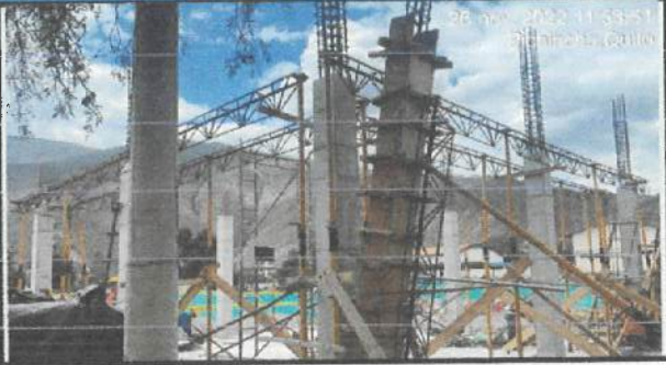
Encofrado de vigas en eje K - M (4 - 5 - 6) en bloque 19 aulas nuevas.
