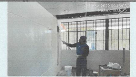
Pintura interior en bloque 32 (primera mano).
