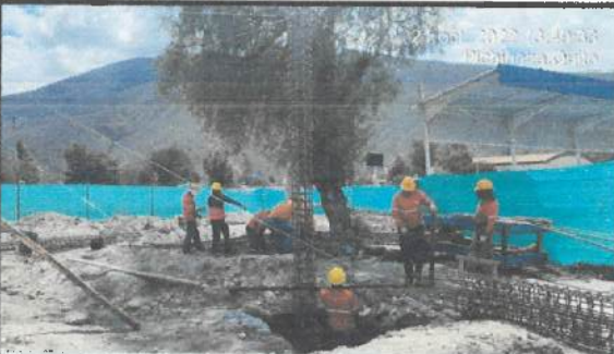
Aplomado de columnas en ejes (G - H - I - J - K - L)
