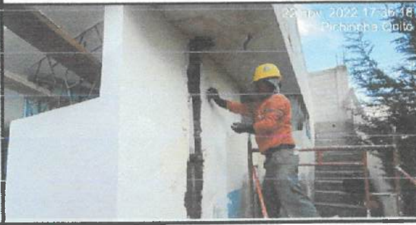
Arraigo de tubería en bloque 33.
