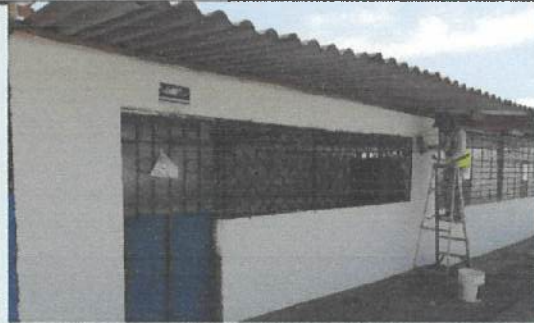
Empaste exterior de etapa 1 en bloque 26
