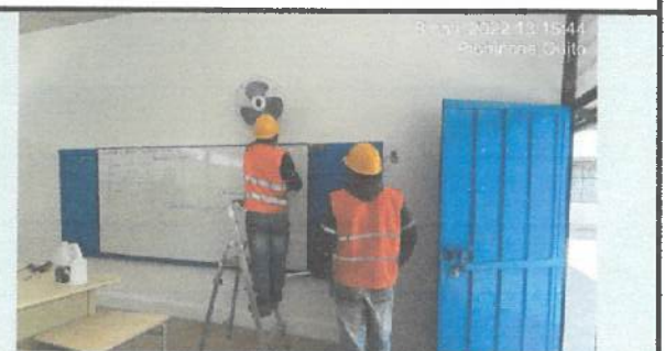
Cambio de piezas de interruptores y tomacorrientes en bloque 21 - 25 - 28.
