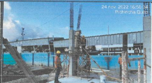
Fundición de columnas en eje K (4 - 6).
