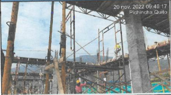
Encofrado de vigas en eje A - G (1 - 2 - 3).
