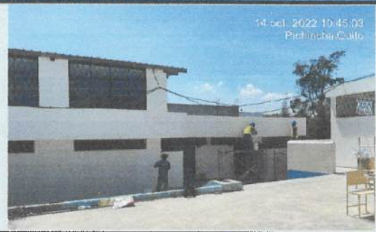
Empaste exterior en bloque etapa 1 ( Bloque 33)
