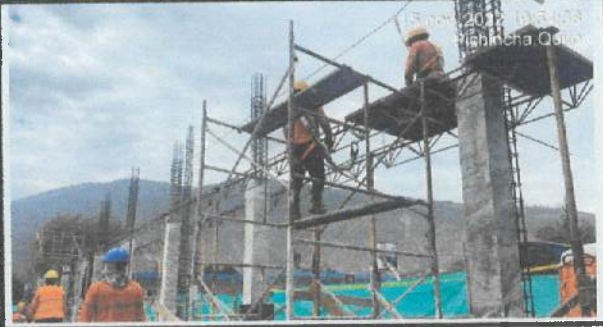
Encofrado de vigas en eje A - G (1 - 2 - 3).
