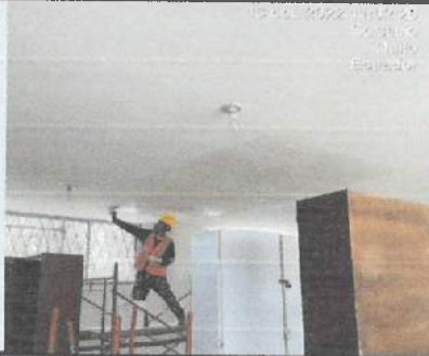
Empaste interior en los bloques 1ra etapa. (Bloque 26 - 28 - 29)
