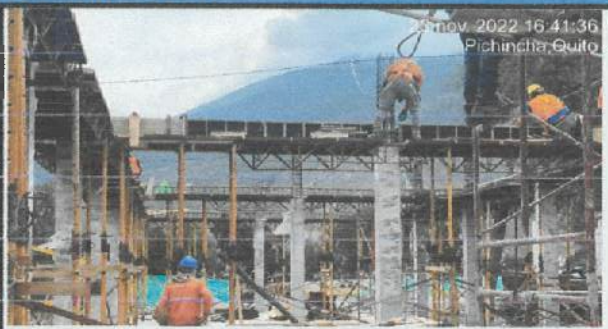
Encofrado de vigas en eje G' - M (1 - 2 - 3).
