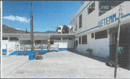
Resane y empaste exterior en bloque etapa 1 ( Bloques 27-1 y 23)
