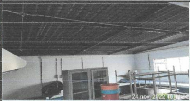
Colocación de tubería para instalaciones eléctricas en bloque 2.
