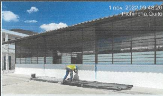
Empaste exterior en bloque 28. (segunda capa).
