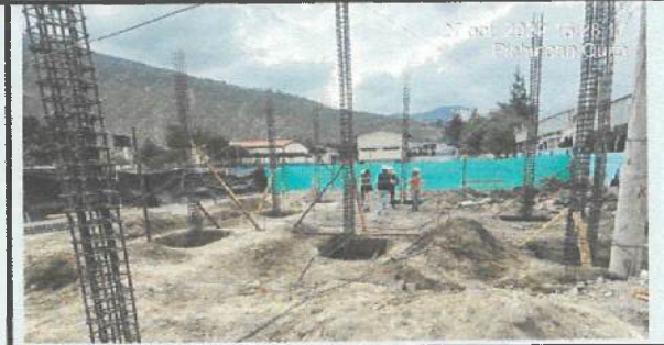
Aplomado de columnas en ejes K - L - M (4 - 5 - 6)
