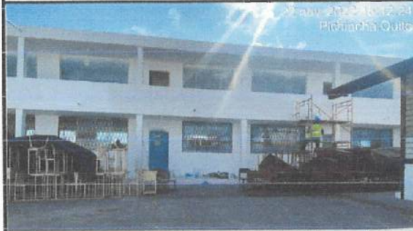
Pintura exterior en bloque 20 - 29.
