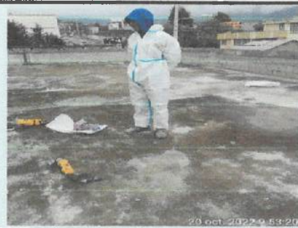
Inician los trabajos de impermeabilización de cubierta en bloque 27-1.
