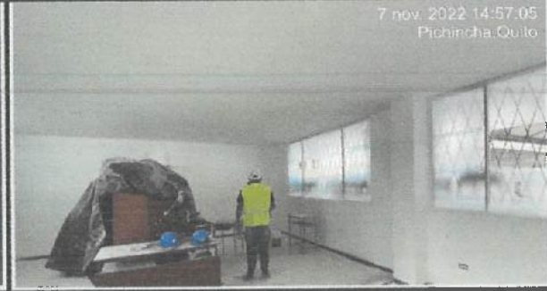
Pintura interior en bloque 29. (segunda mano).
