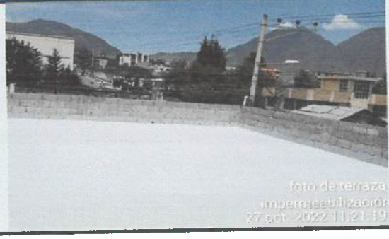
Impermeabilización de cubierta con membrana líquida en bloque en bloque 27.
