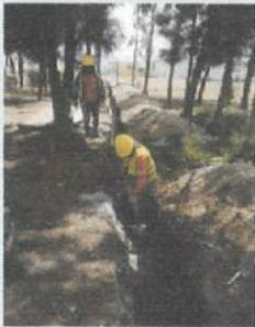
Colocación de cama de arena de 10 cm en la zanja de alcantarillado H.S. ✓
