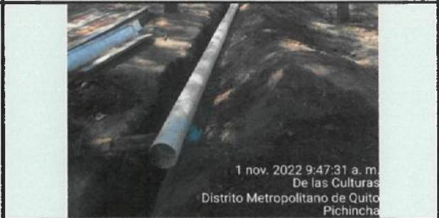
Corrección e instalación de PVC 160mm en alcantarillado ✓
