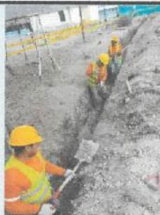
Excavación manual de zanja para tubería a la pendiente de 1,5% ✓
