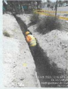
Colocación de cama de arena 10 cm para tubería PVC de alcantarillado sanitario ✓
