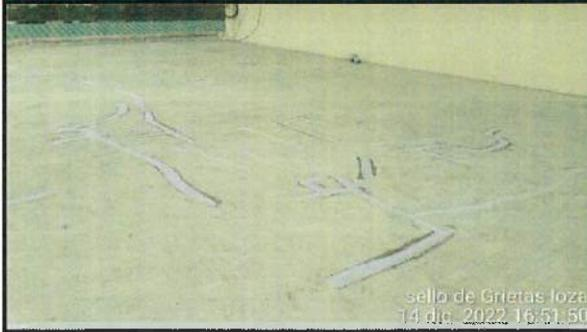
Sellado de grietas par impermeabilización en cubierta de bloque 12.
