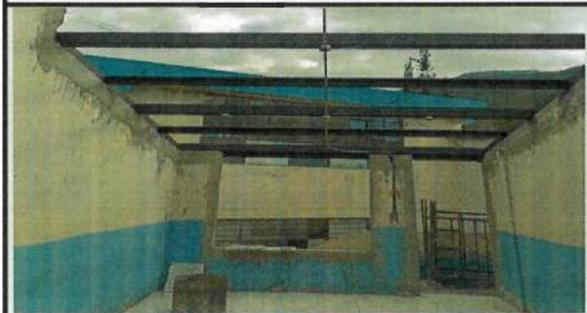
Instalación de estructura metálica de cubierta en bloque 11-15
