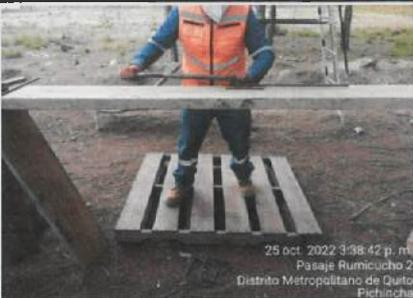
Armado de estribo para el traslape de columnas del pluro de cerramiento
