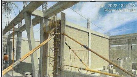
Encofrado de riostras en eje A-M (1-2-3), bloque 19 aulas nuevas.
