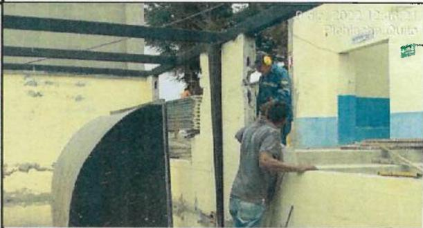
Instalación de estructura metálica en bloque 19 panadería.
