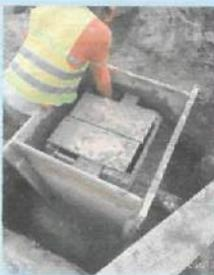
Armado de encofrado a un solo cuerpo para fundir caja de revisión ✓
