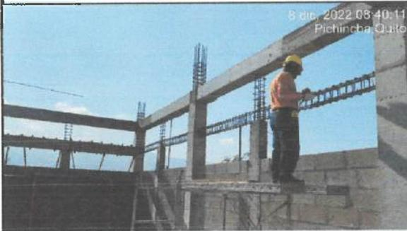
Encofrado de riostras en eje K - L - M (1 - 2 - 3), bloque 19 aulas nuevas. ✓
