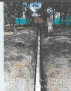
colocación de tubería PVC 160 mm en zanja para alcantarillado sanitario ✓
