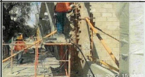
Encofrado de riostras en eje A-M (1-2-3), en bloque 19 aulas nuevas.
