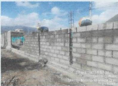
Colocación de bloque en mampostería tramo 1, 2, 3, 4, cerramiento externo ✓
