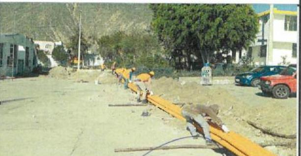
Canalización eléctrica con tubería reforzada
