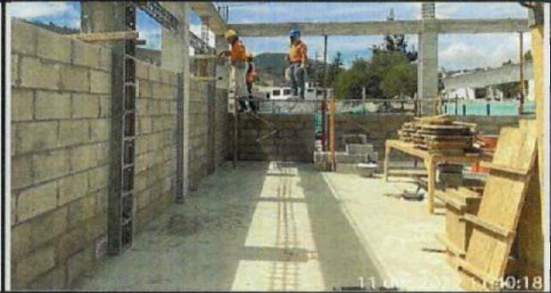
Encofrado de risotras en eje K-M (4-5-6), bloque 19 aulas nuevas.
