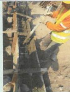
Fundición tramo 6 del cerramiento externo (hormigón ciclópeo y cadena)
