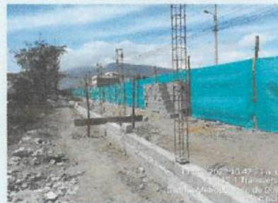
Nivelación de eje previo a la colocación de mampostería en cerramiento ✓
