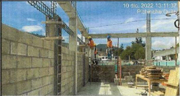
Encofrado de riostras en eje K-M (4-5-6), bloque 19 aulas nuevas.
