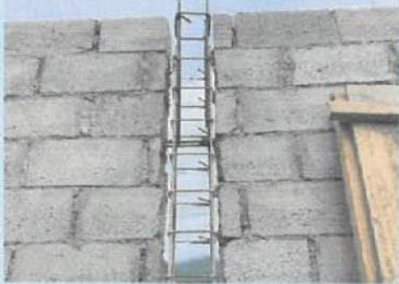
Traslape y colocación de estribo en columnas del muro ✓
