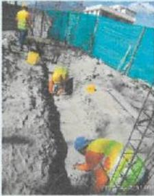
Colocación del armado de parilla ara plintos en los ejes 30, 31, 32 y 33 del cerramiento externo ✓
