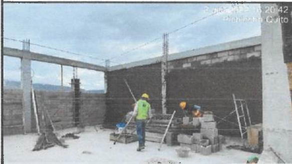
Enlucido vertical interior en paredes en ejes A - M (1 - 2 - 3), bloque 19 aulas nuevas. ✓
