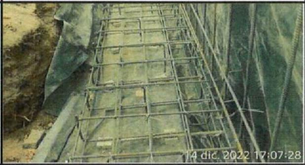
Armado de zapata de muro en bloque 19 aulas nuevas.
