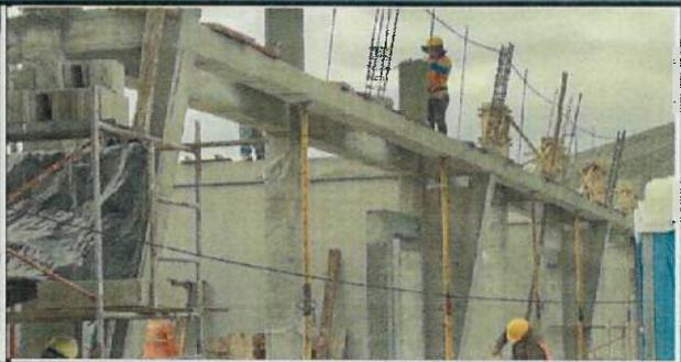
Encofrado de columnas en ejes A-M (1), bloque 19 aulas nuevas.
