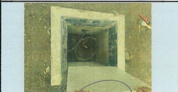
INSTALACIÓN DE ACOMETIDA ELÉCTRICA B9
