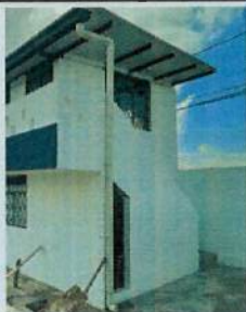
INSTALACIÓN DE BAJANTES PARA AGUA LLUVIA B2
