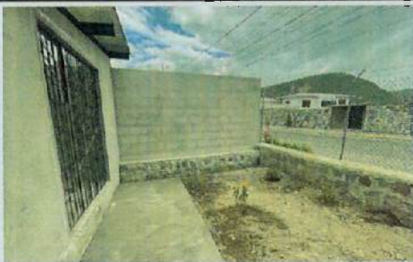
ENLUCIDO INTERIOR Y EXTERIOR COMEDOR B3
