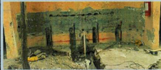
RESANE EN PAREDES B12
