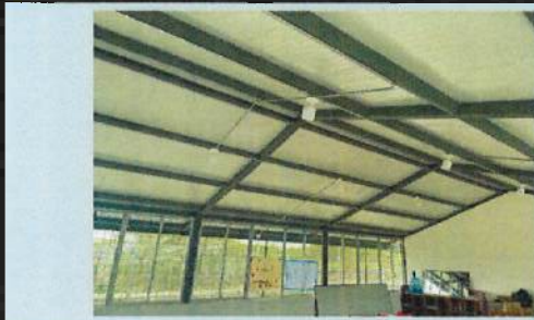
TRABAJOS ELECTRICOS B6
