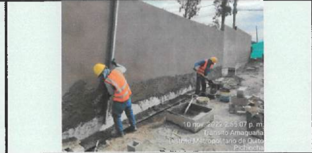
Corrección de nivel de mampostería mediante enlucido, cara exterior
