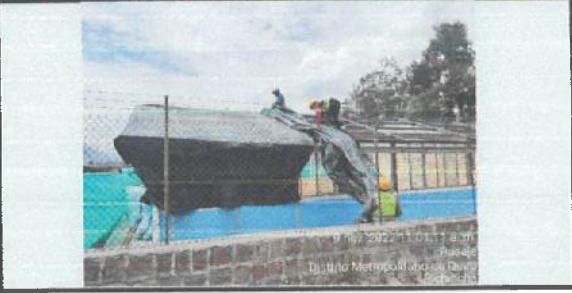
Colocación de plástico en estructura de cubierta, bloque 6 ✓
