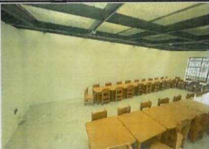
EMPASTE INTERIOR COMEDOR B3
