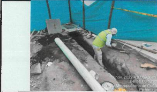
Corrección de fuga y reinstalación de PVC 160mm en alcantarillado
