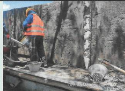
Corrección de nivel de mampostería mediante enlucido, cara interior ✓
