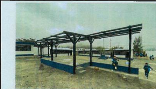
INSTALACIÓN DE ESTRUCTURA METÁLICA PARA PÉRGOLA DE GRADERÍO
