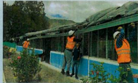
LIMPIEZA DE CANAL DE AGUA LLUVIA B6
