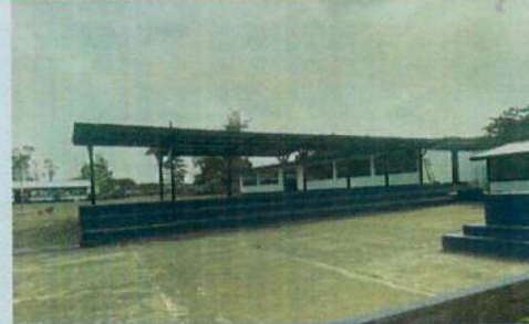
INSTALACIÓN DE CUBIERTA DE STEEL PANEL EN PÉRGOLA GRADERÍO
