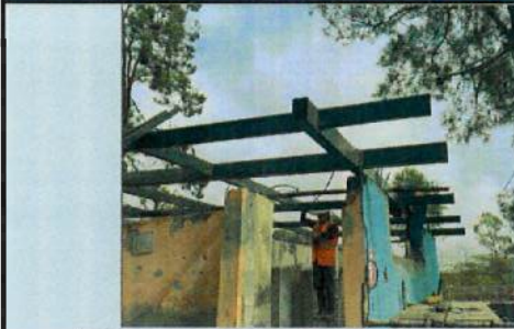
INSTALACIÓN DE ESTRUCTURA METÁLICA PARA CUBIERTA B12
