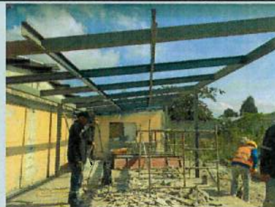
INSTALACIÓN DE ESTRUCTURA METÁLICA PARA PÉRGOLA EN COMEDOR B3
