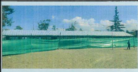
INSTALACIÓN DE CUBIERTA TIPO PANEL SANDWICH B6
