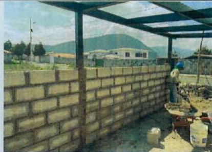
COLOCACIÓN DE MAMPOSTERÍA COMEDOR B3
