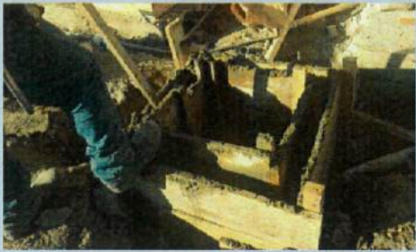
ENCOFRADO DE CAJAS DE REVISIÓN ELÉCTRICA
