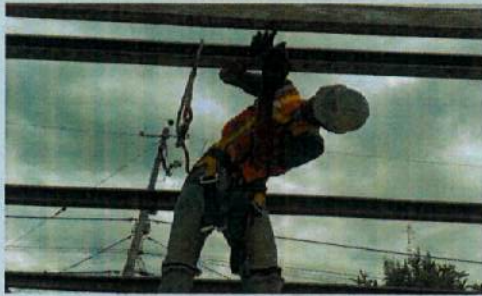
MANTENIMIENTO DE ESTRUCTURA B1, 2
