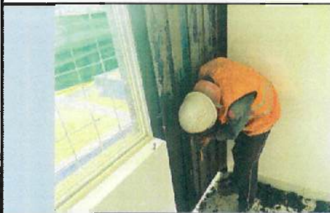
MANTENIMIENTO DE PUERTA B5, B6
