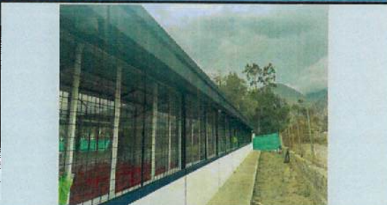
INSTALACIÓN CANAL DE TOLL PARA AGUAS LLUVIAS B6
