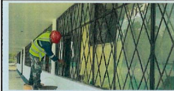
MANTENIMIENTO DE REJAS B4, B5, B6
