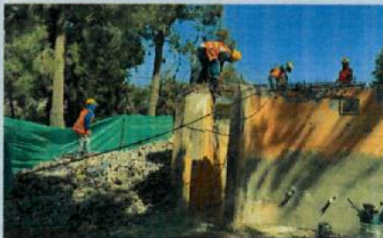
DERROCAMIENTO DE LOSA B12
