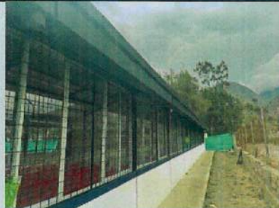
INSTALACIÓN CANAL DE TOL PARA AGUAS LLUVIAS B6
