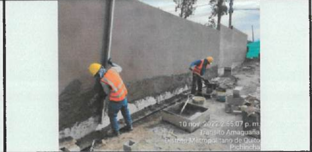
Corrección de nivel de mampostería de cerramiento mediante enlucido, cara exterior e interior
