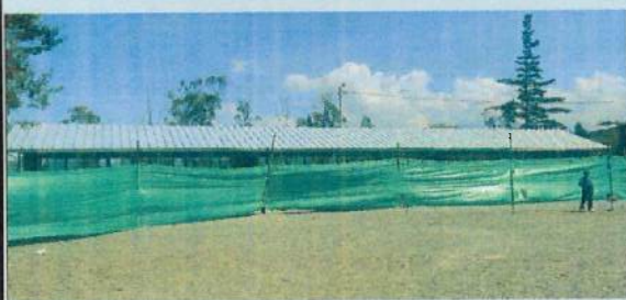
INSTALACIÓN DE CUBIERTA TIPO PANEL SANDWICH B6
