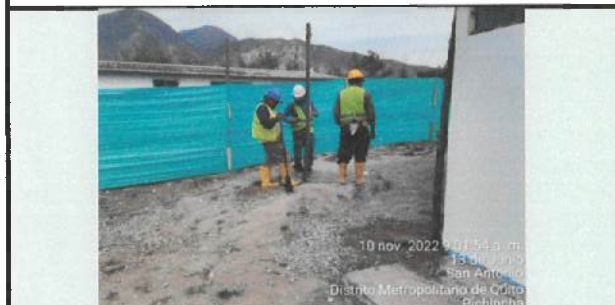
Colocación de yute en perímetro de bloque 4
