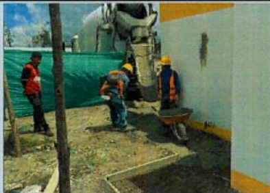
FUNDICIÓN DE CONTRAPISO B4
