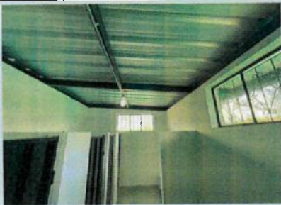
INSTALACIÓN DE ACOMETIDA ELÉCTRICA B12
