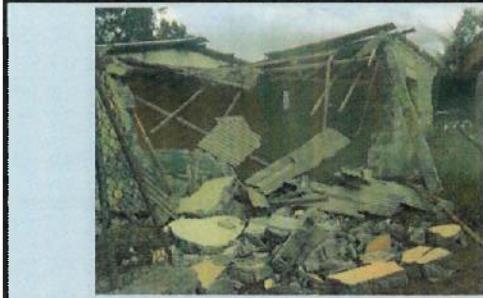
DERROCADO DE MAMPOSTERÍA B3 COMEDOR Y CERRAMIENTO
