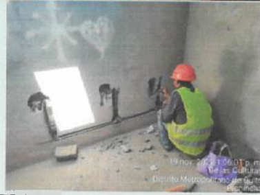
Instalación tubería hidrosanitaria bloque 11 ✓
