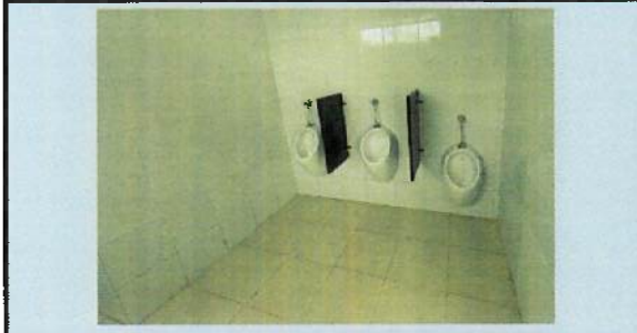
INSTALACIÓN DE PUERTAS DE TOL PARA DIVISIÓN EN URINARIO B10
