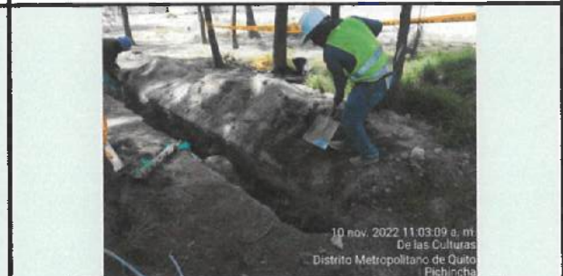
Relleño y compactación de zanja de alcantarillado
