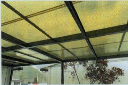
INSTALACIÓN DE POLICARBONATO PÉRGOLA JARDÍN INICIAL
