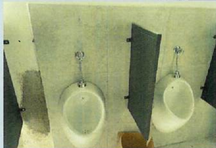
INSTALACIÓN DE URINARIOS Y ACCESORIOS EN B12
