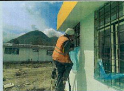
MANTENIMIENTO DE REJAS B4
