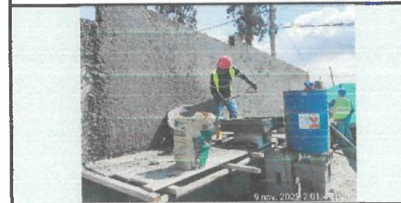
Corrección de nivel de mampostería mediante enlucido, cara interior y exterior ✓
