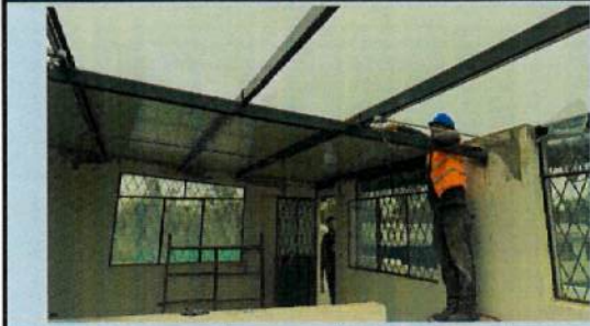
INSTALACIÓN DE CUBIERTA TIPO PANEL SANDWICH B2
