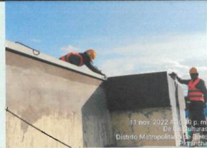
Enlucido de antepecho de losa de cubierta, bloque 4 ✓
