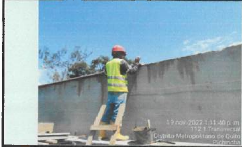
Colocación de alfeizer en cerramiento ✓
