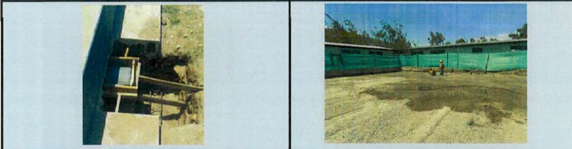
RELLENO Y COMPACTACIÓN CON MATERIAL DE MEJORAMIENTO EN CANCHA DE JARDÍN INICIAL
