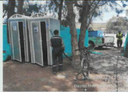
Desalojo de desechos de baterías sanitarias portátiles con camión vacuum ✓
