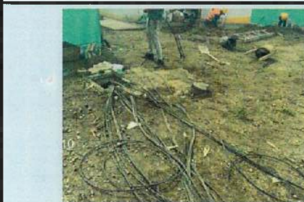
TRABAJOS ELÉCTRICOS B7, B8, B9
