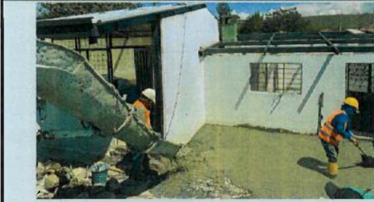
FUNDICIÓN DE CONTRAPISO B1
