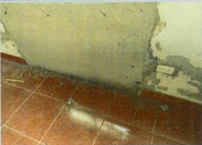
TRABAJOS ELÉCTRICOS B3, B12
