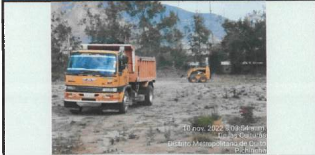
Movilización de arcana fina hacia cara exterior de cerramiento para enlucido
