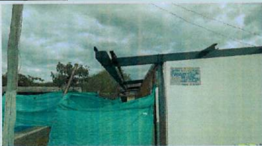
INSTALACIÓN DE CANAL DE TOL PARA AGUAS LLUVIAS B1, B3
