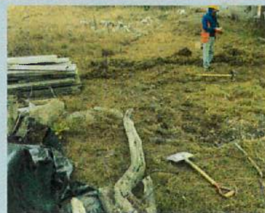
EXCAVACIÓN PARA CUBETO
