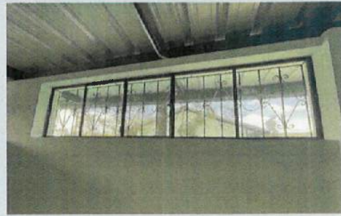
INSTALACIÓN DE VIDRIO EN B12
