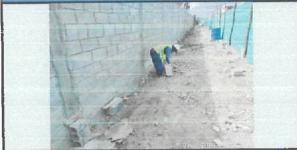
Limpieza de escombros en zona exterior de cerramiento ✓
