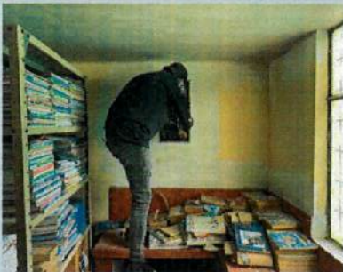
TRABAJOS ELÉCTRICOS B4
