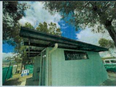
INSTALACIÓN DE CANAL DE TOL PARA AGUAS LLUVIAS B12
