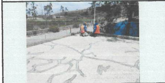
Sellado de grietas con material epóxico y cinta, bloque 5, 12 ✓
