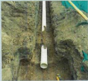
INSTALACIÓN DE TUBERÍA DE 110MM PARA DESAGÜE EN SUMIDROS B1
