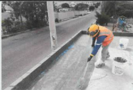
Recubrimiento con membrana impermeabilizante bloque 11 ✓
