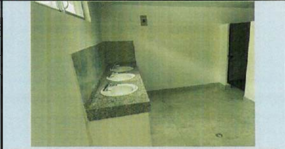
INSTALACIÓN DE LLAVE PARA LAVAMANOS EN B10, B11
