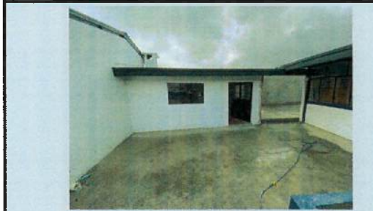
INSTALACIÓN DE CANAL DE TOL PARA AGUAS LLUVIAS B3
