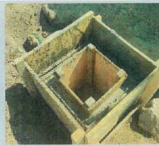
FUNDICIÓN DE CAJAS DE REVISIÓN SANITARIA JARDÍN INICIAL
