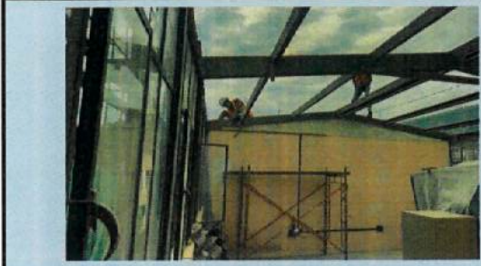
MANTENIMIENTO DE ESTRUCTURA B1
