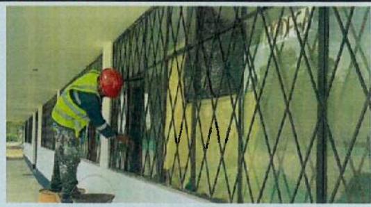
MANTENIMIENTO DE REJAS B5
