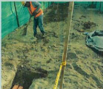
RELLENO Y COMPACTACIÓN DE ZANJA PARA CANALIZACIÓN ELÉCTRICA
