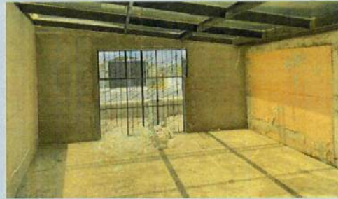
MASILLADO EN CONTRAPISO COMEDOR B3
