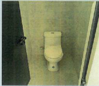
INSTALACIÓN DE INODOROS Y ACCESORIOS EN B12, B4
