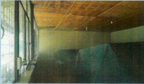
DESARMADO DE CUBIERTA DE MADERA B3
