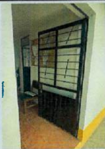
MANTENIMIENTO DE PUERTA B4
