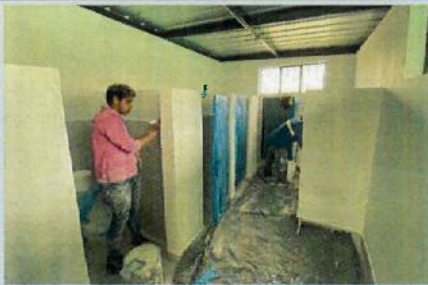
PINTURA INTERIOR B12
