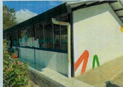
INSTALACIÓN DE BAJANTES PARA AGUA LLUVIA B1
