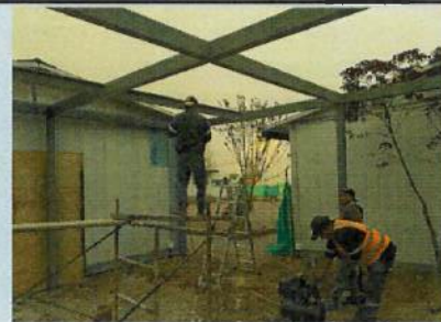
INSTALACIÓN DE ESTRUCTURA METÁLICA PARA PÉRGOLA DE JARDÍN INICIAL
