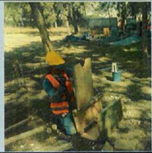
ENCOFRADO DE CAJAS DE REVISIÓN ELÉCTRICA
