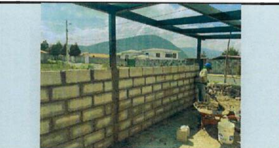
COLOCACIÓN DE MAMPOSTERÍA COMEDOR B3
