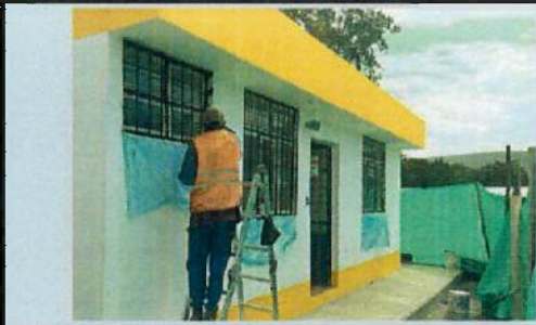
MANTENIMIENTO DE REJAS B4, B6
