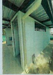
INSTALACIÓN DE BAJANTES DE AGUA LLUVIA B12
