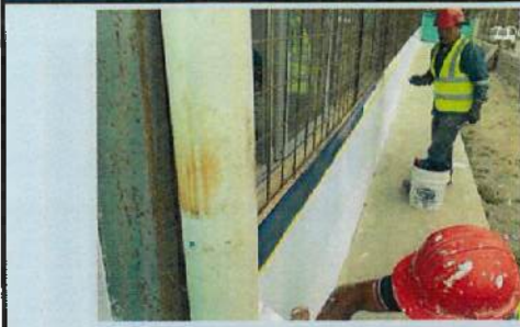
PINTURA INTERIOR B6
