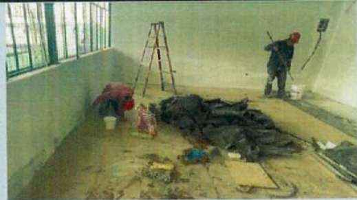
PINTURA INTERIOR B3 AULA Y BAR
