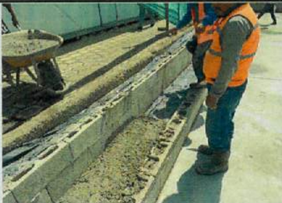
MASILLADO DE EN GRADERÍO CANCHA JARDÍN INICIAL
