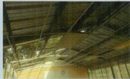
DESARMADO DE CIELO FALSO B6
