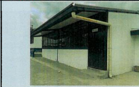
INSTALACIÓN DE BAJANTE PARA AGUAS LLUVIAS B3
