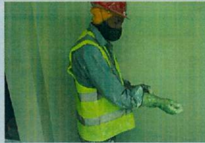
PINTURA INTERIOR B11
