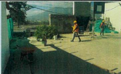
COLOCACIÓN DE MAMPOSTERÍA EN INGRESO PRINCIPAL, CERRAMIENTO ENTRE BLOQUES 3 Y 5, 2 Y 11
