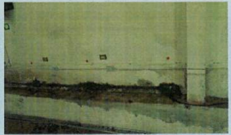
RESANE EN PAREDES INTERIORES B2
