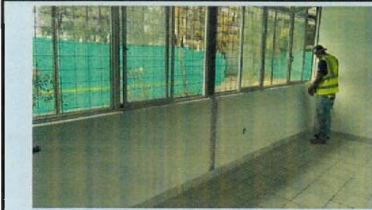
PINTURA INTERIOR B6
