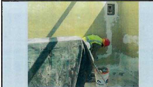
INSTALACIÓN DE CENTRO DE CARGA DE 8 ESPACIOS B3
