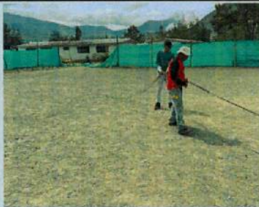
INSTALACIÓN DE ACOMETIDA ELÉCTRICA B5
