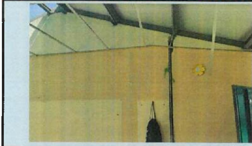
RESANE EN PAREDES B6
