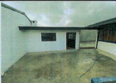
INSTALACIÓN DE CANAL DE TOL EN COMEDOR B3
