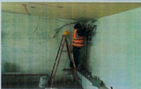
PICADO EN PAREDES PARA INSTALACIONES ELÉCTRICAS B2
