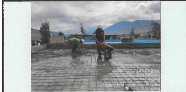
Masillado de losa de cubierta bloque 4 para corrección de pendiente
