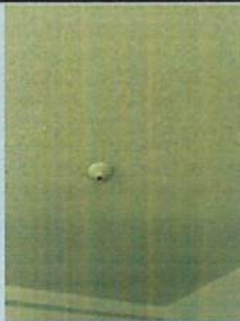
PINTURA INTERIOR B10, B11
