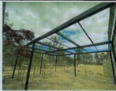
INSTALACIÓN DE ESTRUCTURA METÁLICA PARA PÉRGOLA DE JARDÍN INICIAL
