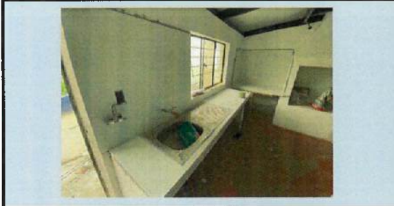
INSTALACIÓN DE LLAVE PARA FREGADERO B3
