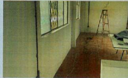
TRABAJOS ELÉCTRICOS B2
