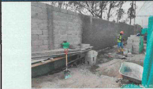
Corrección de nivel de mampostería en cerramiento mediante enlucido, cara exterior e interior ✓
