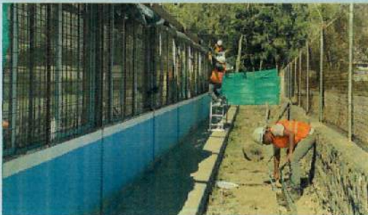
MANTENIMIENTO DE ESTRUCTURA B6
