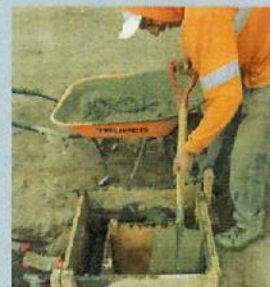
FUNDICIÓN DE CAJAS DE REVISIÓN ELÉCTRICA
