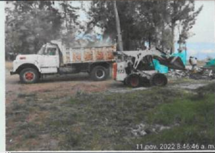
Desalojo de escombros de centro de acopio ✓
