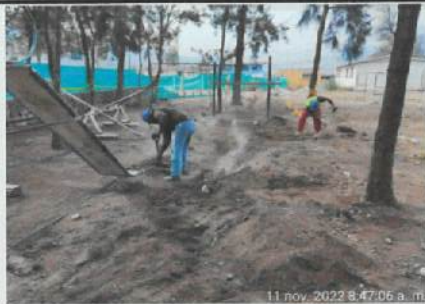
Relleno y compactación de zanja de alcantarillado, 2da capa ✓
