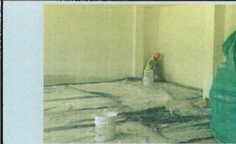
PINTURA INTERIOR B5
