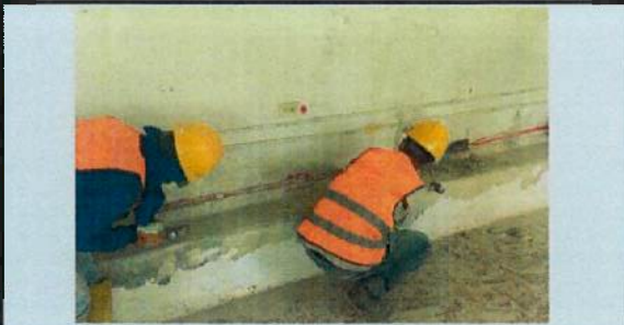
RESANE EN PAREDES INTERIORES B3
