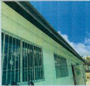
INSTALACIÓN DE CANAL DE TOL PARA AGUAS LLUVIAS B7, B8, B9
