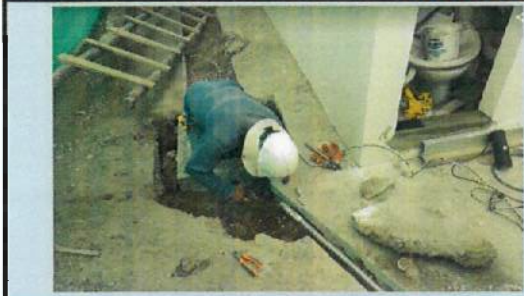
INSTALACIÓN DE ACOMETIDA ELÉCTRICA B11
