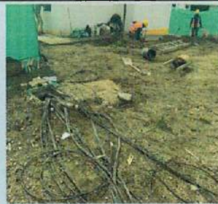
INSTALACIÓN DE ACOMETIDA ELÉCTRICA B10
