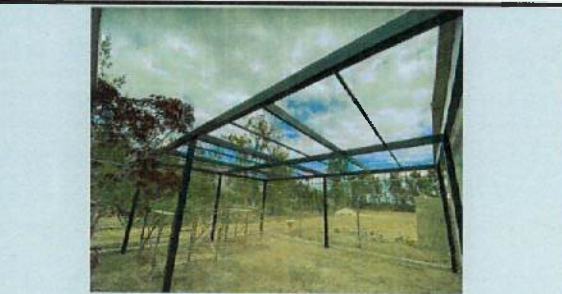
INSTALACIÓN DE ESTRUCTURA METÁLICA PARA PÉRGOLA DE JARDÍN INICIAL
