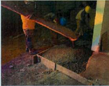
ENCOFRADO DE VEREDA EN B12
