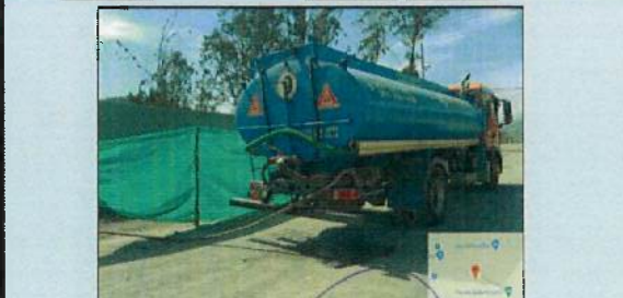
CONTROL DE POLVO MEDIANTE RIEGO DE AGUA CON TANQUERO
