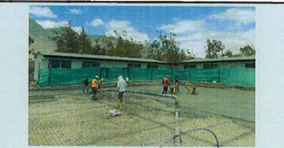
FUNDICIÓN DE CONTRAPISO PARA CANCHA INICIAL
