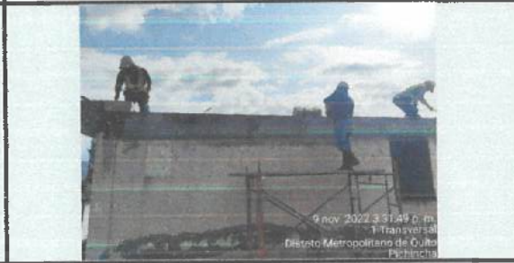
Colocación de mampostería en perímetro de losa de cubierta, bloque 4 ✓
