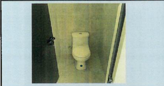
INSTALACIÓN DE INODOROS Y ACCESORIOS EN B10, B11
