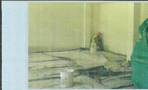
PINTURA INTERIOR B5
