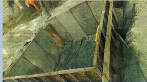
ENCOFRADO PREVIO A FUNDICIÓN DE CUBETO
