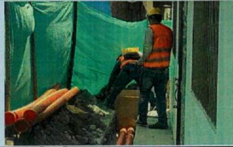
ENCOFRADO DE CAJAS DE REVISIÓN ELÉCTRICA
