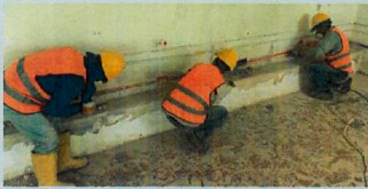
PICADO EN PAREDES PARA INSTALACIONES ELÉCTRICAS B1, 2, 4
