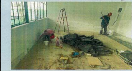
PINTURA INTERIOR B3 AULA Y BAR
