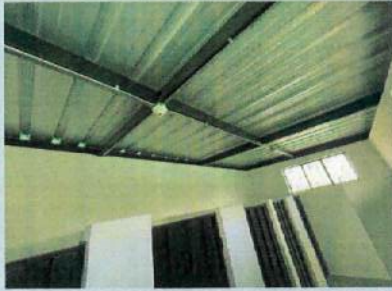
INSTALACIÓN DE CUBIERTA DE STEEL PANEL B12
