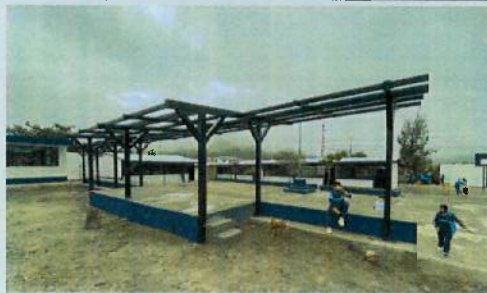
INSTALACIÓN DE ESTRUCTURA METÁLICA PARA PÉRGOLA DE GRADERÍO
