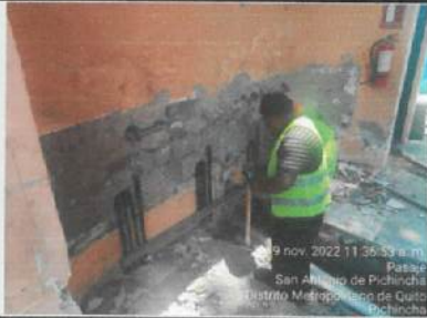
Tizado instalaciones hidrosanitarias bloque 12 ✓
