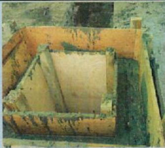
FUNDICIÓN DE CAJAS DE REVISIÓN ELÉCTRICA
