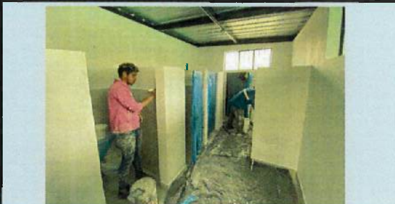
PINTURA INTERIOR B12
