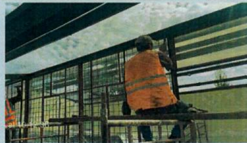
MANTENIMIENTO DE REJAS B3
