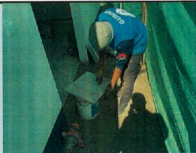
INSTALACIÓN DE CERÁMICA Y BARREDEDAS B11
