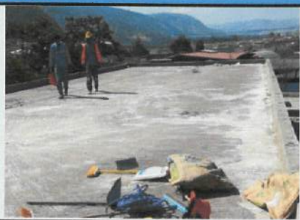
Pulido de losas y lavado previo a la impermeabilización bloque 4
