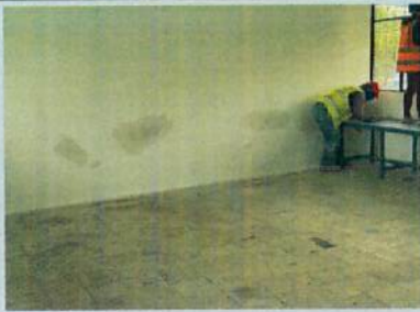
PINTURA INTERIOR B1
