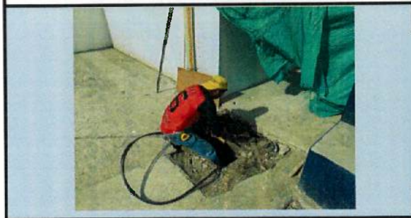
INSTALACIÓN DE ACOMETIDA ELÉCTRICA B2
