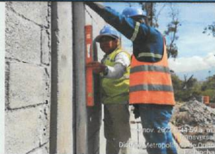
Corrección de nivel de mampostería mediante enlucido, cara interior ✓
