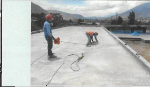
Limpieza y pulido de losa de cubierta en bloque 5, 10, 11 ✓
