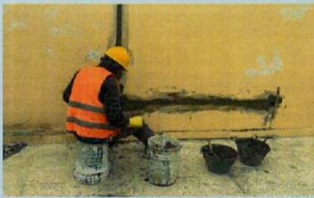
RESANE EN PAREDES INTERIORES B1
