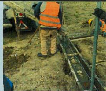
REPLANTEO PREVIO A EXCAVACIÓN PARA CERRAMIENTO METÁLICO EN JARDÍN INICIAL
