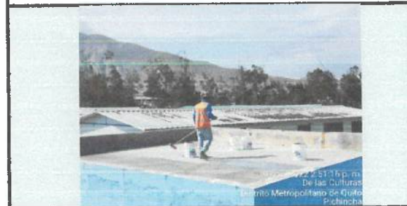
Colocación de membrana impermeabilizante, bloque 10, 5 ✓
