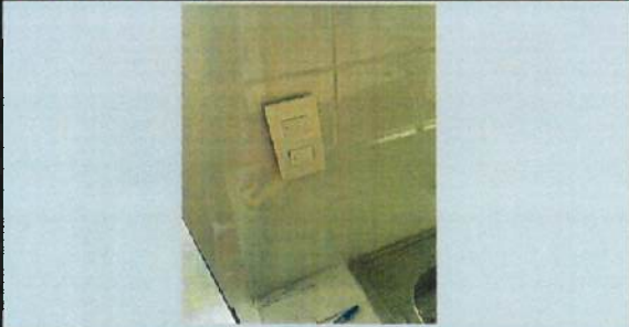
TRABAJOS ELÉCTRICOS B3
