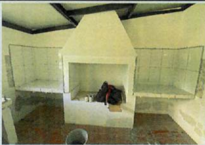
INSTALACIÓN DE CERÁMICA EN MESÓN Y PAREDES B3
