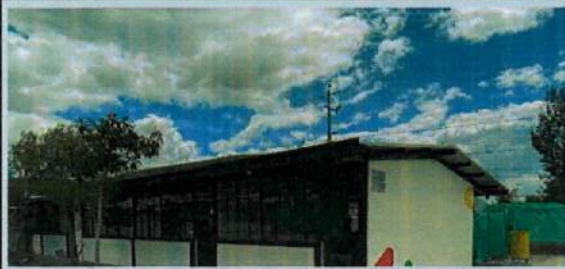
INSTALACIÓN DE CUBIERTA TIPO PANEL SANDWICH B1
