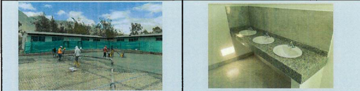
COLOCACIÓN DE MALLA ELECTROSOLDADA PREVIO A FUNDICIÓN DE CONTRAPISO EN CANCHA DE JARDÍN INICIAL
