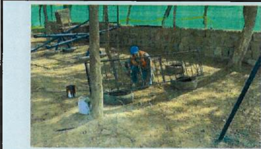
MANTENIMIENTO DE REJA DE COMEDOR B3
