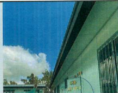
INSTALACIÓN DE CANAL DE TOL PARA AGUAS LLUVIAS B7, B8, B9
