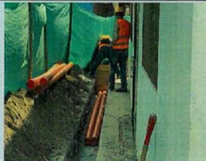
COLOCACIÓN DE TUBERÍA DE 110MM PARA CANALIZACIÓN ELÉCTRICA
