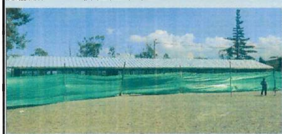
INSTALACIÓN DE CUBIERTA TIPO PANEL SANDWICH B6
