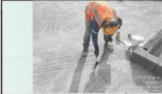
Sellado de grietas en losa de cubierta bloque 5 ✓
