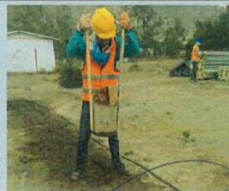
RELLENO Y COMPACTACIÓN DE ZANJA PARA CANALIZACIÓN ELÉCTRICA
