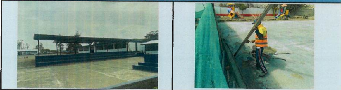
INSTALACIÓN DE CUBIERTA DE STEEL PANEL EN PÉRGOLA GRADERÍO
