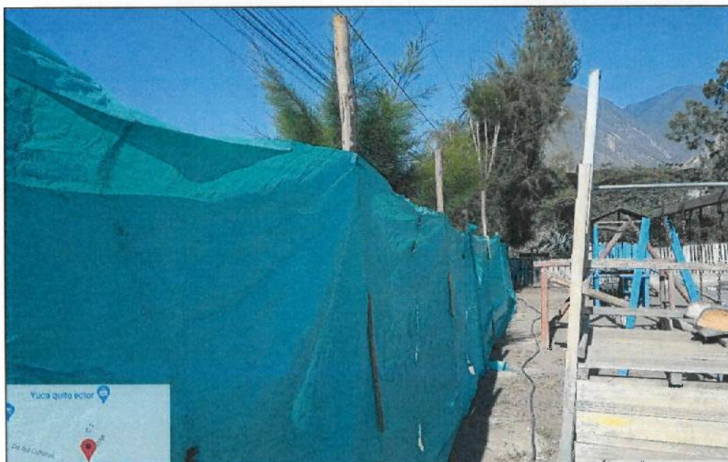
Frentes de trabajo cubiertos mediante lonas registro fotográfico
