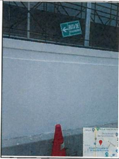
Señalética implementada en obra
