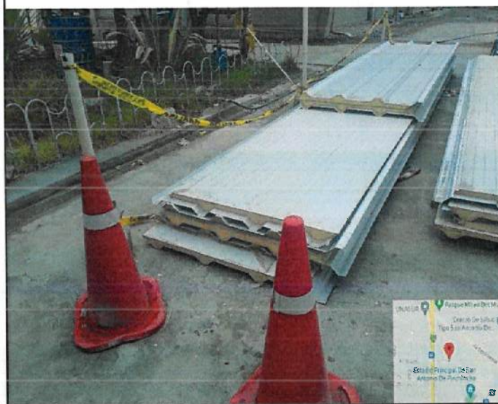
Colocación de cinta peligro para prevención y conos
