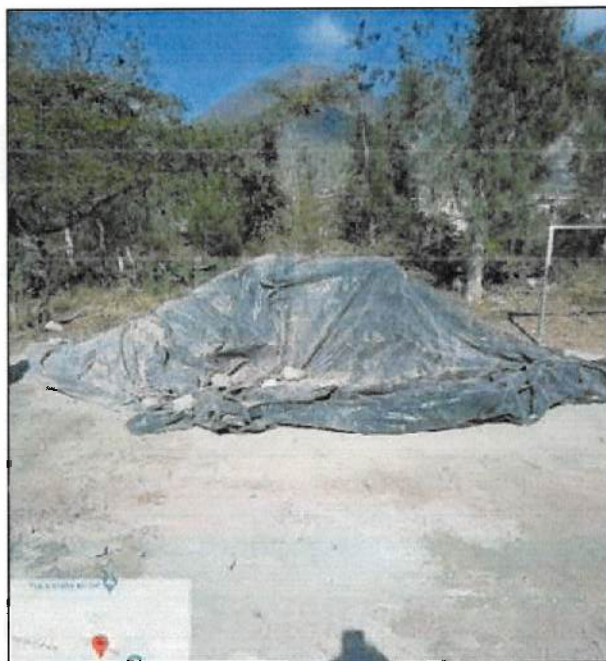
Disposición de espacio para provisión de materiales registro fotográfico.
