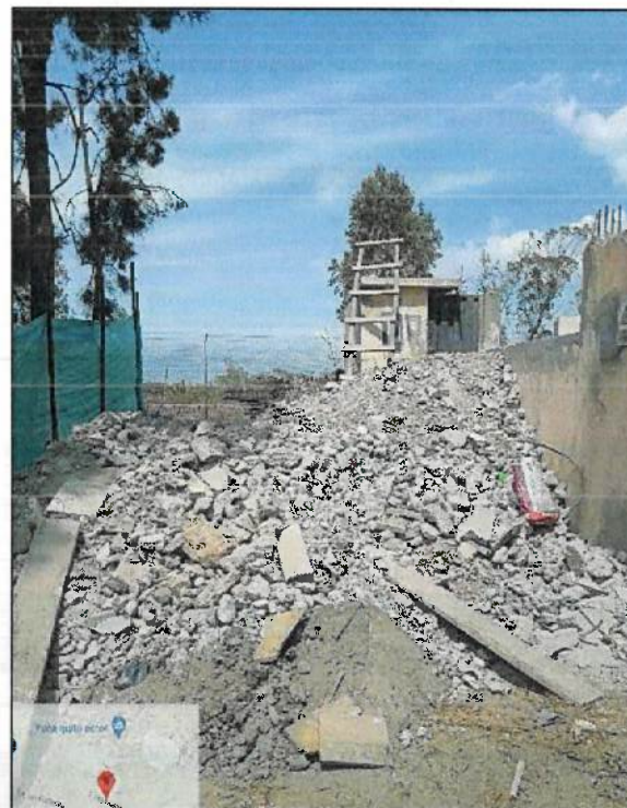
Escombrera temporal para desechos de construcción registro fotográfico.
