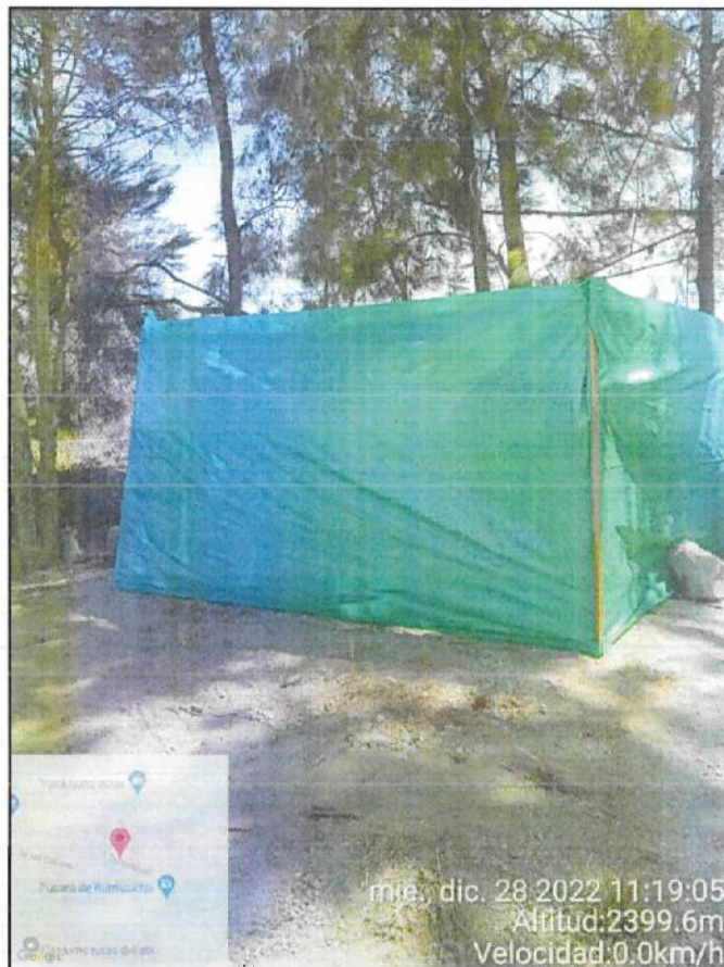
Disposición de espacio restringido para manejo de combustible registro fotográfico 28 diciembre 2022
