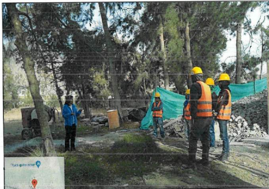
Charla de riesgos laborales en el trabajo. Registro fotográfico
