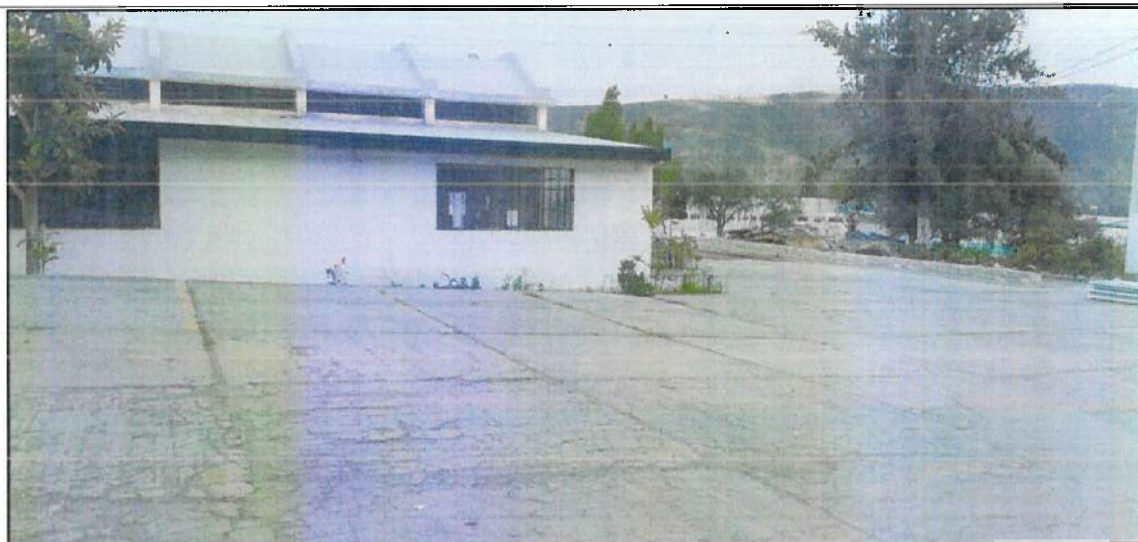
Se retiraron del área techos de eternit que habían sido retirados de las infraestructuras
