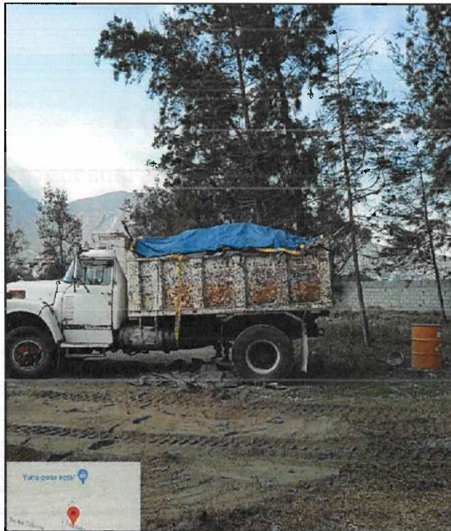
Transporte de escombros tapado con lona registro fotográfico
