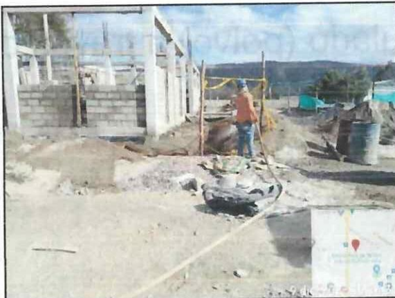
Aspersión de agua a través de manguera del tanquero
