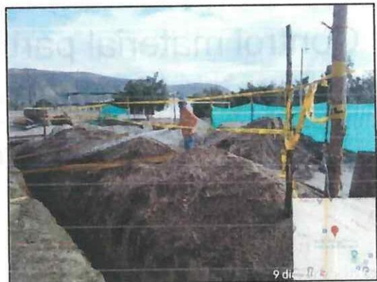
Aspersión de agua para control de polvo realizada por personal de obra
