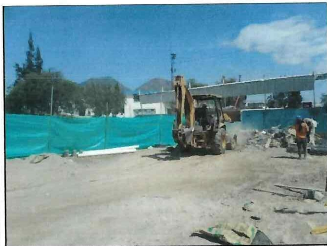
Colocación de lonas alrededor del perímetro de la obra
