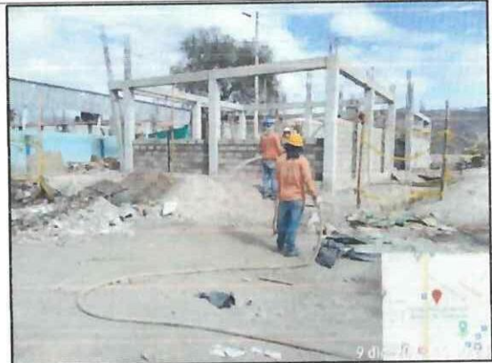
Aspersión de agua para control de polvo a través de un tanquero
