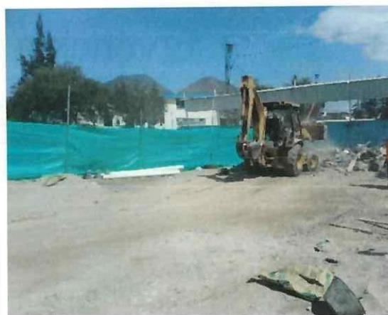
Colocación de lonas alrededor del perímetro de la obra
