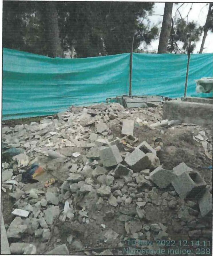
Escombrera temporal para desechos de construcción registro fotográfico Correspondiente al 10 de noviembre del 2022.
