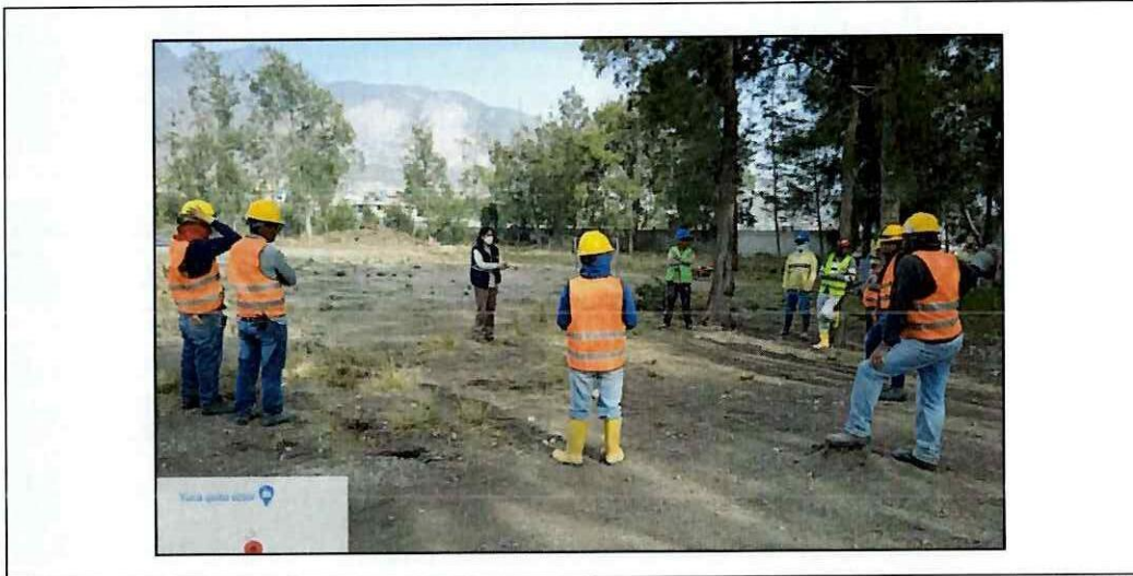
Difusión Mecanismo Buzón de Quejas y Reclamos al personal de la obra registro fotográfico correspondiente.
