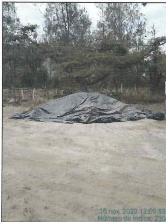
Disposición de espacio para provisión de materiales registro fotográfico 10 de noviembre 2022
