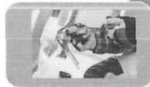
Instalación de tomacorrientes
