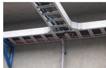
Se propone un sistema de canaleta principal anclado a las vigas de entresijos y cubierto por el cielo falso, por la cual se llevaran los alimentadores a cada uno de los tableros secundarios
