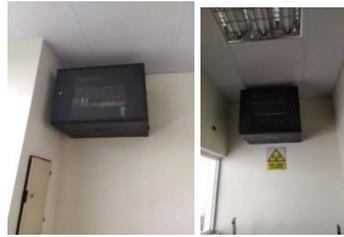
De acuerdo con la nueva distribución interior, se colocarán racks individuales en los laboratorios y un rack centralizado para el resto de puntos de datos, se tomará en cuenta las recomendaciones del INPC, para el tendido del cableado y ductería.
