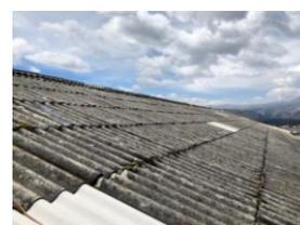
Con relación a la cubierta y considerando su estado actual los trabajos propuestos son: remplazo de piezas de madera en mal estado, colocación de pletinas para rigidizar la estructura, tratamiento ignifugo, cambio de planchas de fibrocemento
