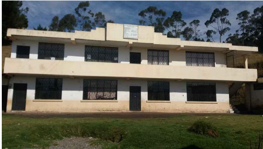
FACHADA - BLOQUE DOS PISOS
