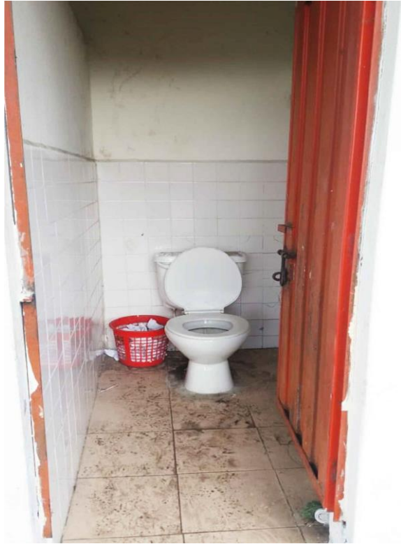
SERVICIO HIGIÉNICO - VISTA INTERIOR
