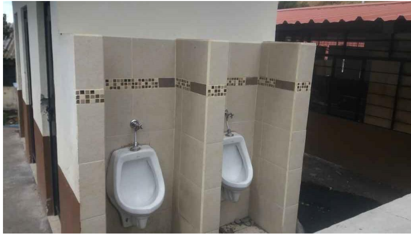
VISTA LATERAL - BATERÍA DE SERVICIOS HIGIÉNICOS (POSTERIOR AL BLOQUE DE 6 AULAS)
