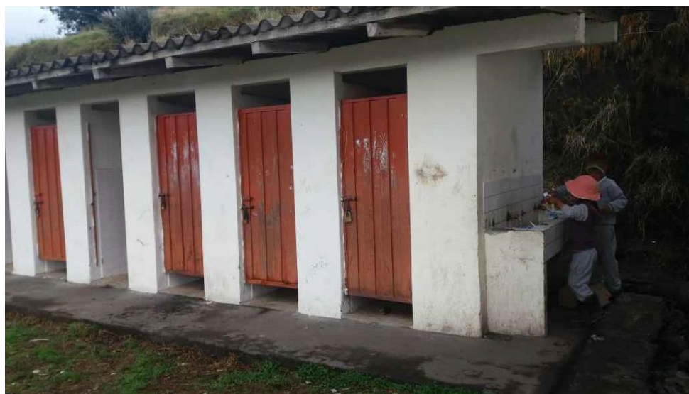
FACHADA - BATERÍA DE SERVICIOS HIGIÉNICOS (JUNTO A EDIFICACIÓN DE DOS AULAS)
