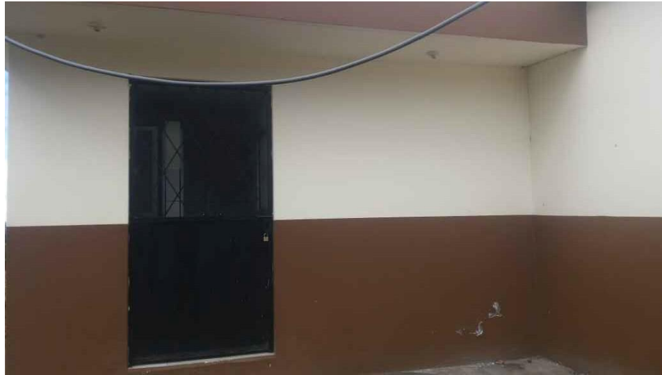
BATERÍA DE SERVICIOS HIGIÉNICOS (JUNTO A LA EDIFICACIÓN PARA ADMINISTRACIÓN)
