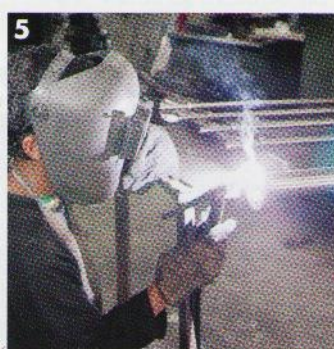
Colocación de tapas y bridas en los extremos.
