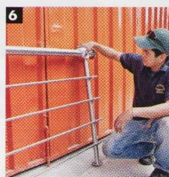
Limpieza (con agua y jabón o usando vaselina líquida) y acabado del pasamano.
