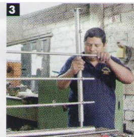
Colocación de los anillos o acoples horizontales.
