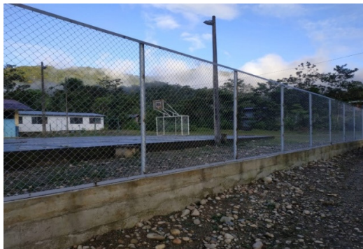
Imagen: CECIB YAWINTS, ubicado en la Comunidad de Míazi, se construyó el cerramiento de perimetral de la Institución, para mejorar la seguridad de los estudiantes y evitar que agentes extraños invadan áreas escolares.
