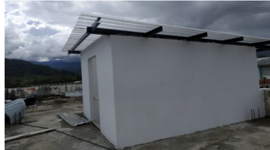
Imagen: La Escuela Héroes del Cóndor ubicada en la Ciudad de Paquisha, se ha atendido con el adecentamiento de la infraestructura, uno de los rubros más importantes fue la tapa gradas de la circulación vertical de la Institución.
