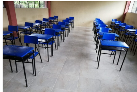
Imagen: Se muestra como quedaron las aulas después de haber atendido el requerimiento del Colegio de Bachillerato Zumbi, en la cual se colocó material cerámico de alto tráfico para evitar polvo en las áreas donde se imparte clases.
