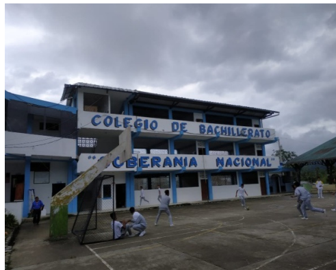
Imagen: Colegio Soberanía Nacional se benefició con el mantenimiento básico correctivo y adecuación de la infraestructura, se realizó colocación de techos, pisos, pasamanos, entre otros.
