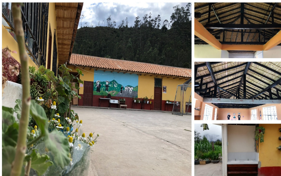
Mantenimiento de cubiertas tradicionales
