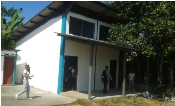
Mantenimiento a baterías sanitarias; retiro y reposición de mallas anti mosquito.
