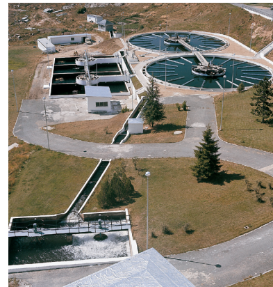
Figura 13. Planta depuradora de aguas residuales. En este tipo de instalaciones se combinan las técnicas de decantación y filtración en el proceso de depurado de las aguas.
