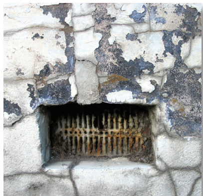
Pared corroída por la lluvia ácida.
